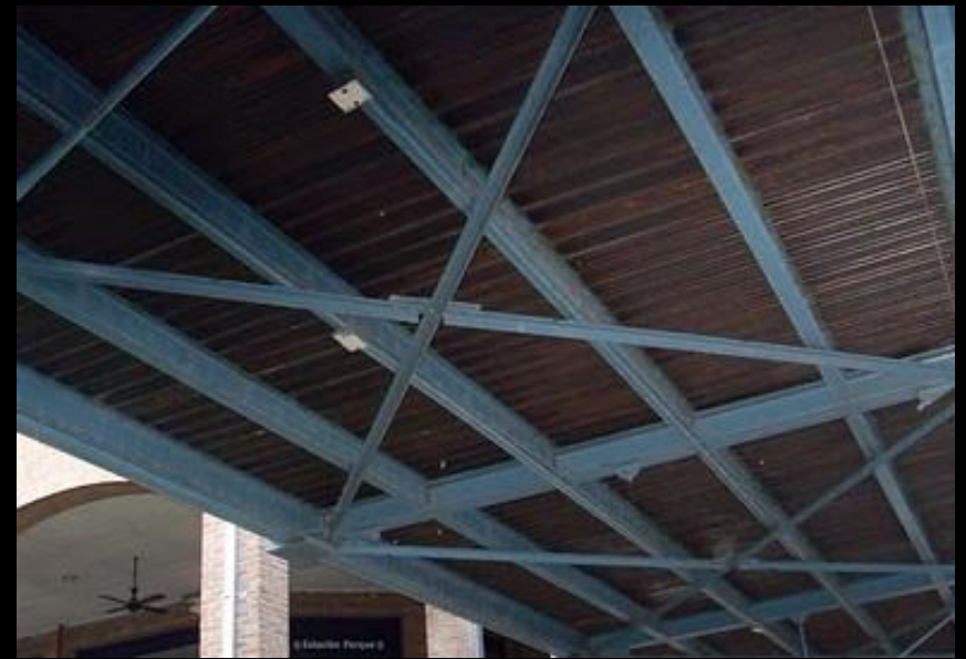
ARRIOSTRAMIENTO DE CUBIERTA CON CRUCES DE SAN ANDRES
