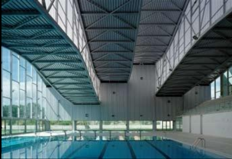
ARRIOSTRAMIENTO DE CUBIERTA CON TRIANGULACION K
