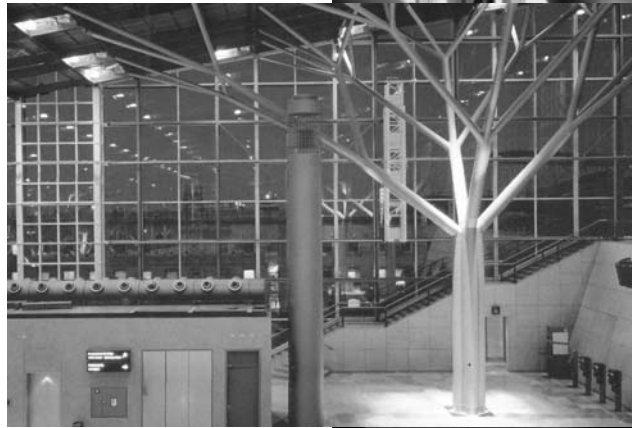
FOTO No. 4. Ramificaciones de la estructura del vestíbulo aeropuerto Stuttgart
