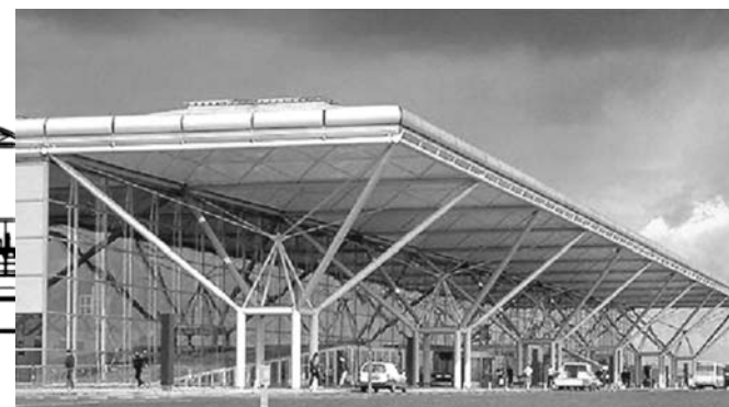
FOTO No. 1 . Fachada aeropuerto Stansted
