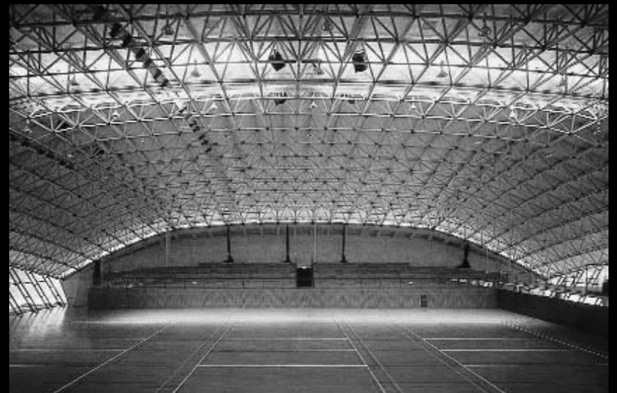
SUPERFICIE DE DOBLE CURVATURA CONFORMADA POR RETICULADO DE DOS CAPAS
