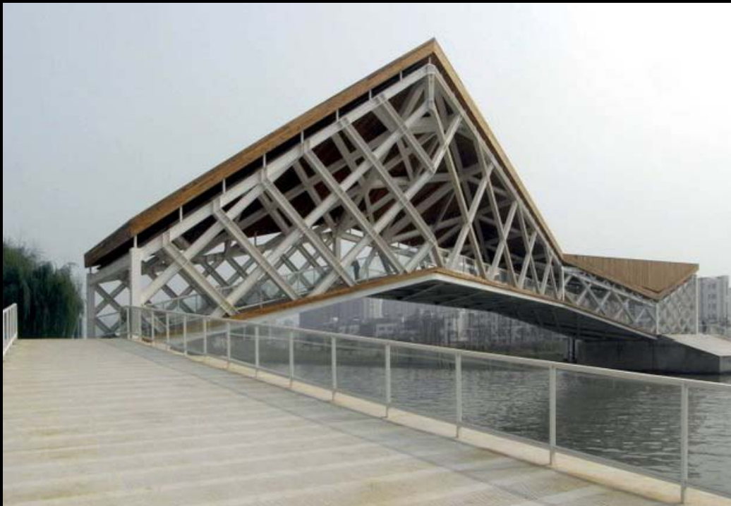
PASARELA PEATONAL SOBRE EL RIO DIANPU Shangai, 2008 - Ing. Pedro Pablo Arroyo
