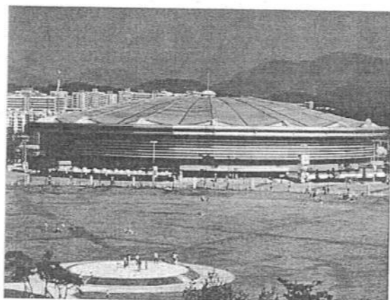
Fig. 40 c: Olympic Gymnastics Arena Seúl, Korea. Vista exterior del estadio de forma circular.
