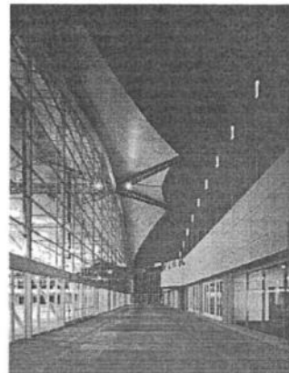
Fig. 41 a : Se observa la estructura de la cubierta con sus puntos altos suspendidos que permiten una planta sin sostenes intermedios.
