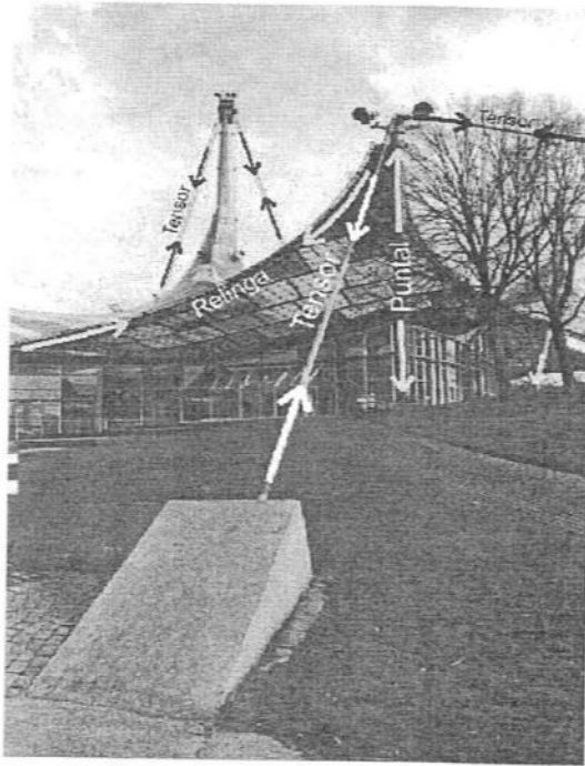
Fig. 29 a: Detalles de la cubierta del gimnasio. Esquema de los componentes y sus solicitaciones.
