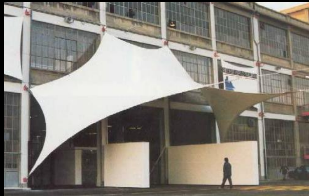
Marquesina de Ingreso
