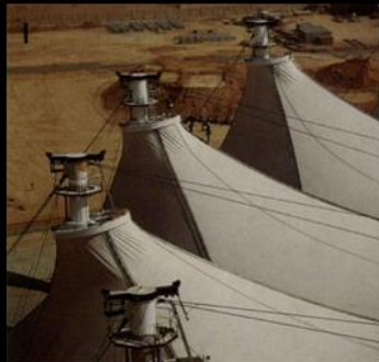
TENSADO DE LA TELA A LA PARTE SUPERIOR DE LOS MASTILES
