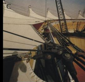
INSTALACION DE LOS CABLES INTERNOS QUE SUJETAN LA TELA
