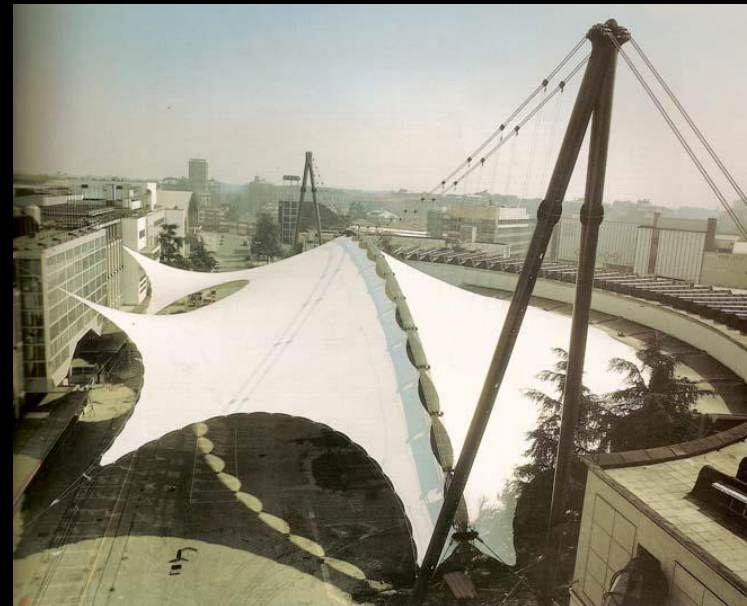
Tensoestructura de 6.000 m2 para la feria de Milán. Italia (1986). Proyecto arquitectónico: G. Sgalbazzi
