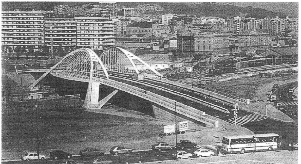
Fig. 13 d: Vista general. La longitud total del puente es de 128 m. La calzada se extiende sobre una gran viga-puente, cuya carga es soportada por tensores vinculados a los arcos.
