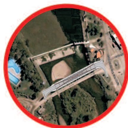
ZOOM PUENTE SOBRE RIO TERCERO
