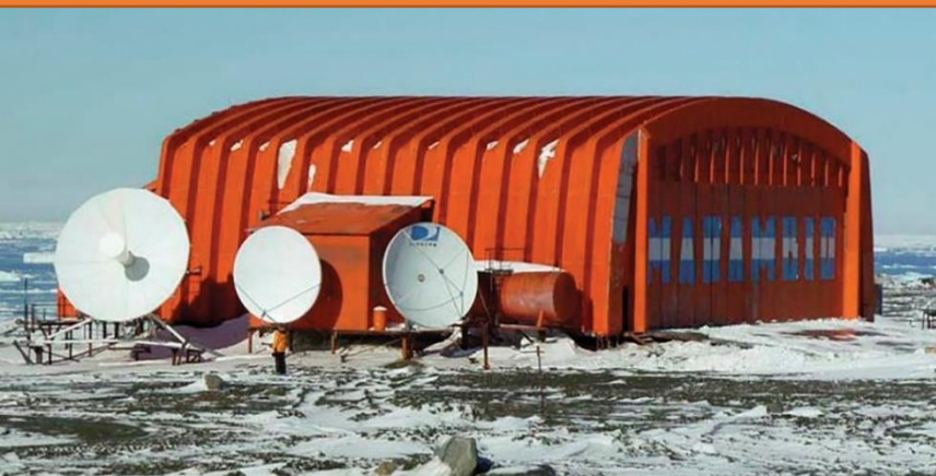
Hangare BASE COMODORO MARAMBIO
