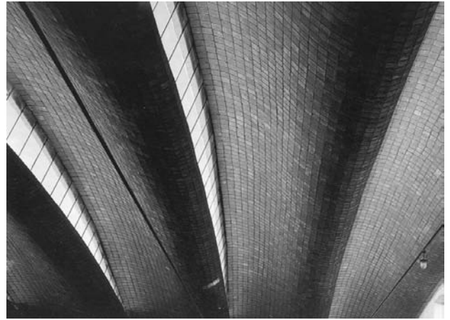
Figura 7.- Vista interior de la luminosidad de la nave cubierta con Bóvedas Gausas.
