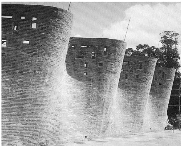
Figura 10.- Terminación de las paredes onduladas con las barras en espera para los tirantes de la cubierta.
