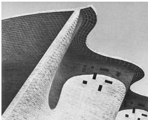
Figura 11.- Encuentro de la cubierta ondulada sobre el voladizo serpenteante de remate del muro.
