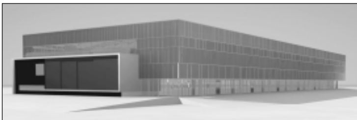
Fig. 2. Façanes Oest i Sud. | Fachadas Oeste y Sur.
