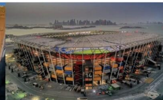
El estadio 974 está construido con esa cantidad de containers y será completamente desmontado después del Mundial de Qatar 2022
