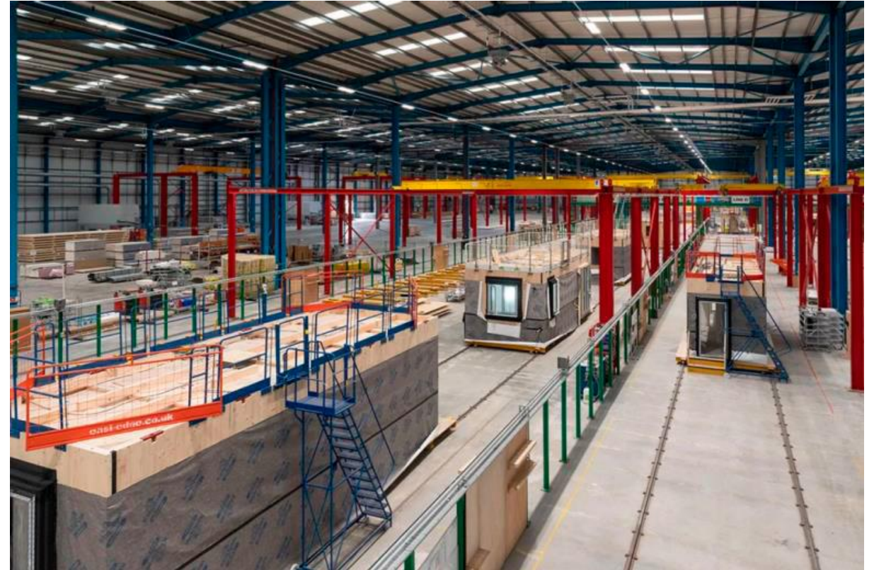
nave industrial, producción en fabrica
