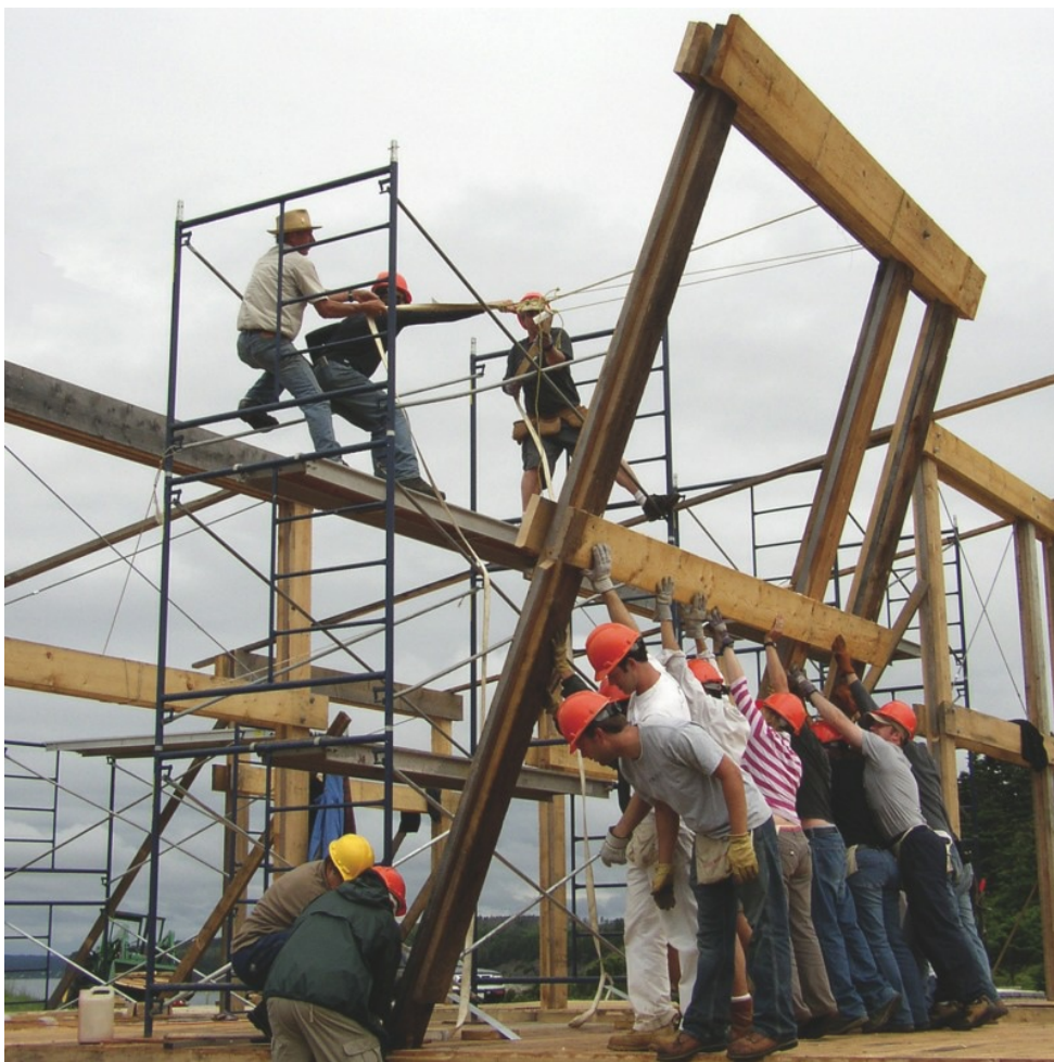
Estudiantes de arquitectura ejecutan unas estructuras de madera experimentales en el Ghost International Architectural Laboratory, iniciado y dirigido por Brian MacKay-Lyons en Nueva Escocia, Canadá. El campamento de construcción ha tenido lugar cada verano desde 1994. Ghost 7, 2006.
