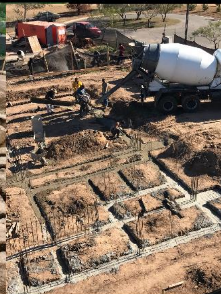
vertido de hormigón
