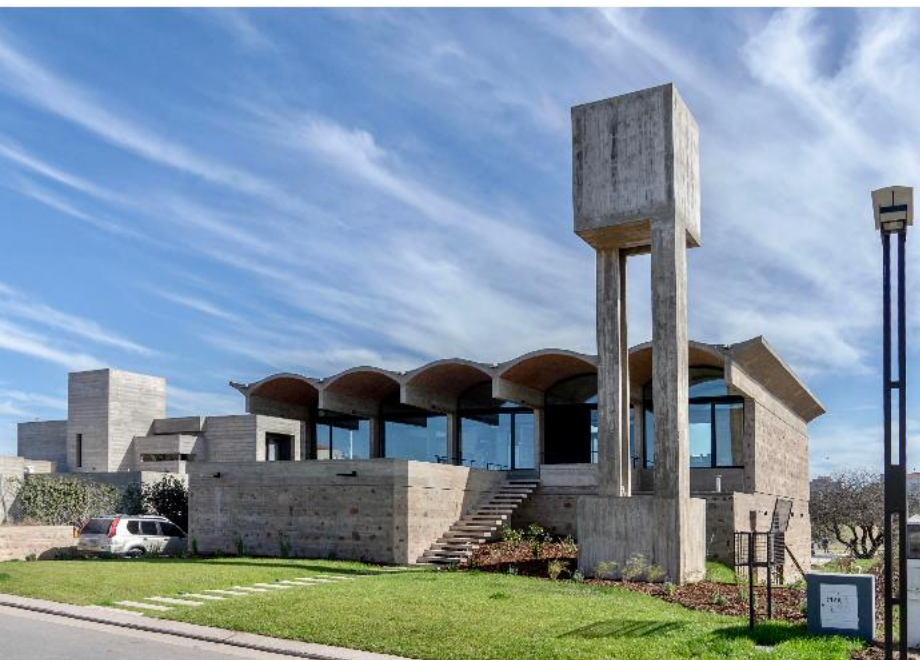
tanque de reserva
