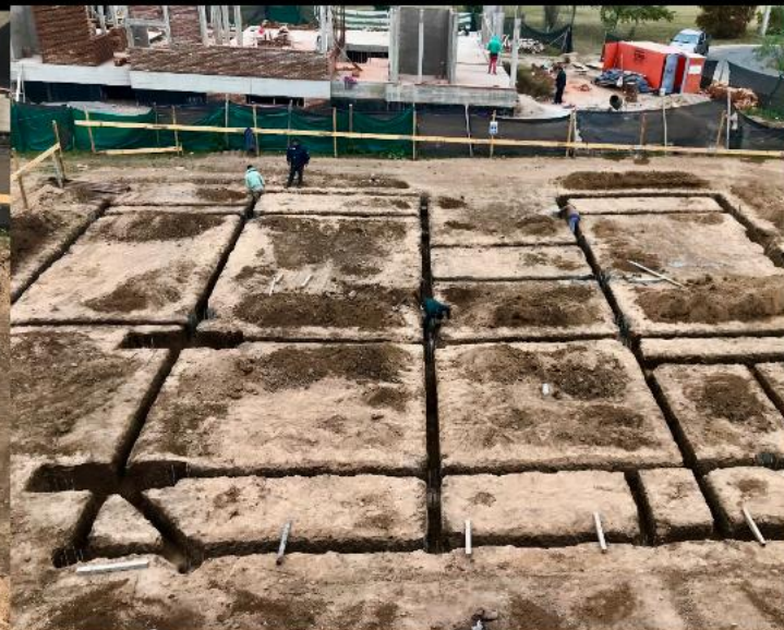
excavación vigas de fundación
