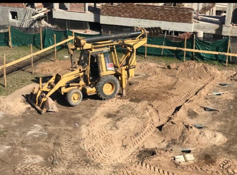
excavación mecánica de pozos-micropilotes
