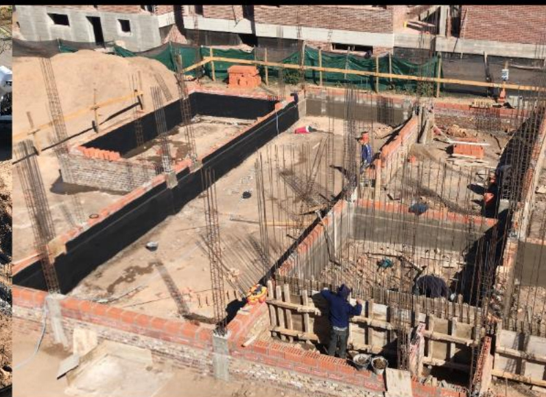
mampostería de fundación + capa aisladora
