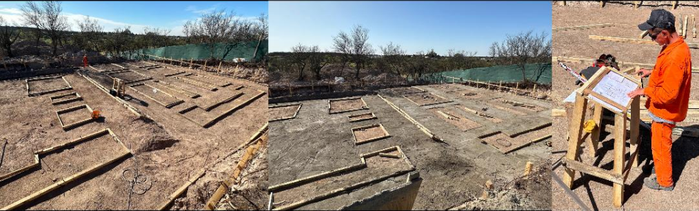
tareas preliminares + replanteo + hormigón de limpieza
