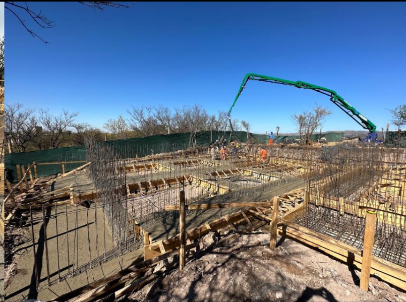
vertido de hormigón
