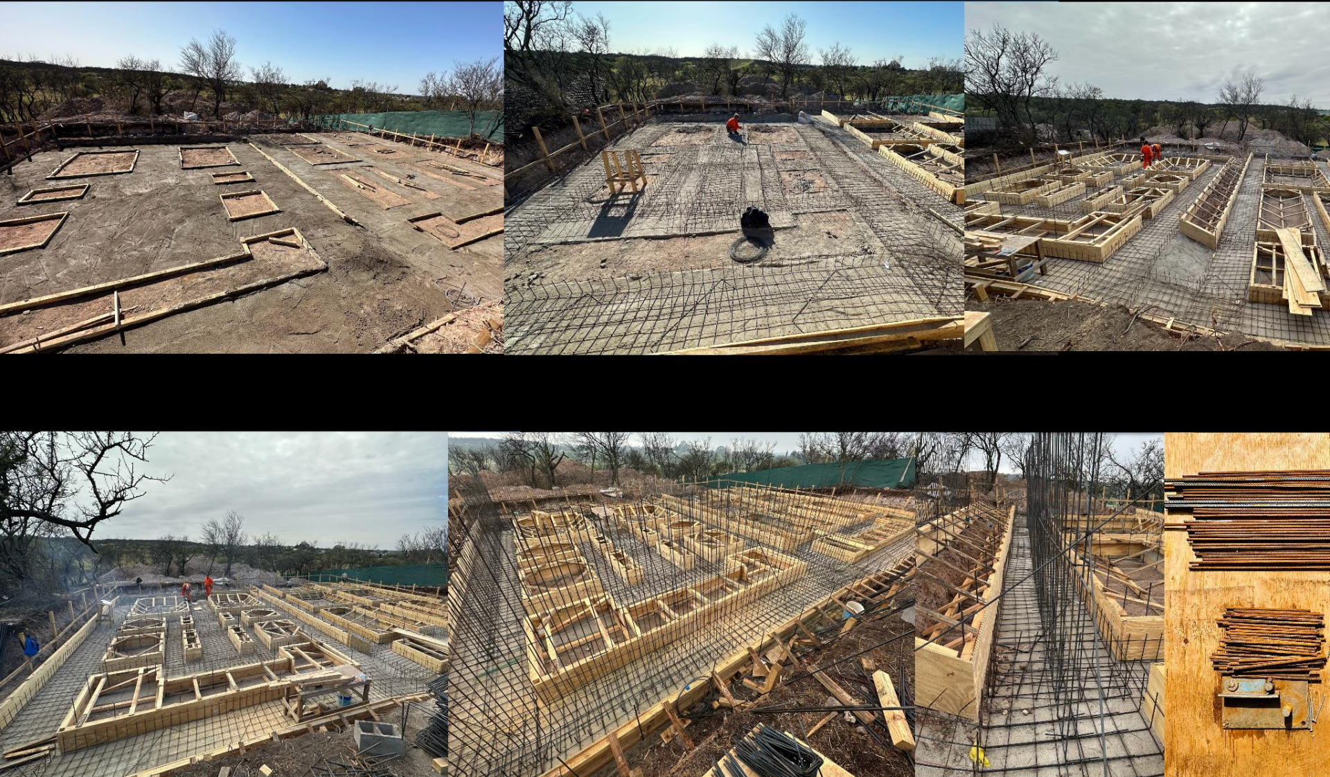
proceso de ejecución de fundaciones-armaduras-replanteo-encofrado-vertido de hormigón
