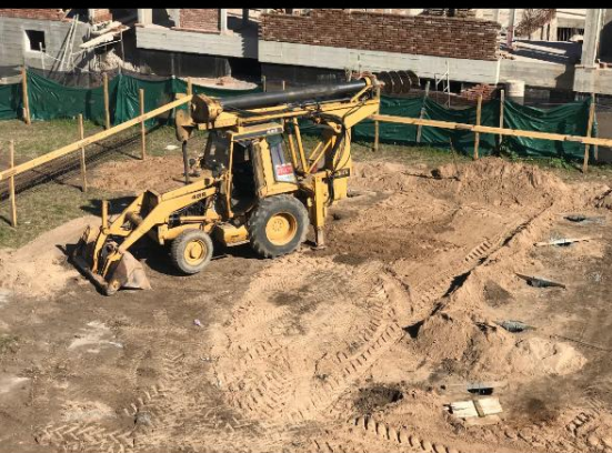
excavación mecánica de pozos-micropilotes
