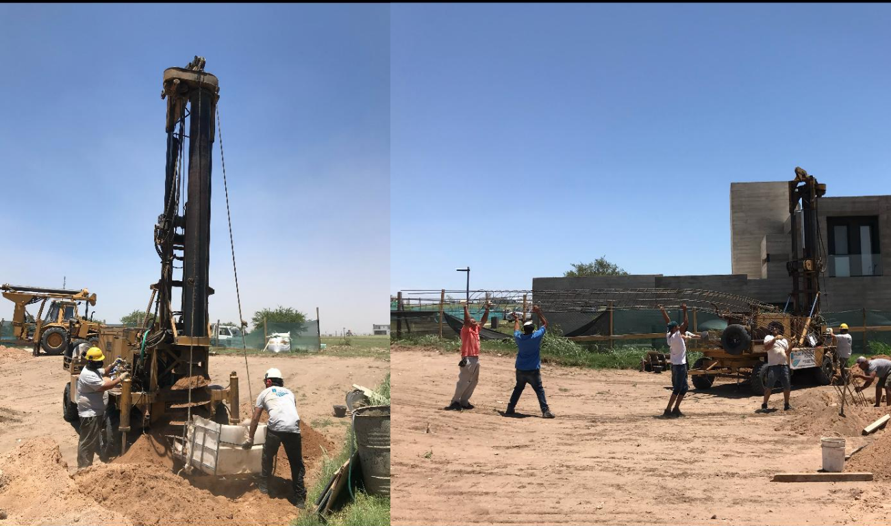
excavación y posicionamiento de armaduras en pozos ( fundación profunda)
