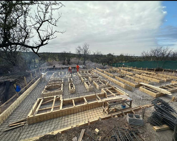
distribución de armaduras + encofrado
