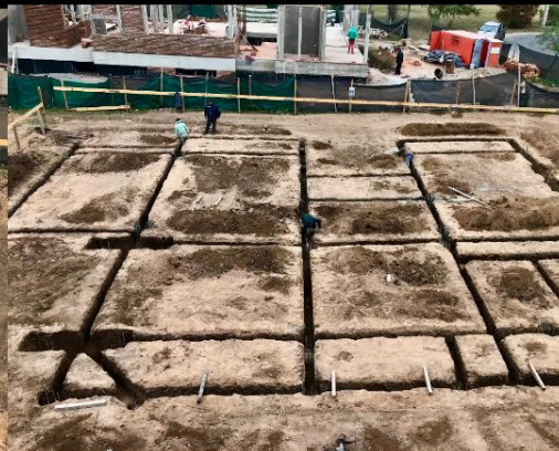
excavación vigas de fundación
