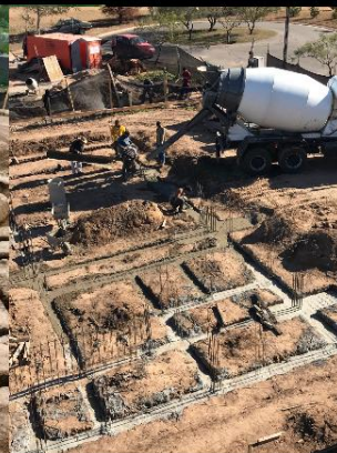
vertido de hormigón
