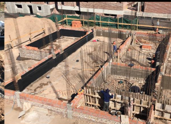
mampostería de fundación + capa aisladora
