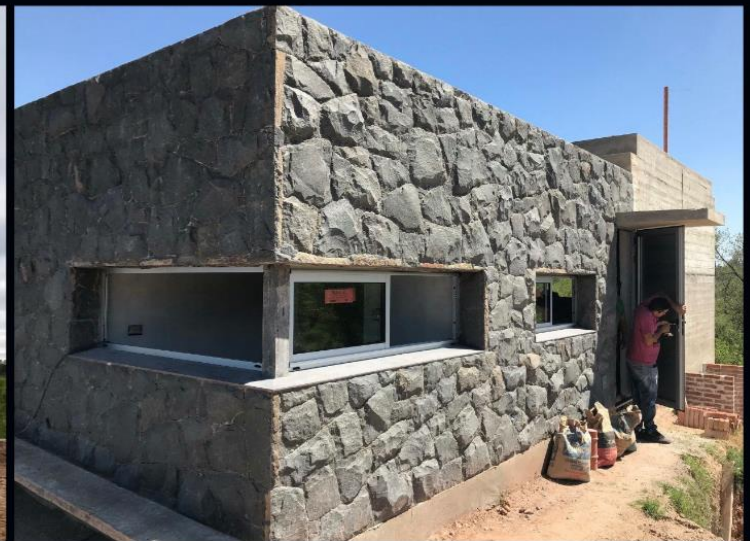
revestimiento de piedra natural
