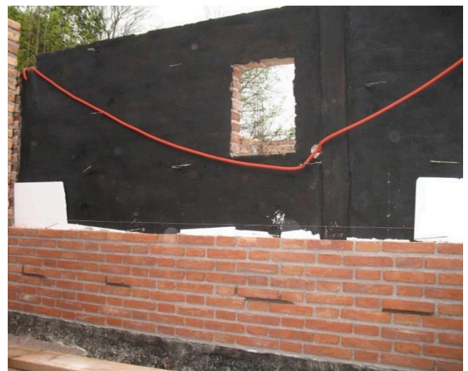
Figura 16. Doble muro de mampostería de ladrillo común.
