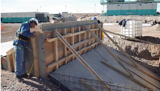
Figura 7. Encofrado de tabique de hormigón armado.
