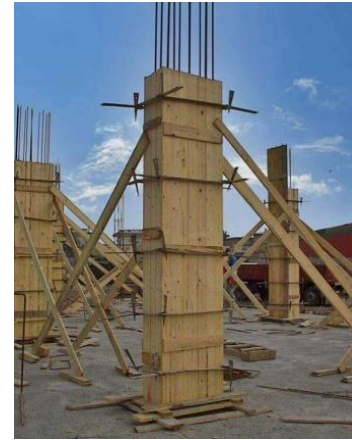
Figura 8. Encofrado de columna de hormigón armado
