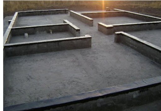
Figura 18. Mampostería hasta nivel de capa aisladora.
