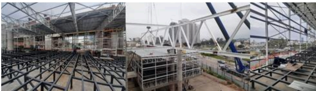
Figura 6. Sala de Sesiones Concejo Deliberante Municipal, Córdoba. Proyecto FBK Arquitectos. Crédito fotográfico y construcción. TECHMET SRL
