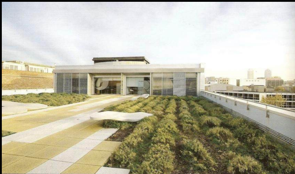
PICH + AGUILERA ARQS / OFICINAS PARA RENTA / DISTRITO 22@ / BARCELONA
