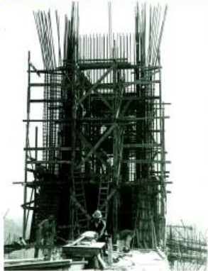
Armadura de hormigón (apartado 2.º, 4.º y 6.º piso) - Enero 1977
