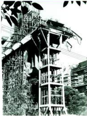
Muro exterior - Enero 1977
