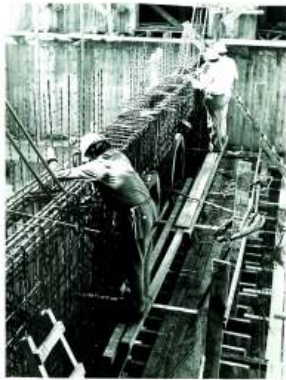
Armadura viga de Pórtico N.º 25 - Marzo 1977
