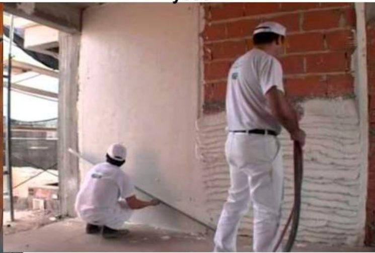
GUNITADO o PROYECTADO de mortero de yeso
