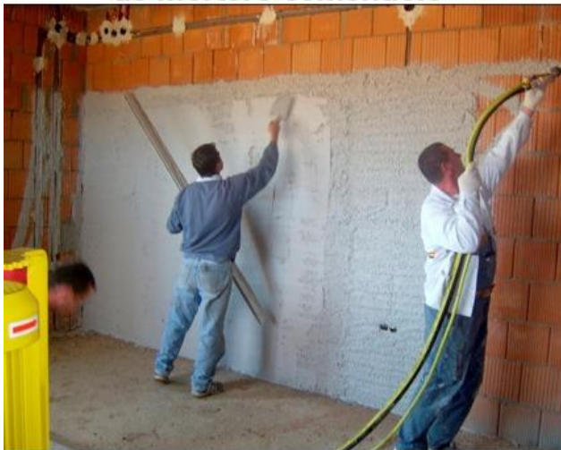
GUNITADO o PROYECTADO de mortero cementicio
