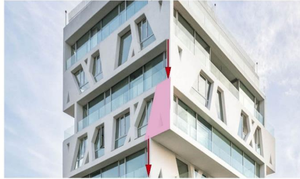
Llenos en los encuentros de vigas
