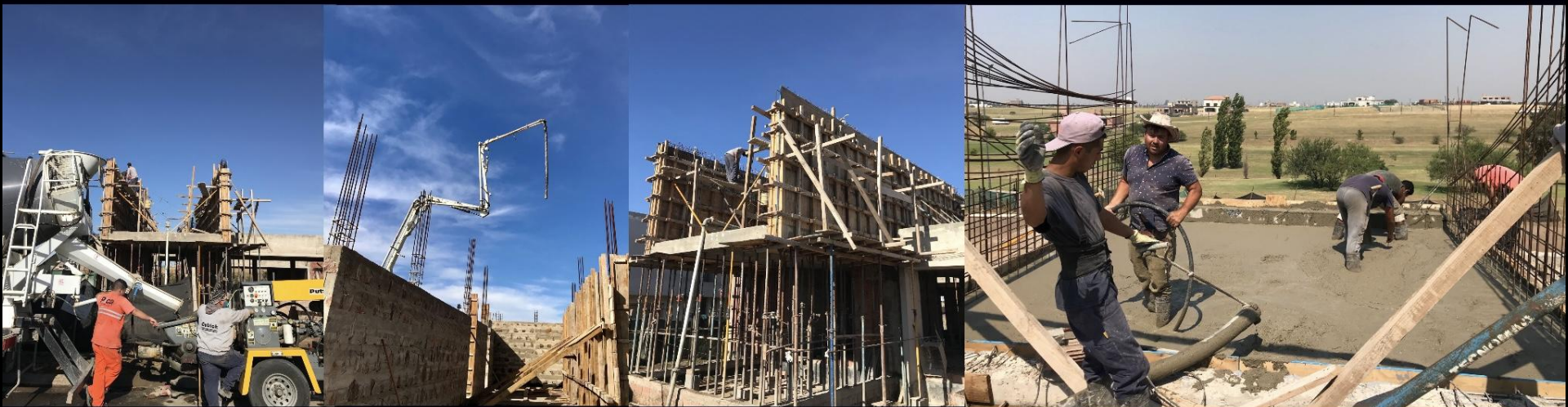
estructura de hormigón armado visto
