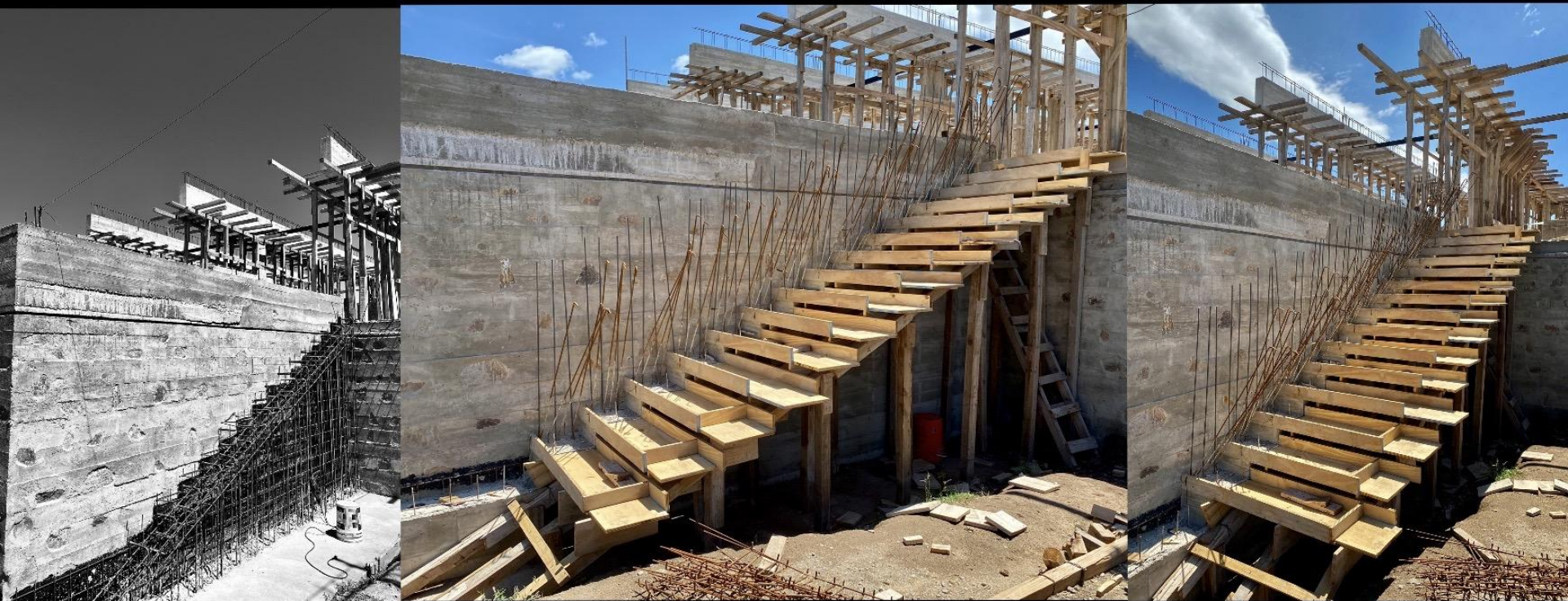
encofrado de escalera de hormigón de huellas empotradas en muro de hormigón y piedra
