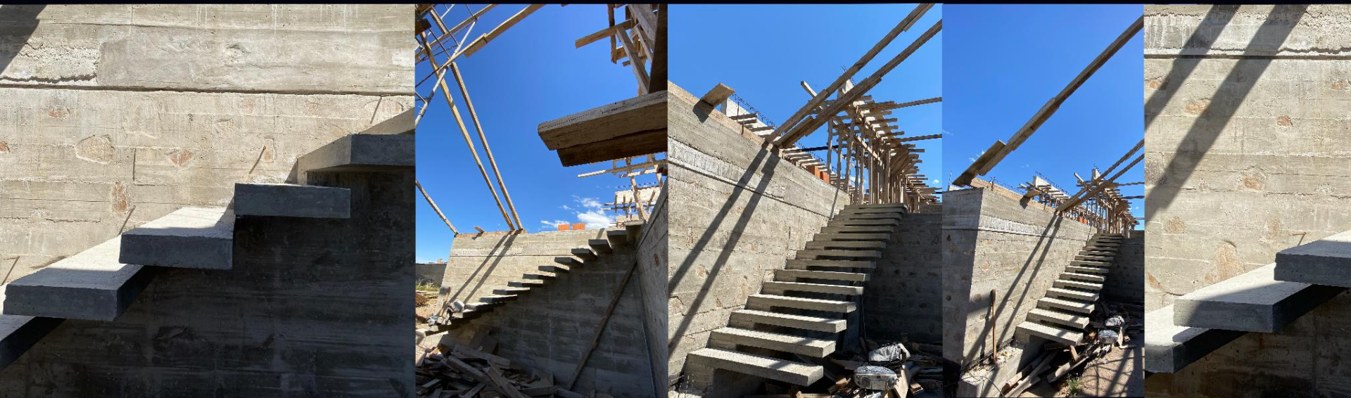
escalera empotrada de hormigón armado- huellas en voladizo
