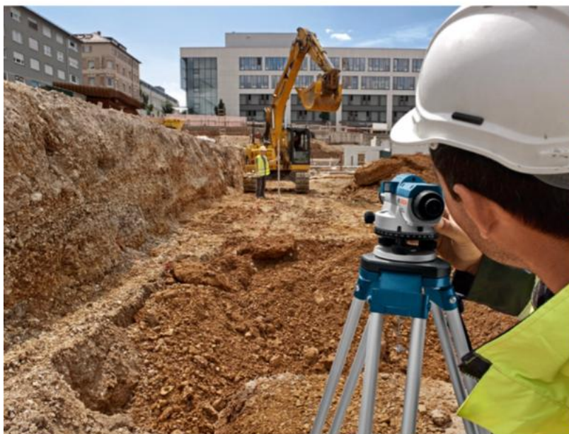
Replanteos de obra
