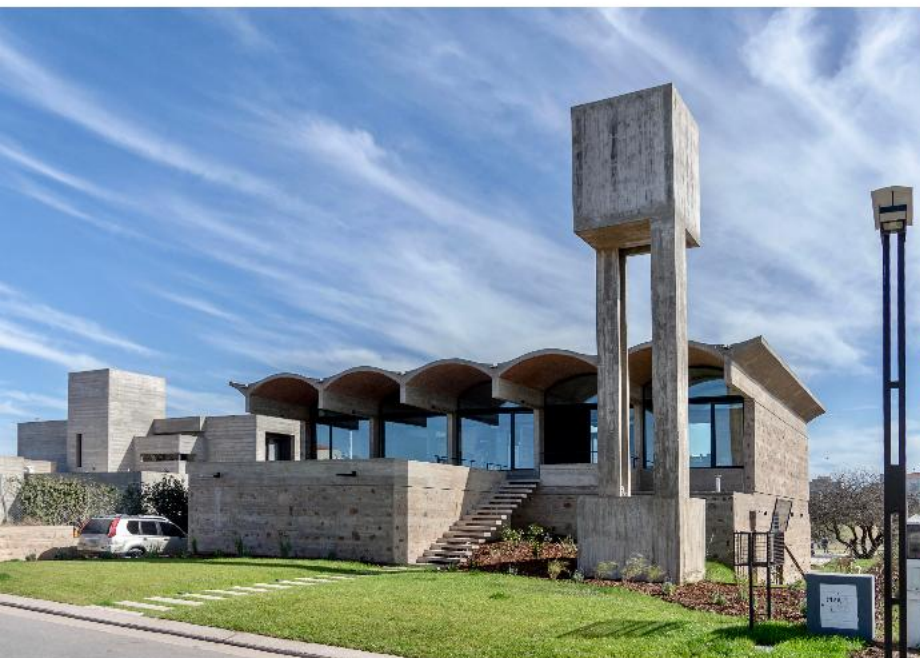
tanque de reserva
