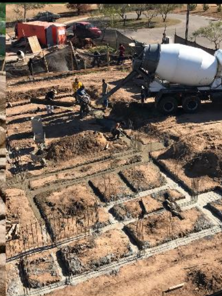
vertido de hormigón
