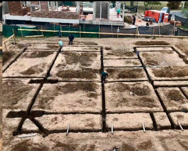
excavación vigas de fundación
