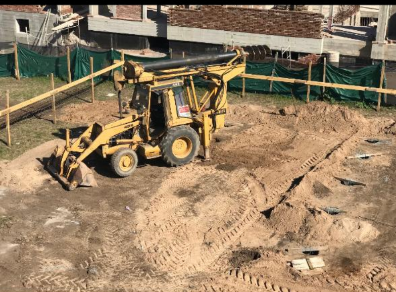
excavación mecánica de pozos-micropilotes
