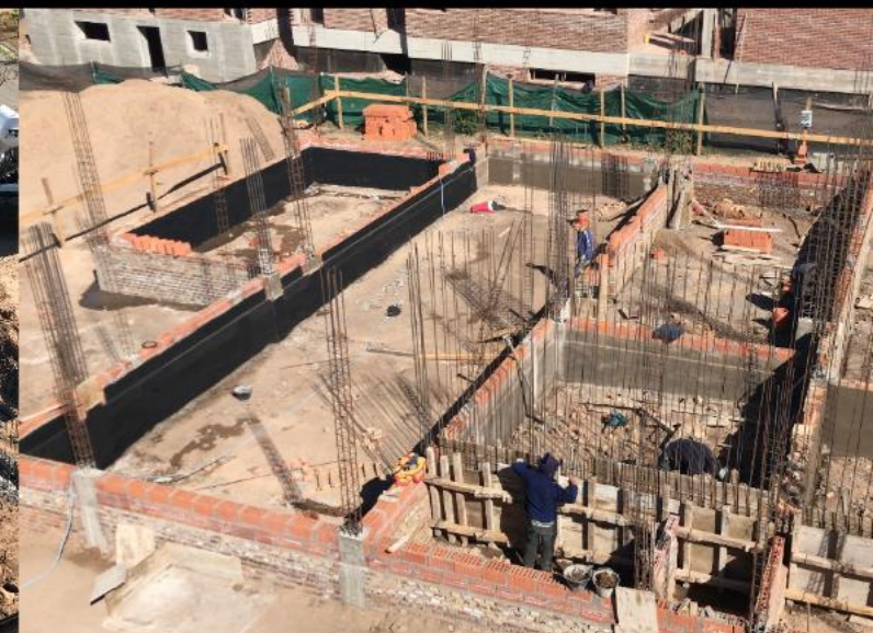
mampostería de fundación + capa aisladora
