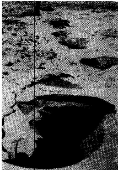
Figura 2.19 Efectos de la licuefacción del suelo en Niigata, Japón (1964)
