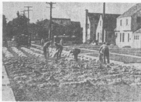
2 Se esparce el cemento a mano o mecánicamente
