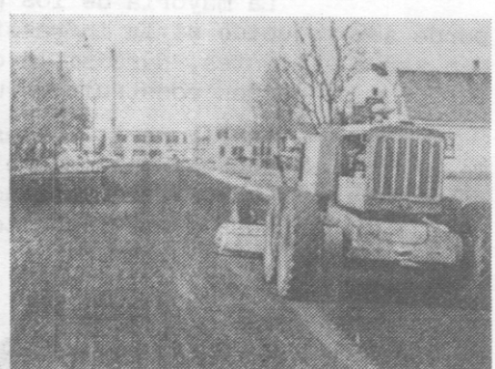
6 Se alisa la superficie con niveladora mecánica
