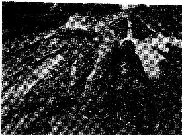
a) Estado inicial de la vía rural
