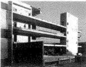
Fig. 298: Núcleo de hormigón. Estado en obra, 1997. Los forjados de hormigón tan sólo soportan su propio peso, lo que hace posible luces y voladizos de una gran dimensión.
