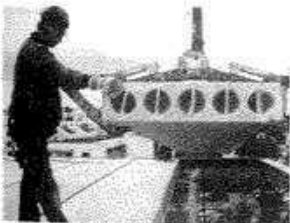
Fig. 48: Colocación de un elemento de forjado aligerado
