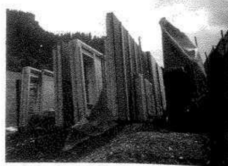
Fig. 328: Los paneles de madera en la obra La puesta en obra del armazón de madera se llevó a cabo en dos días
