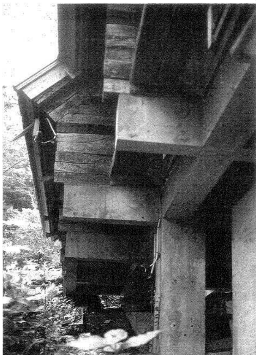
Fig. 74: La estructura de hormigón como infraestructura del edificio Shin Takasuga: casa construida con traviesas de ferrocarril, Miyakejima, Japón, 1980
