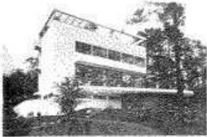
Fig. 9: La estructura portante de acero desaparece tras el revoco Wassili y Hans Luckhardt: casa en Rupenhorn, Berlín, Alemania, 1928
