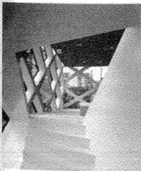
Fig. 73: Estructura portante romboidal de la fachada Herzog & de Meuron, Epicenter Store Prada, Tokio, Japón, 2003
