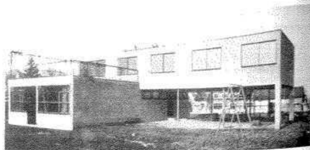
Fig. 130: Las huellas constructivas desaparecen por el relleno de obra de fábrica y el enfoscado Artaria & Schmidt: casa Schaeffer, Riehen, Suiza, 1927-1928
