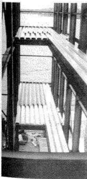
Fig. 37: Forjado compuesto Forjado cubierto parcialmente con perfiles de chapa antes del vertido de hormigón.
