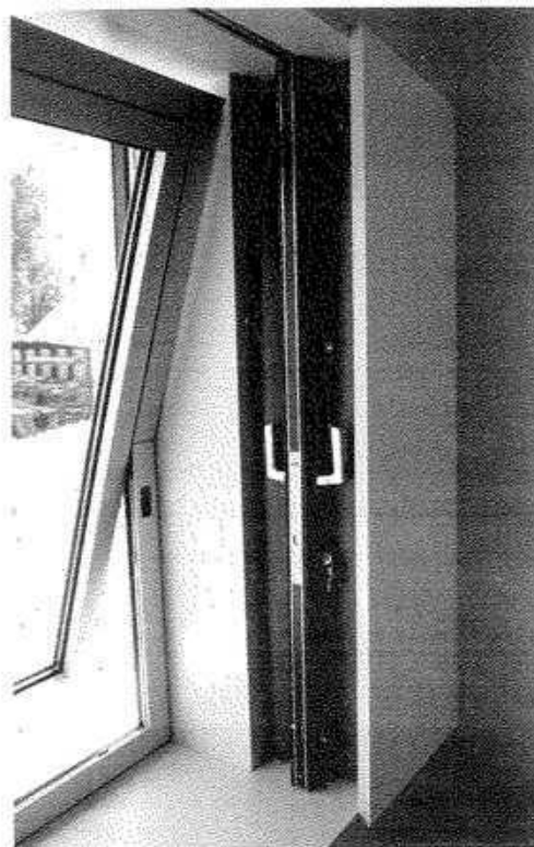
Fig. 111: Ventana de aluminio con hoja abatible
