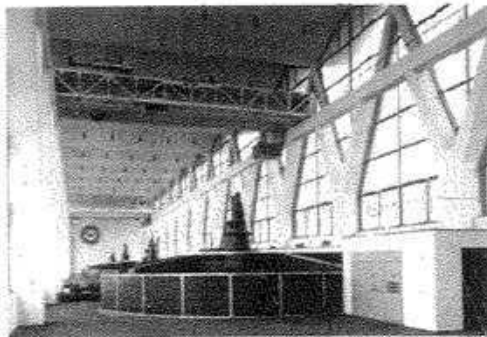
Fig. 66: Cubierta plegada apoyada sobre pilares en forma de Y Hans Hofmann, central hidroeléctrica de Birsleiden, cerca de Basilea, Suiza, 1953-1954
