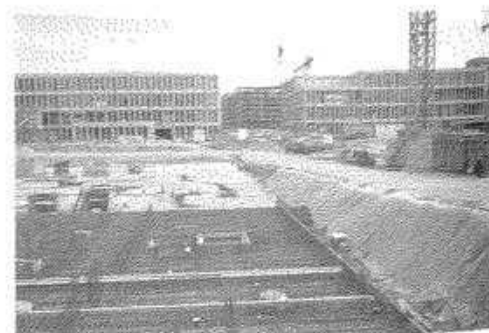
Fig. 43: Consolidación del talud recubierto con láminas de plástico
