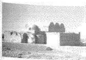
Fig. 12: Sistema constructivo con bóvedas de cañón independientes. Termas del palacio de Qusayr Amra, Jordania, 711
