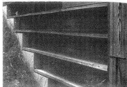
Fig. 68: El zócalo de hormigón es la parte visible de una cámara donde se apoya la casa de madera. Tablas horizontales de madera arrancan de los escalones de hormigón y dejan al descubierto las juntas Peter Zumthor: casa Guggelin, Versam, Suiza, 1994
