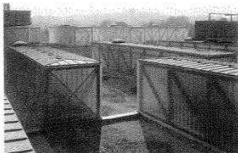
Fig. 62: Las claraboyas entre crujeas están revestidas de vidrio Profilit Herzog & de Meuron: depósito de locomotoras "auf dem Wolf", Basilea, Suiza, 1995
