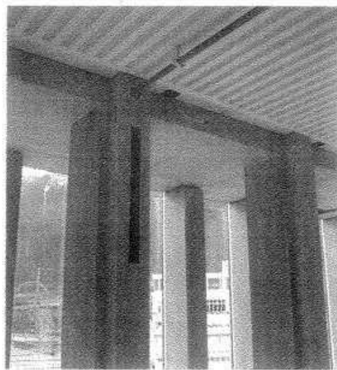
Fig. 256: Pílares exteriores. Cabeza de los pilares con el canal de ventilación y los techos acústicos
