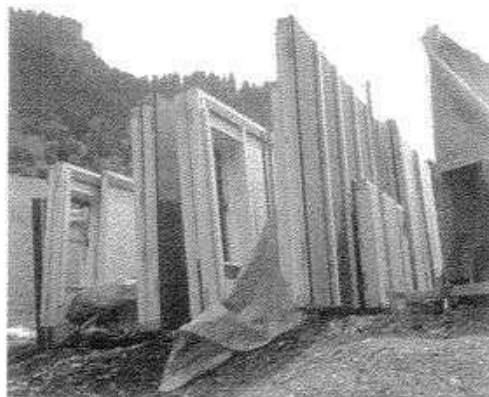
Fig. 47: Elementos de un armazón de madera antes del montaje Beath & Deplazes: casa Willmann, Sevelin, Suiza, 1998
