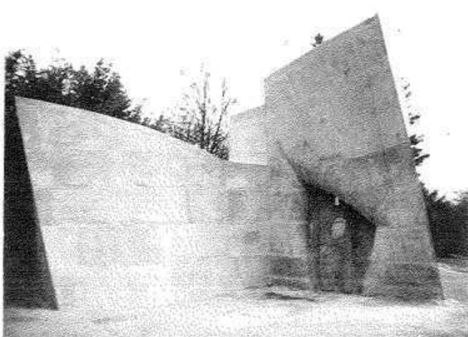
6 La Gate House limpia y preparada para ser pintada de color
