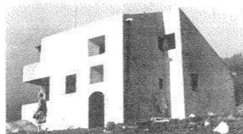
Fig. 33: Las hendiduras profundas de las ventanas confieren al edificio un carácter de volumen macizo Rudolf Olgiati: casa Van Heusden, Laax, Suiza, 1964
