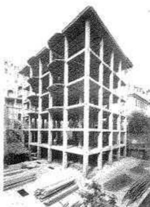
Fig. 5: Sistema constructivo reticular
