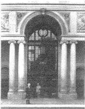
Fig. 52: La puerta giratoria es la marca distintiva del Grand Hotel, entrada de la Olive Street. The Biltmore Hotel, Los Angeles (California), Estados Unidos, 1923
