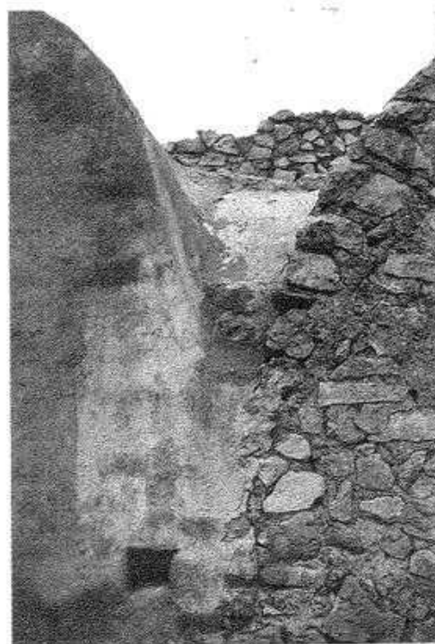
Fig. 80: Ghorfas tipo A Detalle de la fachada parcialmente entoscada
