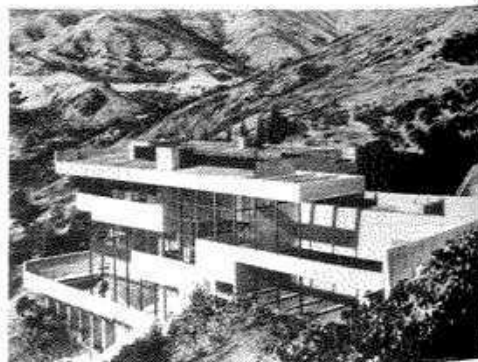
Fig. 8: Los pilares de acero apenas se destacan de los perfiles de las ventanas Richard Neutra: casa Lovell, Los Ángeles (California), Estados Unidos, 1927-1929
