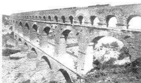
Fig. 52: Sucesión y superposición de un sistema constructivo de arcos: basado en la economía de medios elimina el material innecesario. La construcción con arcos alcanza aquí un sentido propio de la técnica ingenieril. Pont du Gard, acueducto romano en Nîmes, Francia, siglo I
