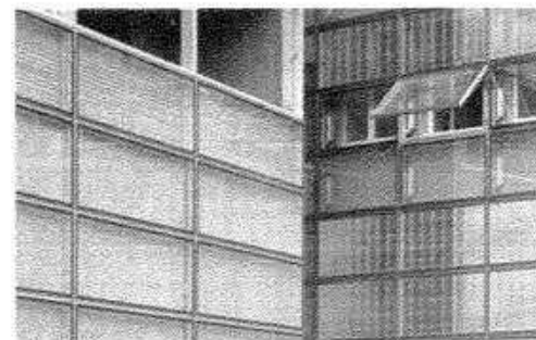
Fig. 2: El edificio preexistente y el nuevo se unen mediante una fachada de vidrio aislante. Arriba: la superficie de fachada sobre el lado de la calle. Abajo: detalle de la esquina que da al patio. Herzog & de Meuron: edificio de viviendas y oficinas Suva, Basilea, Suiza, 1988-1993.
