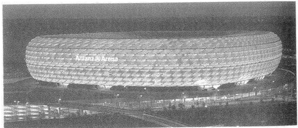
Fig. 51: Los almohadones neumáticos, formados por membranas, configuran la envoltura traslúcida del estadio de fútbol Herzog & de Meuron: Allianz-Arena, Múnich, Alemania, 2002
