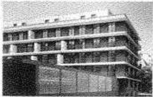
Fig. 8: Morger & Degelo: edificio de viviendas, Basilea, Suiza, 1993
