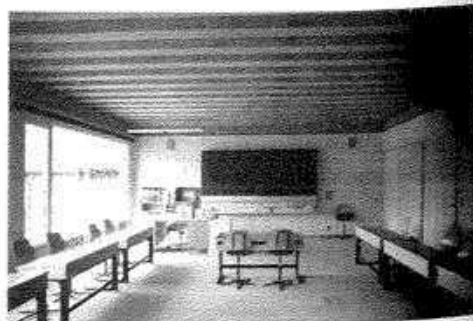
Fig. 23: Aula con el techo nervado de hormigón.
