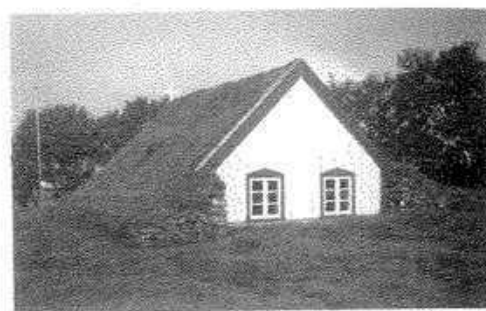
Fig. 17: El edificio se adapta al paisaje, tanto por su forma como por los materiales empleados. Museo al aire libre Skogar, Islandia
