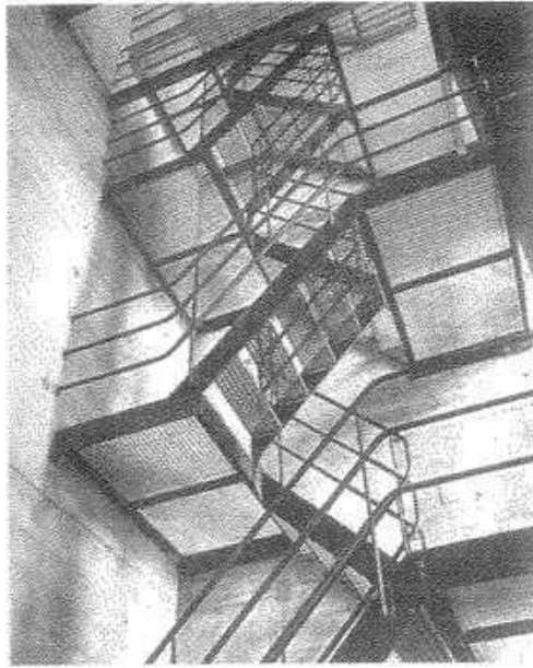
Fig. 40: Vista del núcleo de comunicación vertical
