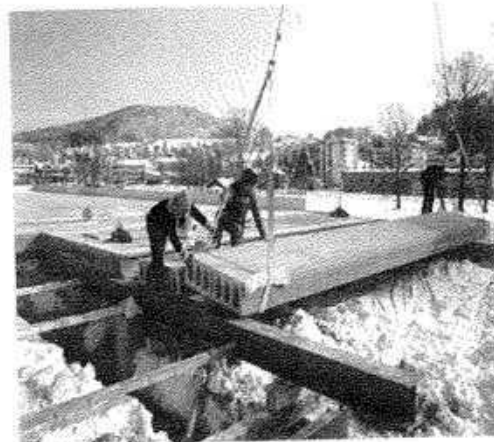
Fig. 6: Los elementos de hormigón se colocan en obra con la grúa
