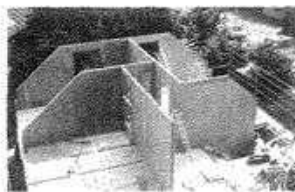
Fig. 39: El tablero delgado. Montaje del sistema de tableros.
