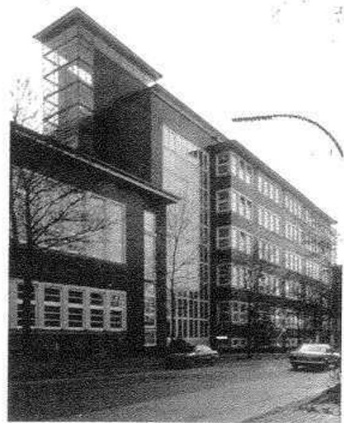
Fig. 20: Ejemplo de un edificio moderno con muros de fábrica Fritz Schumacher: escuela en la Wendenstrasse, Hamburgo, Alemania, 1929
