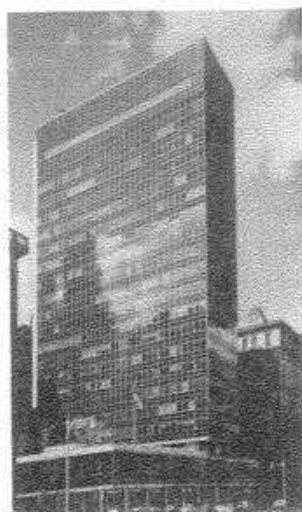
Fig. 17: Fachada reticulada de vidrio Skidmore, Owings & Merrill (SOM): edificio Lever, Nueva York, Estados Unidos, 1952
