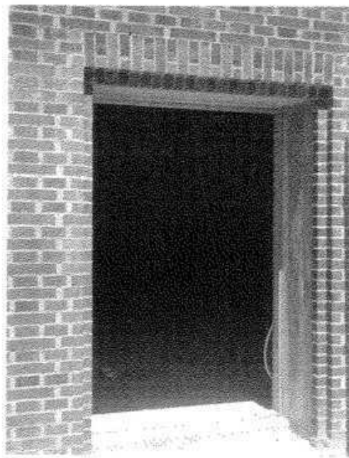
Fig. 77: Ladrillos rebajados para el montaje de una puerta
