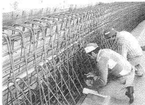
Fig. 15: Colocación de la armadura en obra
