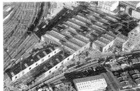
Fig. 65: Foto aérea de la obra en construcción. La nave mayor aún no está cubierta totalmente
