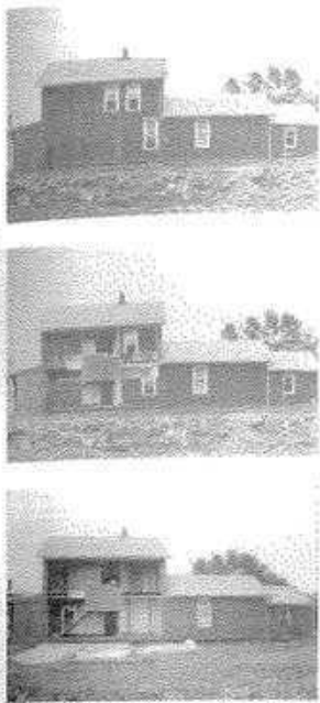
Fig. 15: Bingo (cutting) : separación de la pared exterior por medio de una motosierra, dejando al descubierto el interior del edificio Gordon Muth-Clark (1943-1976), arquitecto y artista estadounidense
