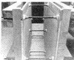
Fig. 14: Detalle de un encofrado de madera con separadores
