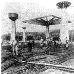
Fig. 76a: Sistema constructivo fungiforme en fase de construcción Pier Luigi Nervi: Pabellón del Trabajo, Turín, Italia, 1961
