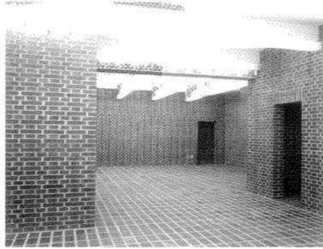
Fig. 83: Luz artificial bajo las vigas
