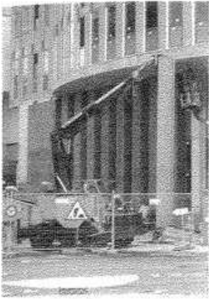
Fig. 39: Pieza superior (anclaje de fachada). Suspensión del elemento en la parte superior.
