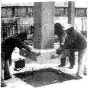
Fig. 33: Montaje de un pilar de acero
