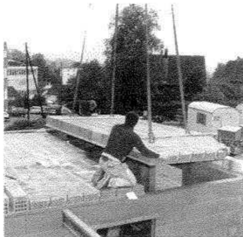
Fig. 1: Arriba: piezas de un elemento cerámico prefabricado: entre las bovedillas, viguetas de hormigón armado; abajo: montaje de los elementos prefabricados (en este caso: Bricosol)
