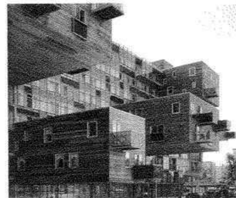
Fig. 66: El revestimiento de madera oculta el sistema constructivo de acero MVRDV: residencia asistida para la tercera edad, Ámsterdam, Países Bajos, 1997
