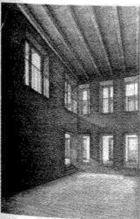
Fig. 117: Interior del vestíbulo iluminado por tres de sus lados Catherine Gay: torres en Kreuzplatz, Zürich, Suiza Proyecto fin de carrera, ETH, Zürich, 1999
