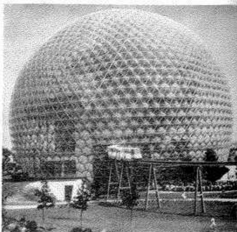
Fig. 71: La sección esférica muestra en la base un diámetro de 110 m Richard Buckminster Fuller: pabellón de Estados Unidos en la Exposición Universal de Montreal, Canadá, 1967
