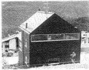
Fig. 1: Bearth &amp; Deplazes: casa Werner, Trin, Suiza, 1994
