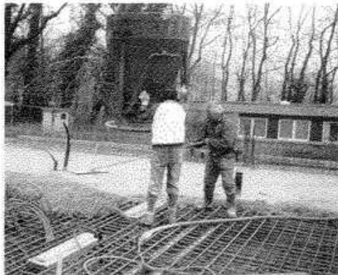
Fig. 3: Colocación de encofrado, armadura y conductos para las instalaciones (electricidad, agua, ventilación, etc.) antes del vertido del hormigón
