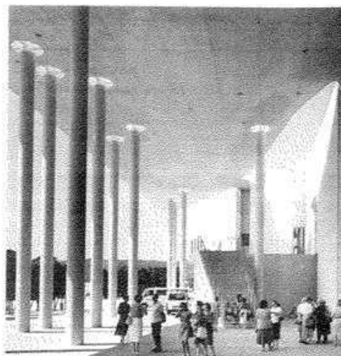
Fig. 54: Pilares de hormigón, unidos a un forjado de hormigón armado mediante un capitel de acero. Axel Schultes: Kunstmuseum, Bonn, Alemania, 1992
