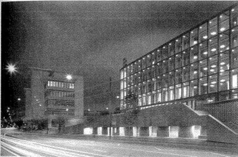
Fig. 239: Vista nocturna de la escuela en la Bruggerstrasse
