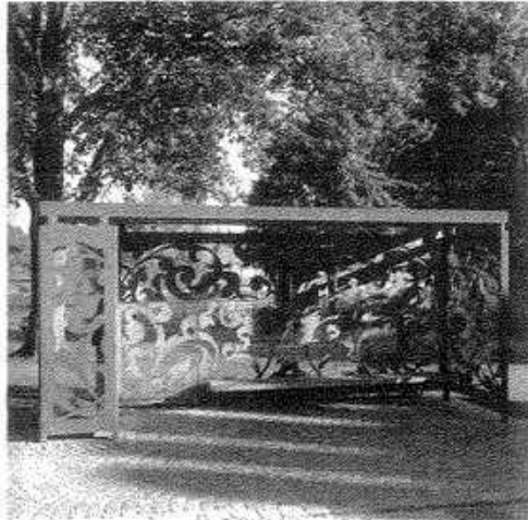
Fig. 52: Chapa de acero plegada (12 mm de grosor), como elemento estructural (arriba), planta a escala aproximada, 1:40 (a la izquierda). HildundK: parada de autobuses, Landshut, Alemania, 1999
