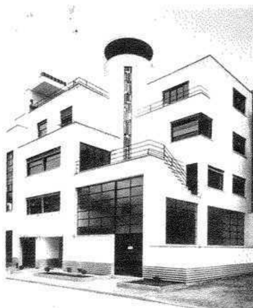
Fig. 121: Vista exterior con el estudio en primer plano y la caja de escaleras parcialmente exenta Rob Mallet-Stevens: villa Martel, París, Francia, 1929-1927
