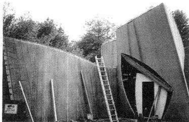
4 El recorte del gran hueco de la entrada (se tuvo en cuenta la modificación respecto al estado que se observa en la imagen anterior). Los cantos están reforzados adicionalmente por medio de fierros de armado
