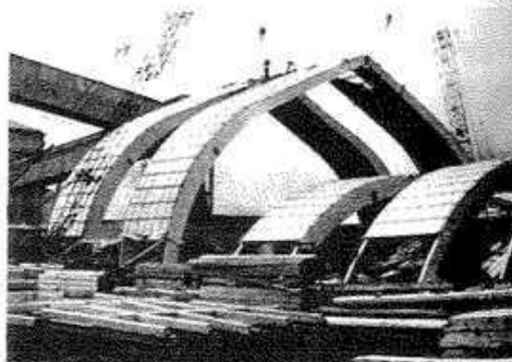
Fig. 137: Proceso de montaje con superficies laminares (medias cáscaras) prefabricadas Almacén para sales industriales
