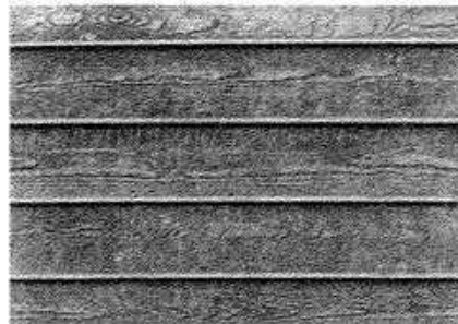
Fig. 25: Encofrado horizontal de tablas Encofrado compuesto por tablas de abeto Douglas, de 3 cm de grosor y 18 cm de anchura; cantos rehundidos y tablas colocadas a tope. Se forman las características estrías salientes en el hormigón
