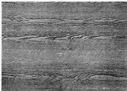
Fig. 24: Encofrado horizontal de tablas Encofrado compuesto por tablas de abeto Douglas, de 3 cm de grosor; cantos lisos y tablas colocadas a tope
