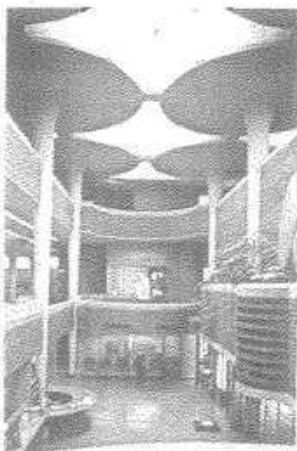
Fig. 2: La cubierta como baldaquino Frank Lloyd Wright: edificio de oficinas para Johnson-Wax, Racine (Wisconsin), Estados Unidos, 1940-1950
