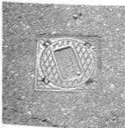
Fig. 35: Punto fijo en una arqueta de registro
