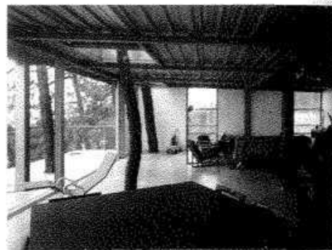
Fig. 60: Esqueleto de acero visto en el interior, con forjado de chapa perfilada Lacaton & Vassal: casa de vacaciones, Cap-Ferret, Francia, 1998
