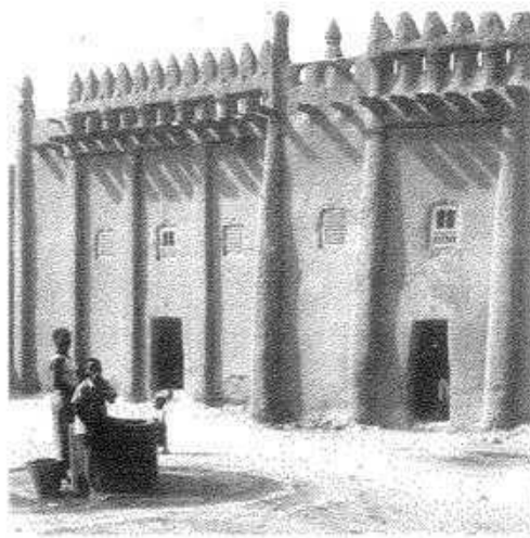
Fig. 46: Construcción de barro con refuerzos de madera (entramado interior) que se recubre con barro para protegerla (nervios transversales). Construcción tradicional Dogón, Mali.
