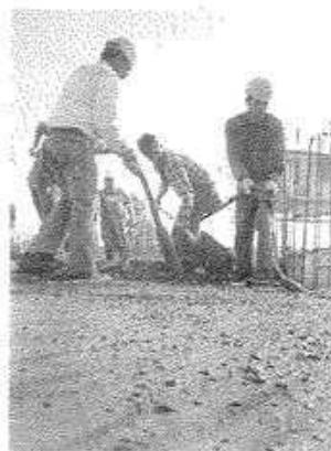
Fig. 18: Compactación del hormigón
