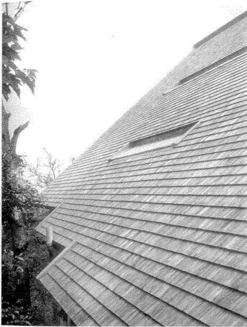
Fig. 65. Revestimiento del tejado con ripias Shin Takasuga: casa construida con traviesas de ferrocarril, Miyakejima, Japón, 1960
