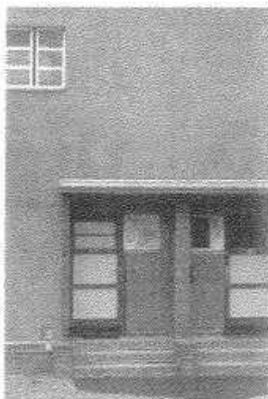
Fig. 50: La entrada se caracteriza por colores intensos que convierten a la puerta en el elemento central de la configuración del edificio. Bruno Taut: Hufeisensiedlung, Berlín-Brick, Alemania, 1925-1927
