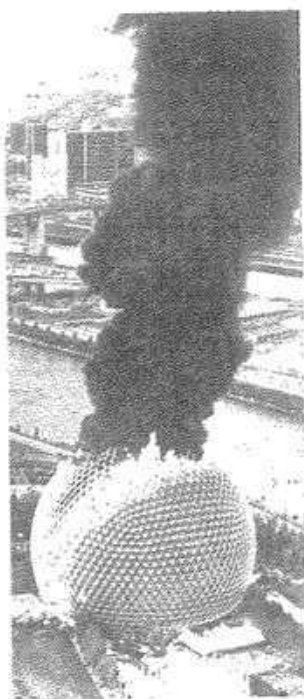
Fig. 31: Incendio en la Expo 67 de Montreal; los paneles acrílicos se fundieron en quince minutos. Richard Buckminster Fuller et al.; pabellón de Estados Unidos, Exposición Universal de Montreal, Canadá, 1967
