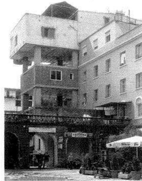
Fig. 1: Estructura portante que potencialmente puede volver a ser utilizada. Edificio de viviendas en el centro de Tirana, Albania, 2002.
