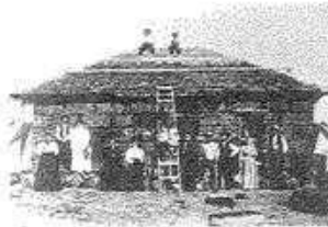
Fig. 6: Edificación construida con pacas de paja Casa Simonton, Pundum (Nebraska), Estados Unidos, 1908
