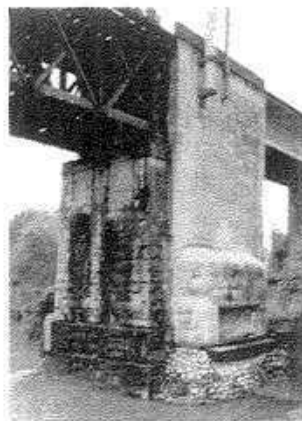
Fig. 62: Viaducto de Wipkingen, Zürich, Suiza Pilar situado al este
