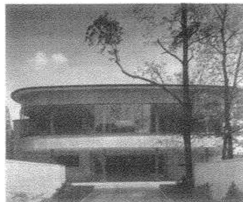
Fig. 40: La banda de ventanas de la planta superior se separa de la estructura Otto Rudolf Salvisberg: Primera Iglesia de la Ciencia Cristiana, Basilea, Suiza, 1937
