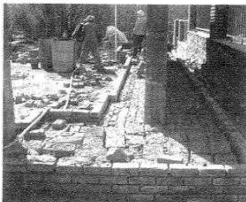
Fig. 95: La compleja construcción del muro con la protección contra seísmos Rossbauer, Brnic, Graf: casa de la ciencia ETH, Bamiyán, Afganistán, 2003-2006
