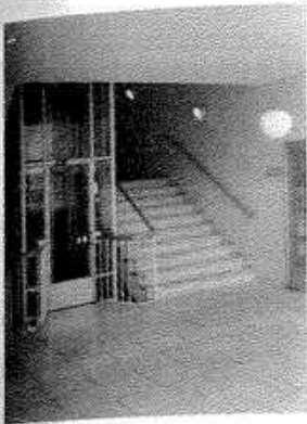
Fig. 26: La caja del ascensor se encuentra alojada en el hueco de la escalera. Foto: Jacobson; Ayuntamiento de Sölleröd, Dinamarca, 1942.
