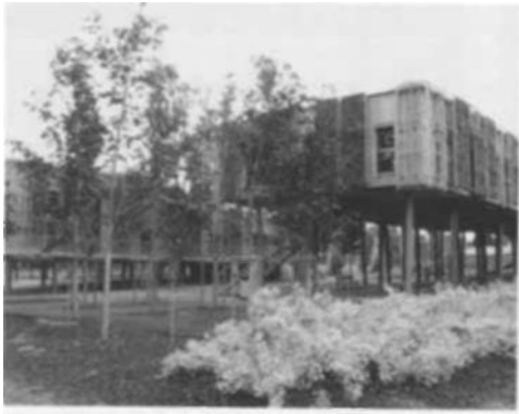
Duncan Lewis, con Klein & Baumann escuela en Obernai. Francia. 2005.
