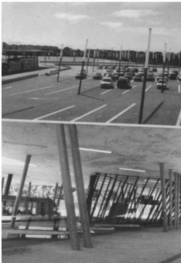
Zaha Hadid, aparcamiento y terminal de tranvías, Estrasburgo. Francia, 1999-2003.
