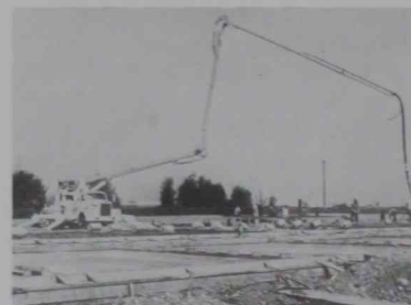
8. La bomba de hormigonado permite el transporte y la puesta en obra en continuo del hormigón.
