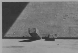
20. El gran panel, como el sillar, debe depositarse sobre un lecho de mortero. Estas cuñas de madera impedían, en el sistema Casamitjana de Cerdanyola, la expulsión de la pasta antes de su fraguado.
