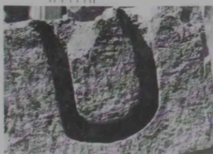
3. Los sistemas de elevación de la construcción clásica recurrían a ranuras acanaladas en los bloques pétreos que permitían liberar fácilmente el cordaje.
