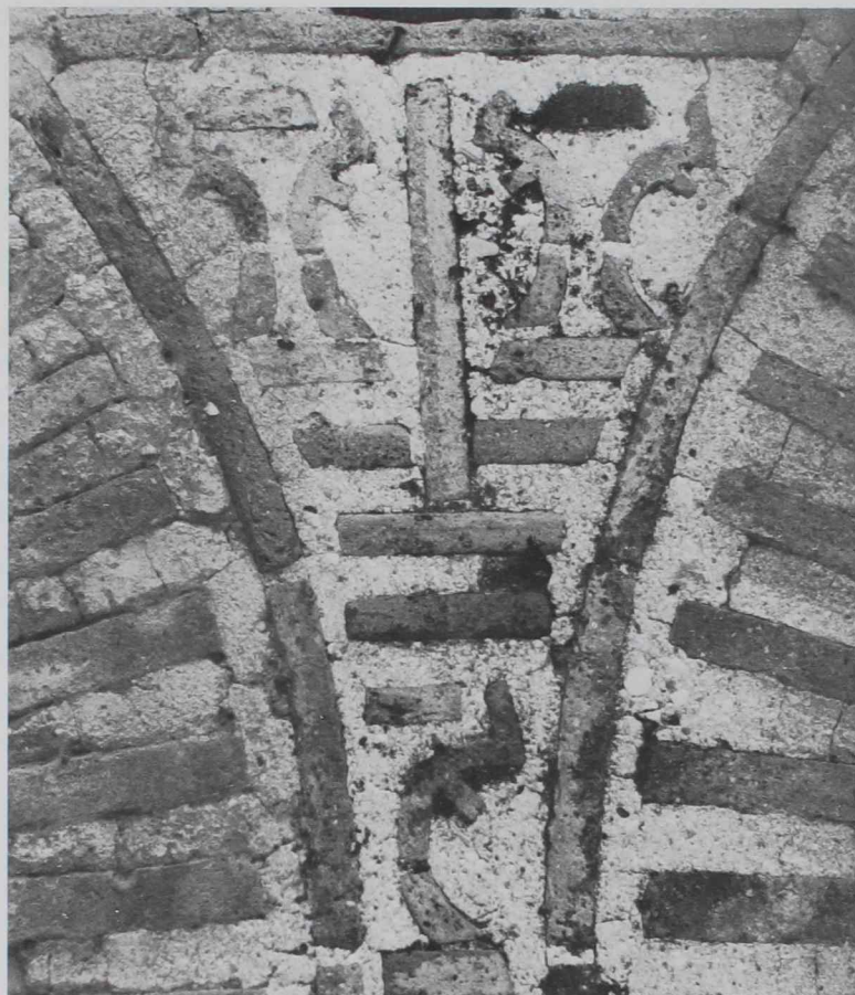
1. La fábrica de ladrillo se ha entendido generalmente como un aglomerado de piezas pequeñas, como es evidente en este muro de una pequeña iglesia bizantina ateniense. Una auténtica pudinga, como decía Cardellach.
