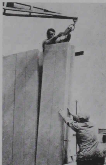
15. El ladrillo con altura de un piso, de origen francés, es el límite del incremento de escala de los pequeños elementos, ideado para reducir las operaciones en obra.
