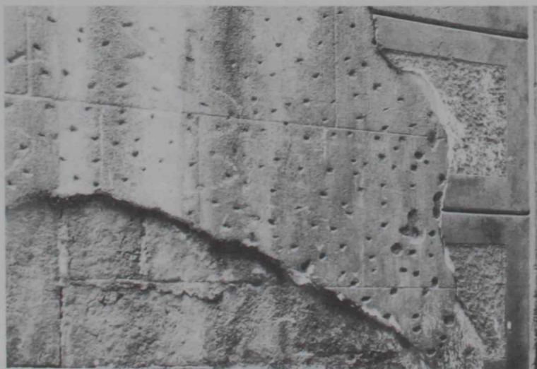
7. La adherencia a la base ha sido siempre una de las dificultades fundamentales del tendido. En la figura se ve el primer tendido sobre un tabique de medianería barcelonés que ha sido cuidadosamente repicado para asegurar la adherencia de un nuevo y más rico revoco pétreo.
