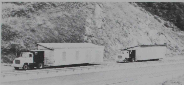
25. Las exigencias de superficie e imagen exigen anchuras que los gálipos de transporte no permitían y fue necesaria la yuxtaposición de dos módulos para formar una vivienda ya absolutamente convencional.
