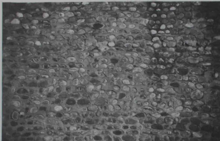
2. La calidad del aglomerado de la fábrica es mayor si las piezas no son de gran tamaño y la pasta las envuelve convenientemente como en los muros del recinto del Monasterio de Sandoval (León).
