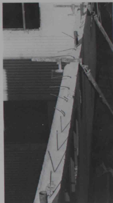
21. En el sistema Tracoba, utilizado en Ciutat Badia (Cerdanyola) y en Alcalá de Henares, el apoyo provisional del panel superior se hacía sobre unos tapones de aluminio que, a su vez, se colocaban sobre tubos metálicos, como los que asoman en las testa de este panel de fachada de la escalera.
