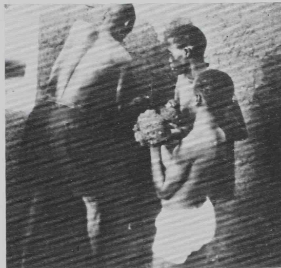
2. La plasticidad del material guía todo el proceso de puesta en obra. El transporte de arcilla en las manos de estos constructores africanos, por ejemplo, exige a la masa una elevada consistencia.
