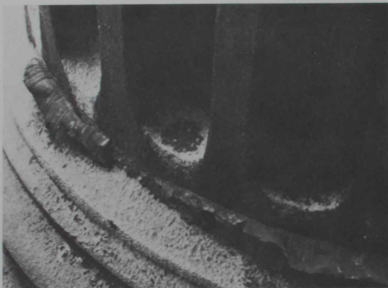
13. El plomo es expulsado de la junta bajo los pilares de la catedral de St. Pablo, en Londres.
