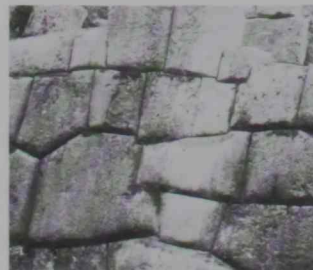
6. Las construcciones ciclópeas optimizan el uso de los grandes bloques y aseguran la trabazón gracias a la complejidad geométrica de las juntas.
