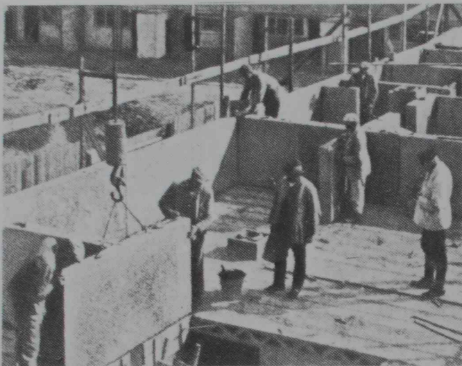
2. El montaje de paneles de hormigón premoldeado en las viviendas edificadas en Stuttgart en 1927 por E. May, inicia los modernos sistemas de adición de componentes producidos en grandes series: los grandes paneles prefabricados.
