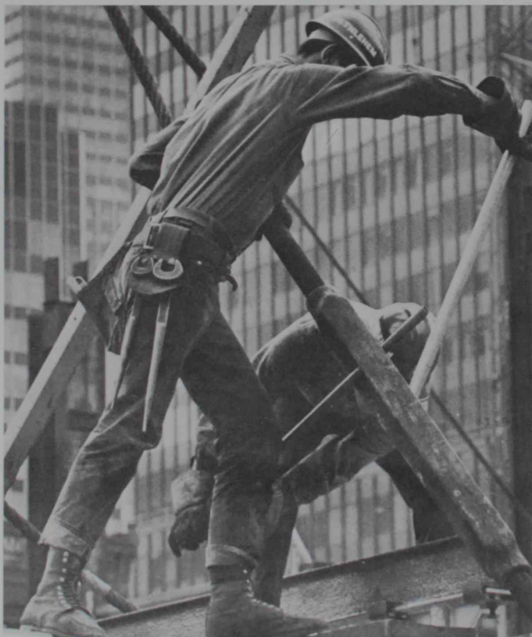
3. Estos montadores de un rascacielos americano ejemplifican unas transformaciones en el personal en obra que está en el límite de la evolución tecnológica y la división del trabajo.
