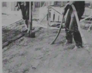
7. El total macizado del volumen a moldear se asegura con tratamientos de compactación. El más habitual es el vibrado.
