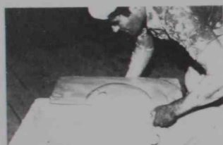
4. La fluidez de la pasta de yeso agiliza el proceso de fraguado y, por tanto, exige una gran habilidad al artesano para consumir, en este tiempo, el proceso de tendido.
