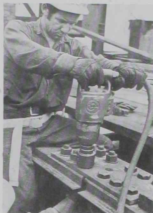
10. Para el atornillado de alta resistencia se recurre a herramientas de aire comprimido, que se desembragan al llegar al esfuerzo deseado.
