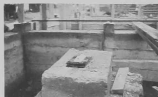
16. La expulsión de un adhesivo de resina bajo piezas de gran peso se evitó en esta obra de Viella colocando la resina dentro de unos marcos de neopreno. La elasticidad de los marcos garantizó la entrada en carga de la resina.
