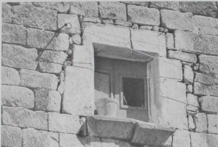
10. Los alféizares de piedra se rompen, como los dinteles, porque no son capaces de repartir sobre el muro la carga concentrada de las jambas, como en esta ventana de Uncastillo (Zaragoza).
