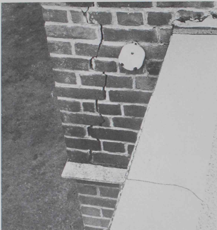
6. Los empujes térmicos de una azotea pueden ser importantísimos si no se prevén las juntas necesarias. Ningún antepecho, por rígido que sea, puede contenerlos.
