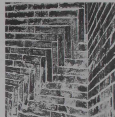
10. La magnífica ejecución de la fábrica de Brunelleschi con la rosca de ladrillos desplazados.
