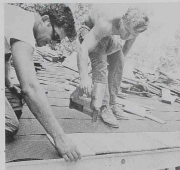
21 y 22. La grapadora neumática de tablillas de cubierta o la plancha que derrite y pega esa malla, para unir tableros, son ejemplos de la sofisticación de la herramienta en la puesta en obra de los semiproductos.
