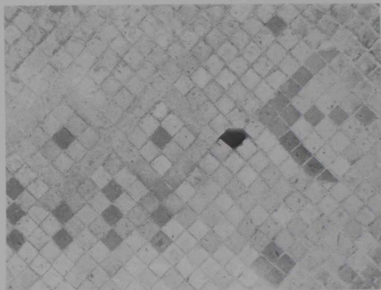
7. El virtuosismo a que llega Roma en estas formas de leve revestimiento del muro de hormigón lo evidencia este "opus reticulatum" de sorprendente dibujo policromo de un muro pompeyano.
