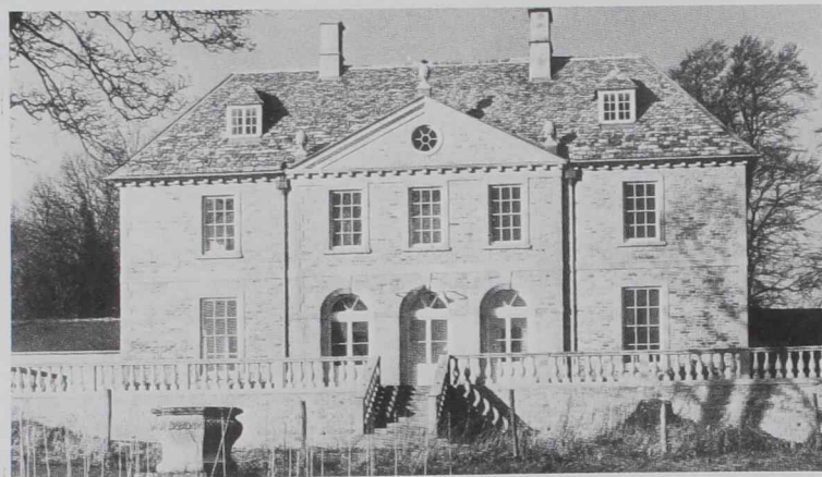
1. Quinlan Terry justifica su elección de los materiales tradicionales, como la piedra en la Waverton House de 1979, entre otras razones, por los bajos valores de su coeficiente de deformación térmica.
