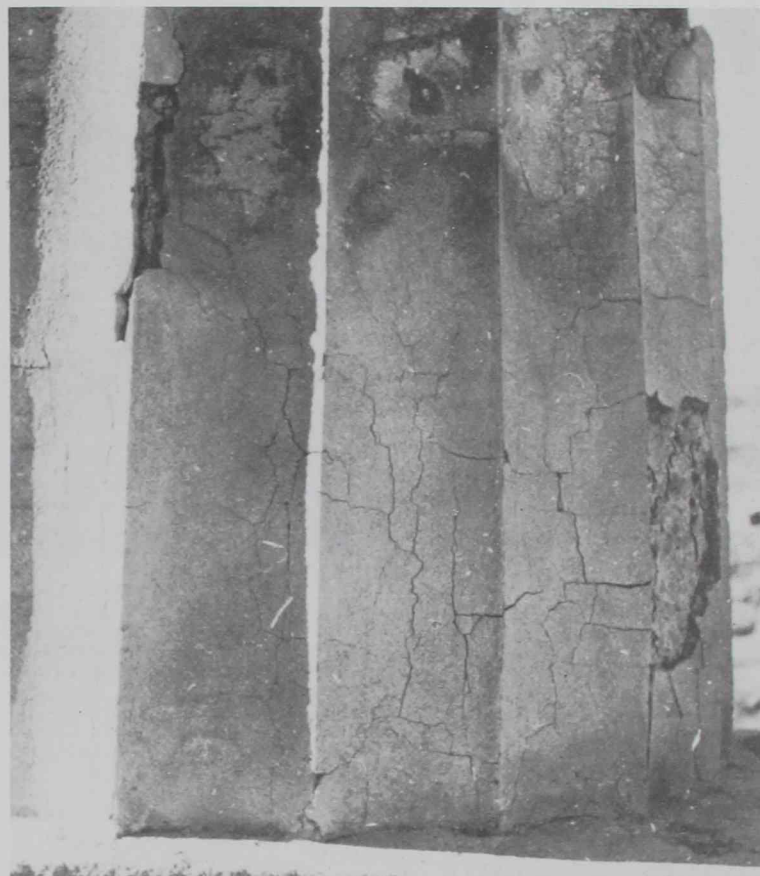
17. La retracción es una de las muchas razones que recomienda proscribir el mortero de cemento en la cosmética de las restauraciones. Templo dórico de Silene, en Sicilia.
