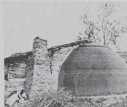
11. La extrusión continua de poliuretano se usó en las viviendas de emergencia tras los terremotos turcos. Los ocupantes no pudieron evitar la adecuación de este extraño "igloo" a su cultura con los elementos y los materiales locales.
