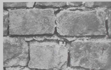
11. Esta fachada del "Convent dels Àngels", en Barcelona, ejemplifica el esquema de Viollet y el buen comportamiento de un muro de este tipo y de grandes dimensiones.
