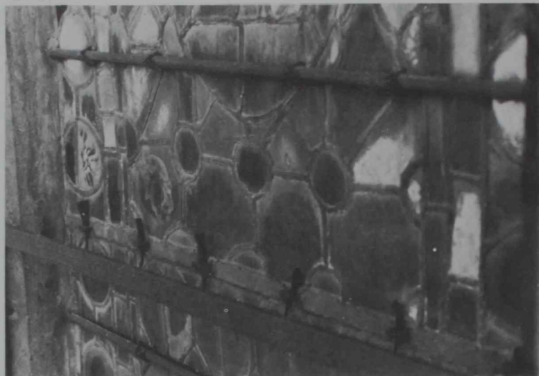
9. Las vidrieras góticas de la catedral de León recurren inteligentemente a una solución no coercitiva. Los importantes movimientos diferenciales de este complejo de vidrio, plomo, hierro y piedra quedan relativamente libres entre los puntos de fijación formados por estas cuñas.
