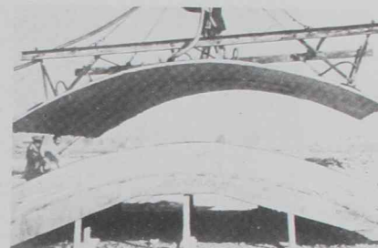
6. La ventosa es uno de los pocos sistemas exclusivamente modernos de elevación de componentes. La figura muestra la construcción de unas viviendas en Bogotá (Town Planning Associates, 1951).
