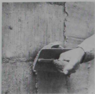
2. En el tendido, los materiales amorfos se conforman mediante un proceso de auténtica laminación entre el soporte y los diversos tipos de herramientas habitualmente manejadas.
