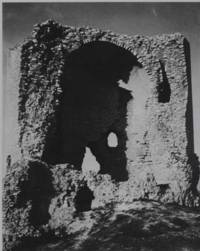
3. Para envolver el espacio habitable la arquitectura ha recurrido durante siglos a un solo material en cada edificio: el barro, la madera, la cerámica, la piedra, etc. El derruido castillo de Mota del Marqués muestra, en su sorprendente sección natural, el recurso sistemático a este último material en muros y bóvedas, y es un ejemplo de lo que se puede llamar la construcción homogénea.
