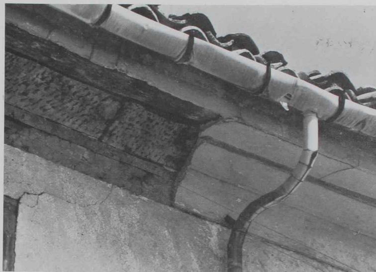
8. En esta cornisa morellana se puede apreciar el proceso de ejecución: Formación del soporte con tablas, repicado de las mismas con azuela para aumentar la adherencia y formación del moldurado por tendido con terraja.
