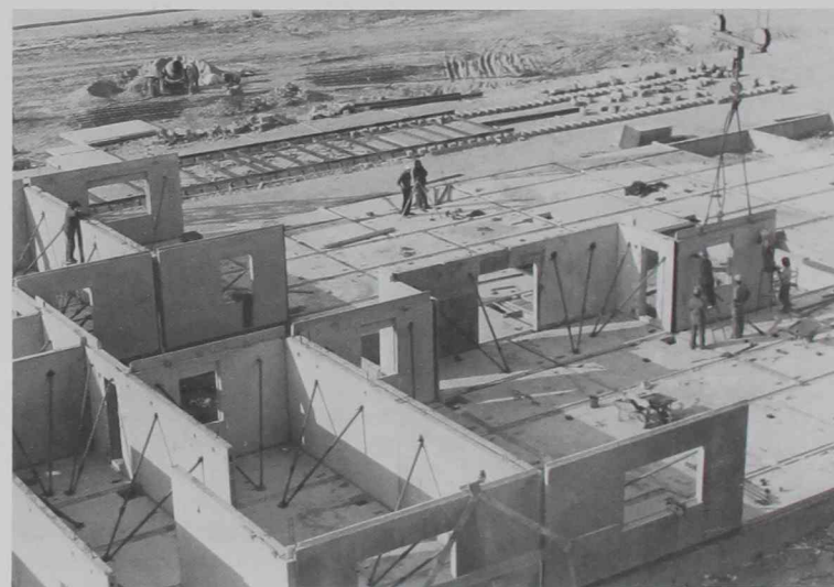
7. La estabilidad de los grandes paneles durante la ejecución de sus juntas exige un sistema de ajeos como el de estas viviendas prefabricadas construidas en Alcalá de Henares en 1975.
