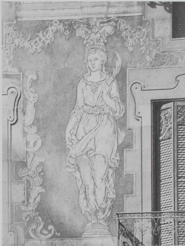
13. El esgrafiado, o dibujo por superposición de tendidos de diferentes tonos, es una de las más espectaculares posibilidades del tendido.
