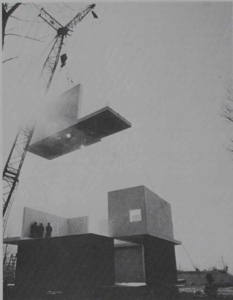
8. Los más modernos sistemas, antes de la crisis de la construcción, utilizaban piezas con geometría autoestable para facilitar el montaje.
