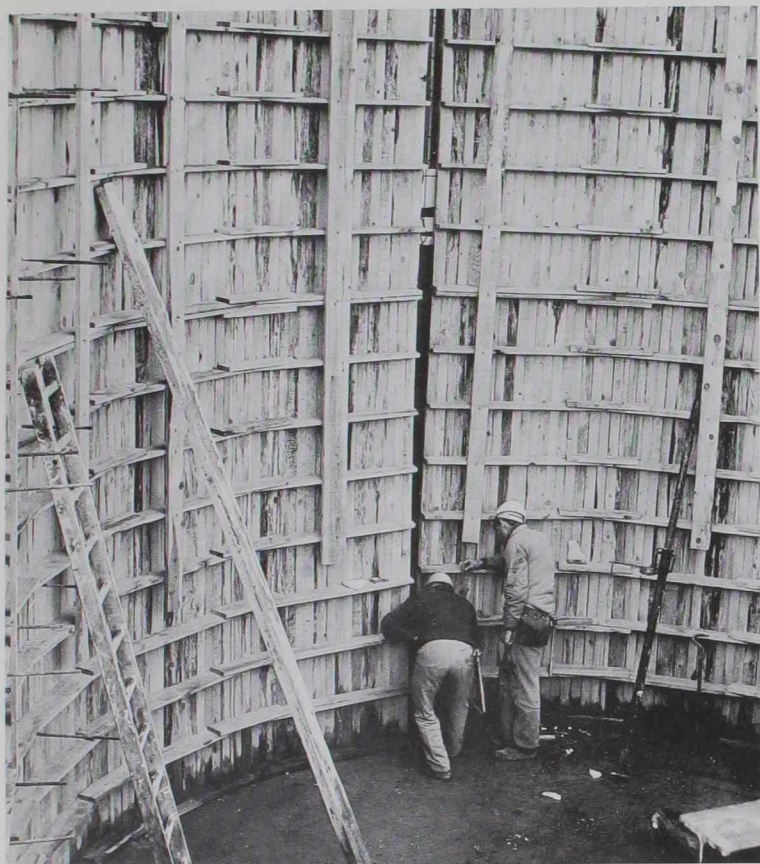
9. Los encofrados convencionales son de tabla con una estructura de soporte adecuada a su tamaño y situación.
