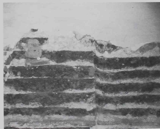
3. Este curioso tapial del Convent dels Àngels, en Barcelona, muestra una verdegada de cal cada 15 ó 20 cm.
