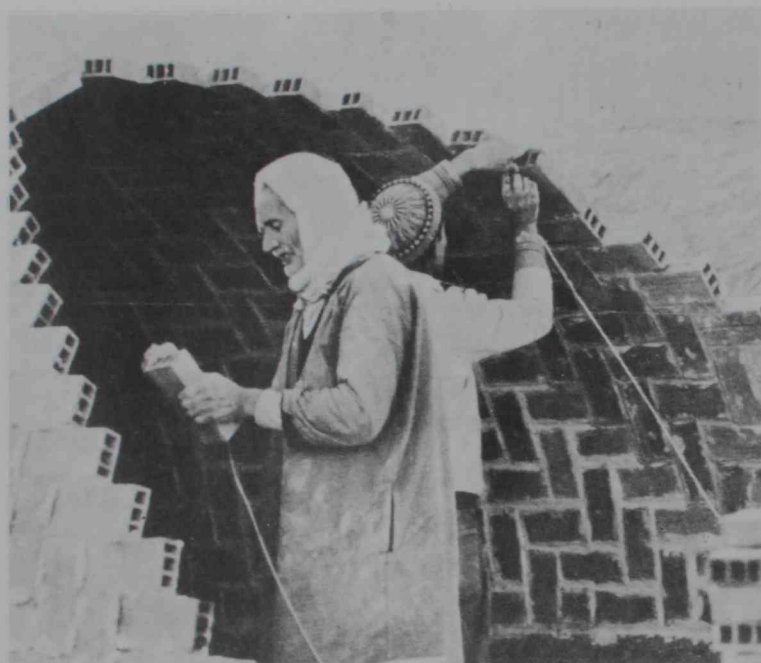
11. Los pequeños elementos se "adicionan" para formar elementos constructivos de mayor tamaño. La técnica más tradicional es la albanilería. La tradición artesana en el uso de pequeños elementos es vastísima. Estos alarifes tunecinos están construyendo una cáscara elíptica gracias al cordel atado a la muñeca, que les garantiza que, cuando lo tensan estirando el brazo, dibujan un círculo inclinado.
