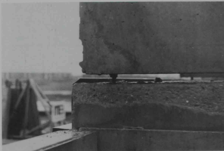
22. Los sistemas más modernos apoyan los paneles en un perno roscado que sobresale del panel inferior. El mortero que rellenará esa junta no se comprime hasta que no se afloja la tuerca (Sistema Jespersen).
