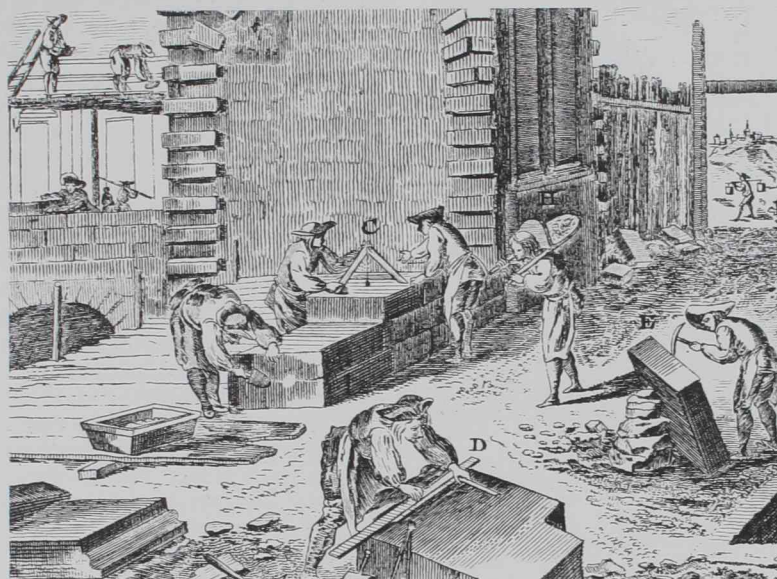
1. El grabado de la Enciclopedia de Diderot y D'Alembert muestra todo el proceso de la cantería. La puesta en obra de ésta es el modelo de cualquier adición de grandes conformados.
