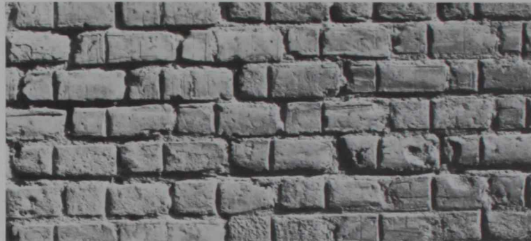
15. Los cuidados para que la fábrica ofrezca al tendido una base suficientemente rugosa pueden llevar a soluciones como esta de las murallas de Alcalá de Henares en que, a las llagas naturales, se han añadido otras obtenidas cortando los ladrillos.
