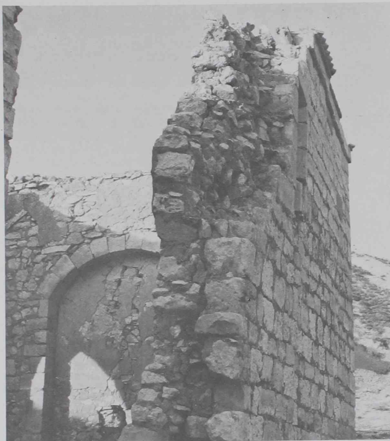
1. La Iglesia de Mota del Marqués muestra la estructura tradicional del muro de tres hojas. Las dos hojas exteriores están formadas por piezas de mayor tamaño y tienen, además, diferentes grados de talla. La interior, de relleno, está formada por elementos pequeños más o menos aglomerados.
