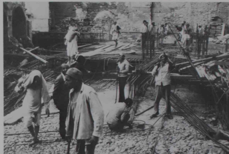
6. Transporte a hombros de los materiales de hormigón en una obra de El Cairo.
