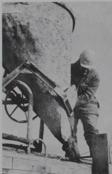
7. El cubilote, herramienta habitual de transporte y vertido del hormigón.
