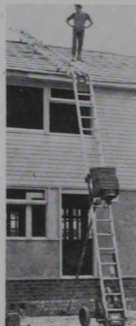
14. La escalera con elevador mecánico es una forma de la racionalización del movimiento de pequeños materiales.
