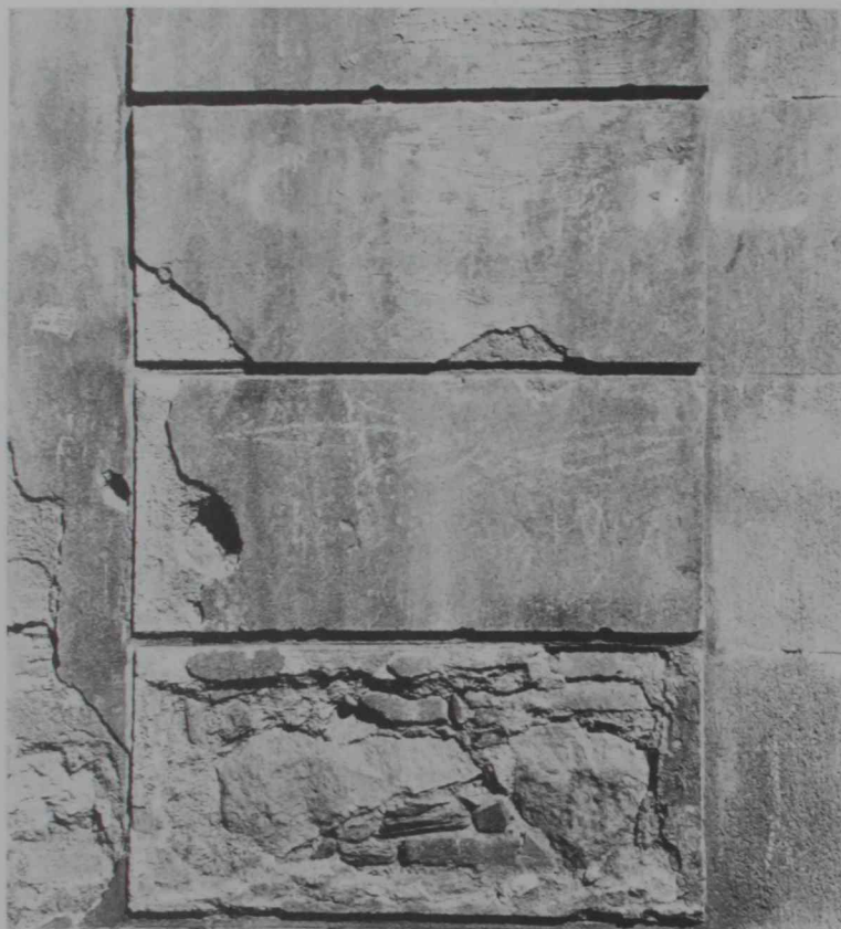
11. El revoco pétreo conseguía imitar la sillería a la perfección. Gaudí decía que Barcelona parecía al visitante una ciudad rica por la cantidad y calidad de sus imitaciones de la piedra.
