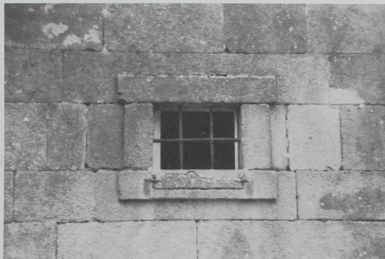
11. Para evitarlo, se puede recurrir al notable incremento de las dimensiones del alféizar que lo capacita para repartir la carga. Esa es la solución gallega, que se justifica por la abundancia de materia prima...
