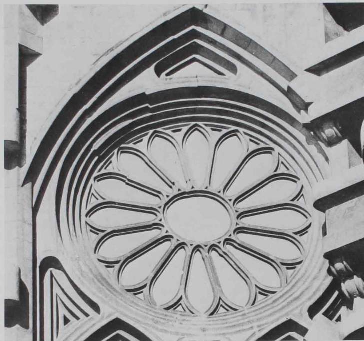
1. Las deformaciones que las acciones mecánicas producen en los materiales son uno de los más graves atentados contra su comportamiento solidario. La diferencia de compresiones entre el ábside y las torres ha producido este grave desorden en un rosetón de la Iglesia de la Sagrada Familia de Gaudí.
