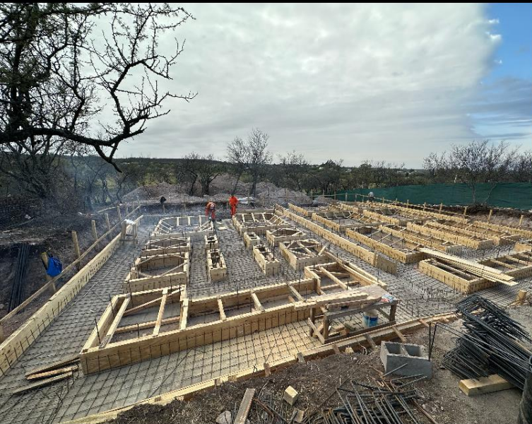
distribución de armaduras + encofrado
