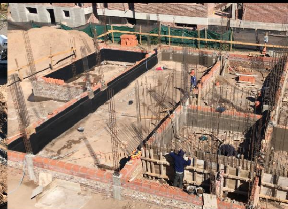
mampostería de fundación + capa aisladora
