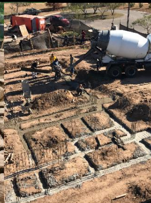
vertido de hormigón
