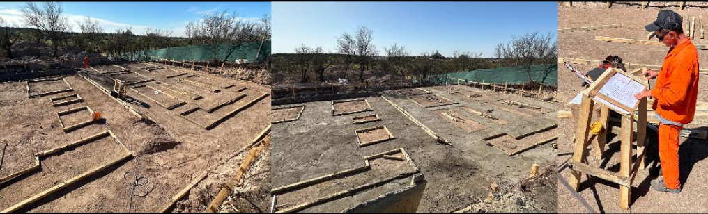
tareas preliminares + replanteo + hormigón de limpieza
