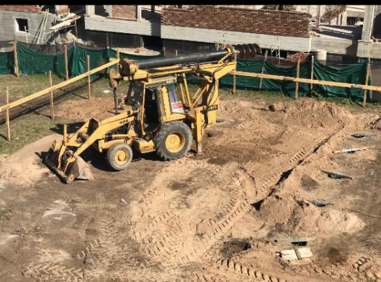
excavación mecánica de pozos-micropilotes
