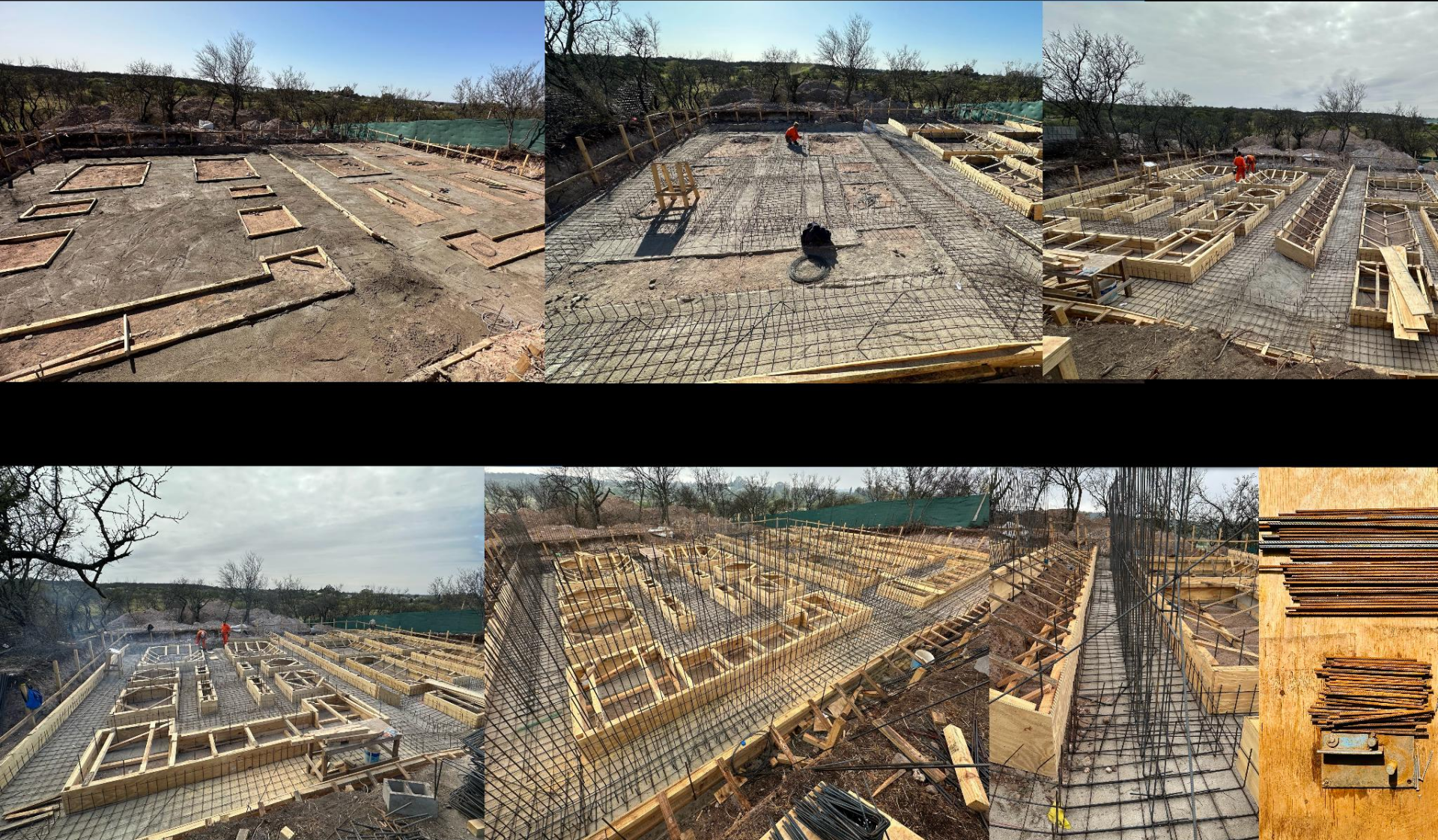
proceso de ejecución de fundaciones-armaduras-replanteo-encofrado-vertido de hormigón
