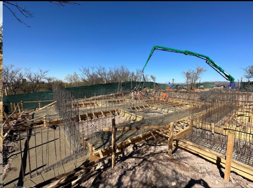
vertido de hormigón
