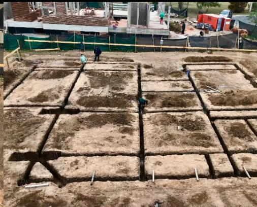
excavación vigas de fundación
