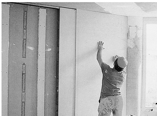
Tabique realizado con paneles de cartón yeso.
