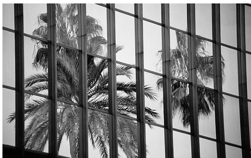
Muro cortina tradicional con vidrios reflectantes.
