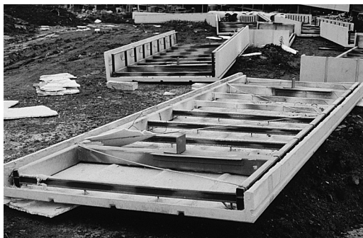
Panel de hormigón de fibra de vidrio rigidizado con una estructura de perfiles en espera de ser colocado. La cara que quedará visible es la oculta en la fotografía.
