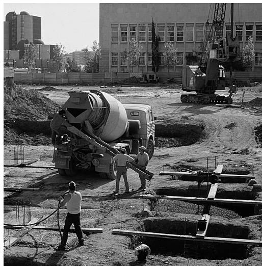
El camión hormigonera ha podido acceder a verter el hormigón en las zapatas. Los vertidos posteriores se realizarán con una grúa.
