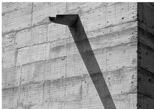
Detalle de la textura en la que aparecen casi caóticamente todos los episodios del hormigonado. La intención expresiva y plástica brutalista de todo el edificio está en perfecta sintonía con esa textura.
