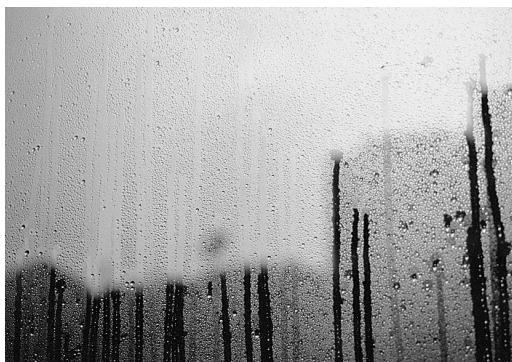
En invierno, el frío del exterior baja la temperatura del vidrio por debajo de la de rocío del aire interior.
