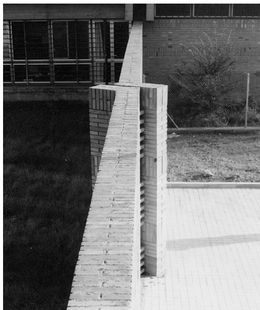
Otro lugar y otro punto de vista de la cerca anterior. El giro contrapuesto de los extremos de los dos lienzos de la cerca, además de añadir estabilidad, resuelve creativamente el problema de las dilataciones térmicas.
