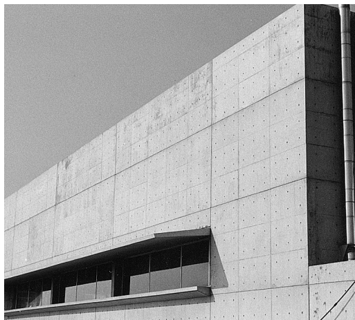
Muros de fachada portantes resueltos en hormigón armado.
