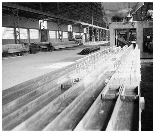
Fábrica de viguetas de hormigón.
