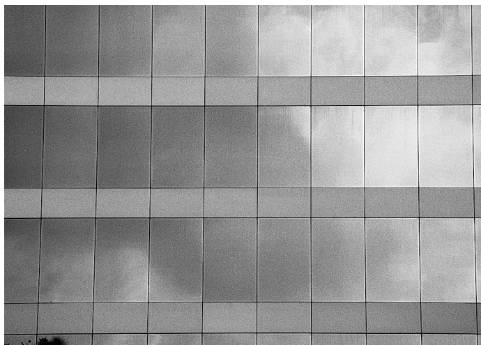
Imagen típica de una fachada de edificio de oficinas que permite una gran flexibilidad en las distribuciones interiores.
