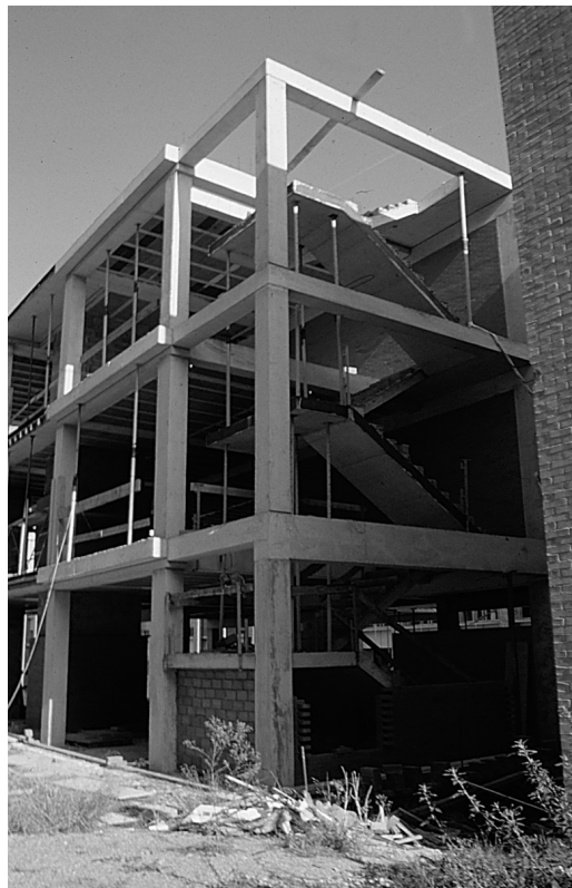
Estructura de pórticos de hormigón armado en espera de la realización de los cerramientos de fachada.
