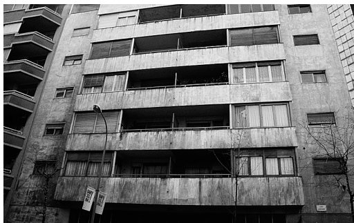
Edificio de la década de 1930 que no ha sido sometido a ningún proceso restaurador.
