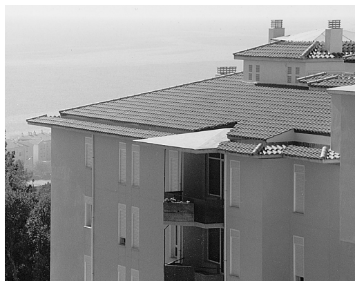
La fachada protege a la estructura y la cubierte a la fachada.
