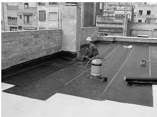
Fase de la realización de una cubierta plana en la que se coloca la tela impermeable.
