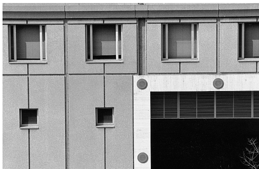
Fachada que combina los paneles prefabricados de hormigón con otro tipo de materiales.
