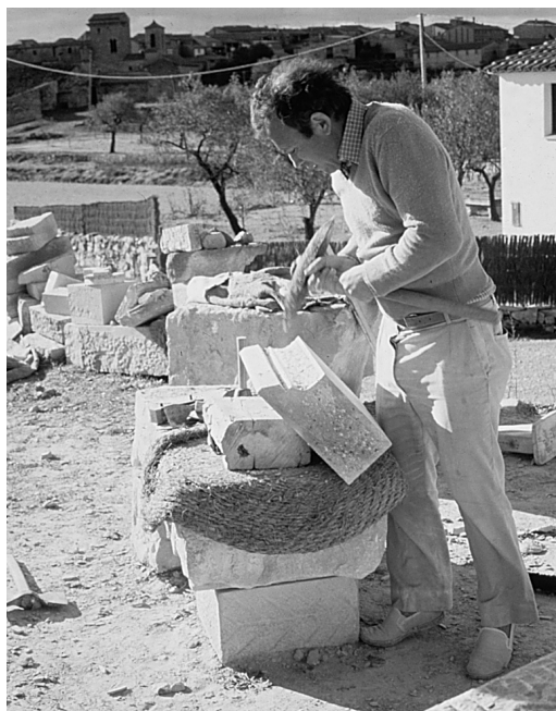
Cantero elaborando una pieza moldurada para la restauración de edificio histórico.
