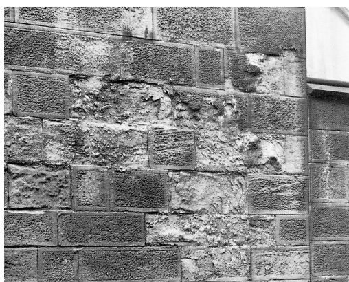
Efectos de la contaminación ambiental sobre sillares de piedra caliza. Las diferentes intensidades se deben a diferencias en el origen de las piedras.
