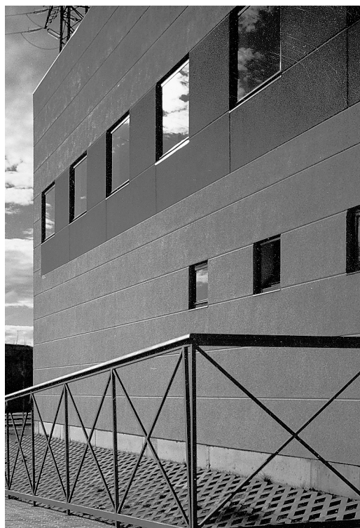
Revestimiento monocapa de dos diferentes texturas con sus juntas de trabajo y retracción formando parte de la composición de la fachada.
