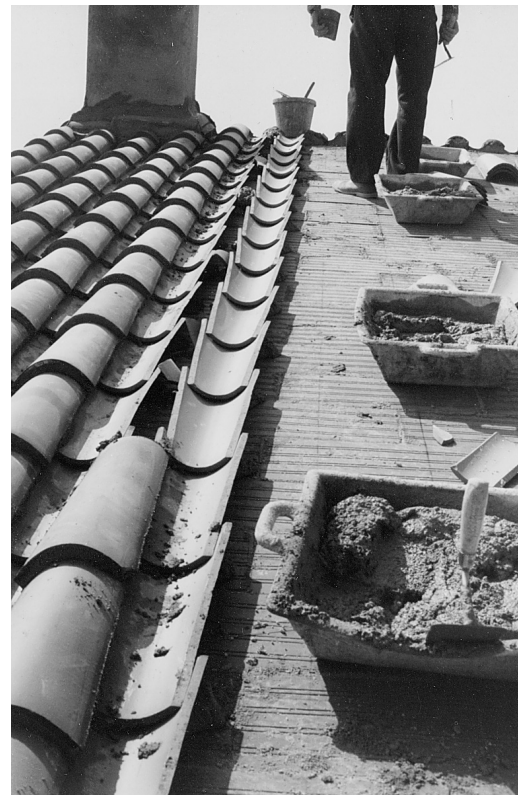
La especial forma de las tejas árabes permite cubrir una gran superficie con un solo tipo de pieza.
