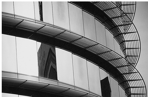
Fachada orientada al sur que combina el efecto protector de los vidrios reflectantes con un parasol ( brise-soleil ) cuya eficacia máxima se aprovecha cuando es más necesaria, en verano.
