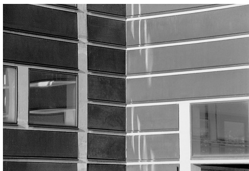
Fachada en la que el cerramiento realizado con paneles con cara exterior de acero mate se encaja entre los elementos de hormigón blanco visto de la estructura.
