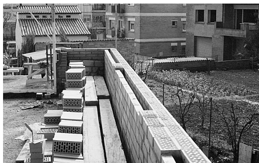
Sección típica de una fachada actual de ladrillo en fase de realización.
