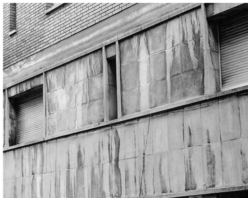
Efectos del lavado desigual de las fachadas.
