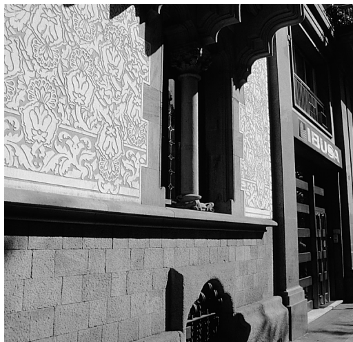
Esgrafiado modernista situado sobre un zócalo de sillería.
