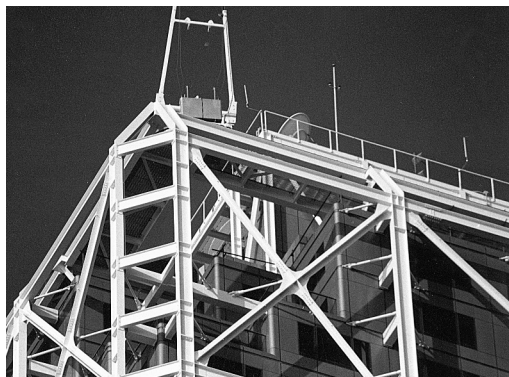
El perfil del edificio queda configurado por la linealidad de los elementos vistos de la estructura portante.
