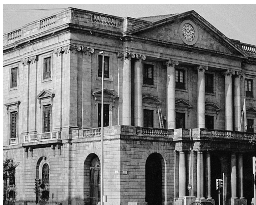
Los texturados muros de fachada de la arquitectura clásica (o neoclásica) asumen simultáneamente el papel estructural y de cerramiento con una buena resistencia al paso del tiempo. Los huecos son de formato vertical y reducida anchura y están siempre situados unos sobre otros. Los frontones, cornisas e impostas alejan la lluvia de los lienzos de las fachadas. Las leyes del descenso de cargas y de la duración configuran creativamente la expresión general de todo el edificio.
