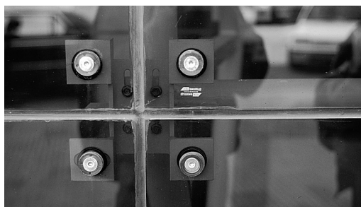
Primer plano de los puntos de anclaje y del sellado de silicona de la fachada que aparece en la página 211.
