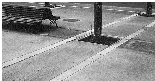
Juntas de retracción resueltas por la interposición de bandas de baldosas de piedra forman parte de la composición global en la que también aparecen juntas serradas perpendiculares a las anteriores.
