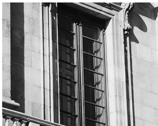
La carpintería de las puertas balconeras se adapta a las dimensiones posibles de los vidrios.
