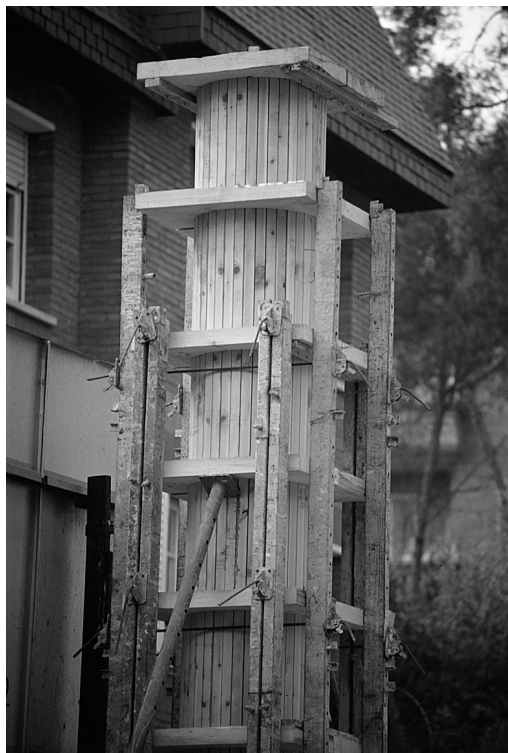
Encofrado de madera.
