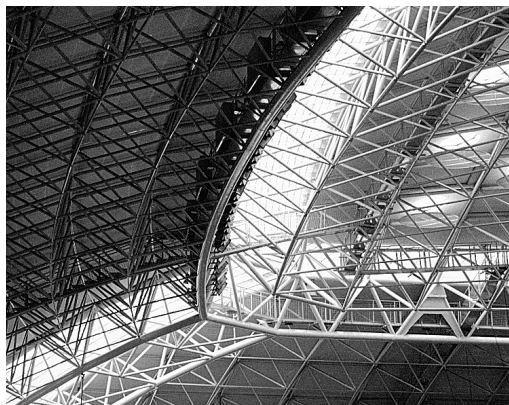
Si la triangulación se realiza en tres dimensiones, se obtiene una malla espacial que cubre el espacio en dos direcciones simultáneamente.
