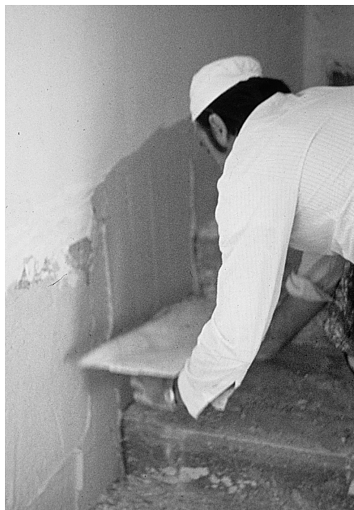
Momento en el que el yesero extiende la pasta de yeso sobre la pared.
