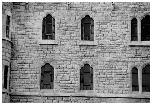
Fábrica, algo posterior en el tiempo a la anterior, de sillarejos de piedra caliza dura más difíciles de trabajar.
