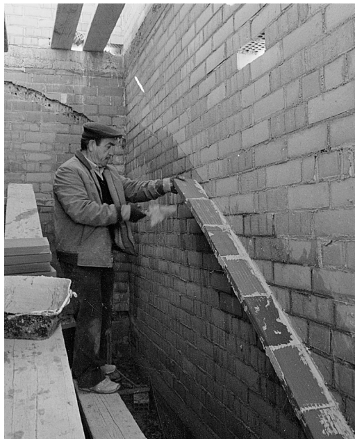
Puesta en obra de la primera hilada de la primera hoja de una bóveda a la catalana. A pesar de que la foto es actual, se ha de decir que es una técnica casi olvidada.
