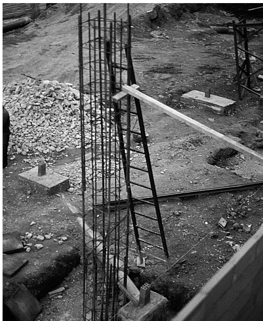
Armadura del pilar, apuntalada de manera algo precaria y solapada con la que sobresale de una zapata de cimentación, denominada armadura de espera.
