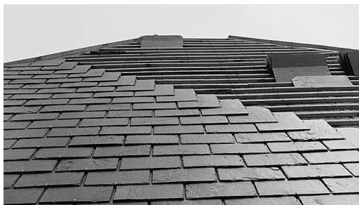
La forma plana de las piezas de pizarra exige un doble solape.
