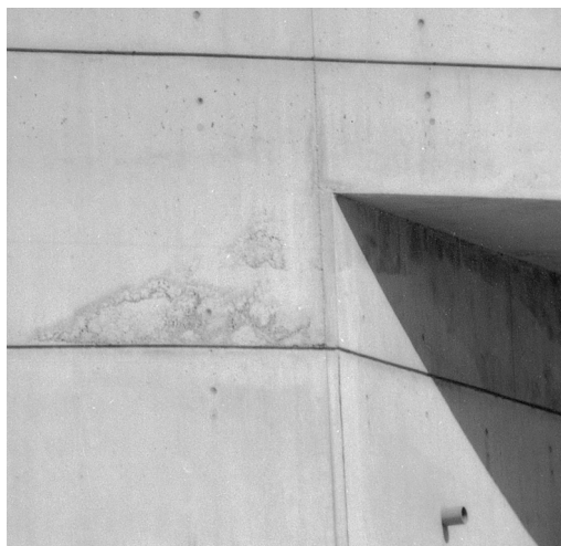
Contraste entre una textura que no puede dejar de ser subsidiaria de un cierto desorden en los episodios del hormigonado y una intención plástica global mucho más depurada.
