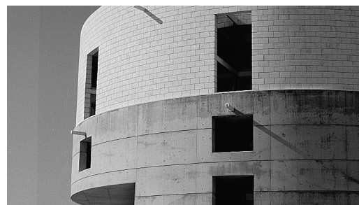
Edificio administrativo situado delante del mar. Las vistas se establecen a través de los patios abiertos en fachada con visuales en escorzo combinadas con reflejos en los vidrios enfrentados. La iluminación natural se refuerza con un patio interior.
