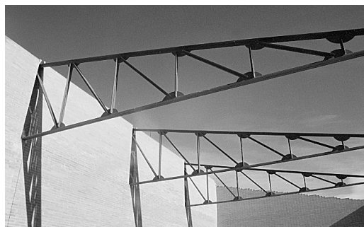
Armaduras de acero en espera de que se monten las correas que han de soportar el material de cubierta.
