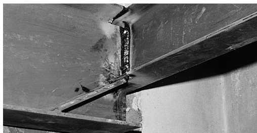
Soldadura realizada in situ entre dos perfiles IPN de acero.
