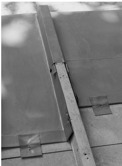
El doblado de las láminas de cobre permite juntas estancas para cualquier pendiente superior al 5 %.
