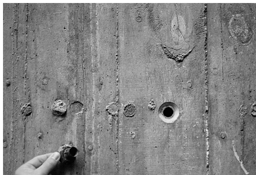
Diferentes huellas del encofrado de madera sobre los paramentos de hormigón visto.
