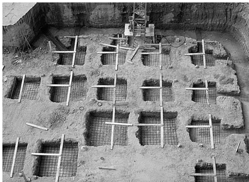
A la excavación general, cuya profundidad se advierte por el corte del terreno de la parte superior de la fotografía, le ha seguido la excavación de las zapatas de cimentación.
