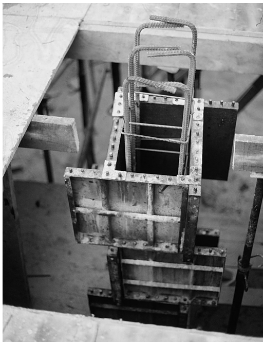
Encofrado metálico usual.
