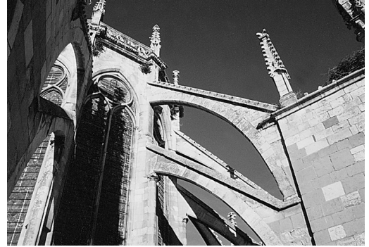
Los arbotantes reciben las cargas de los arcos interiores de la nave y las transmiten a los contrafuertes.
