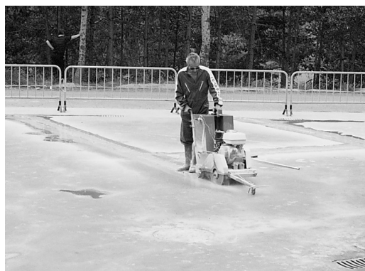
Corte de un pavimento de hormigón.
