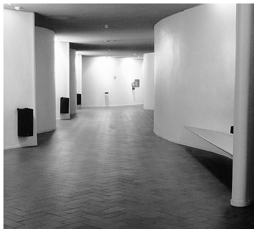
Aspecto final de los paramentos de una compartimentación realizada con tabicones de directriz curva enyesados y esmaltados de blanco.
