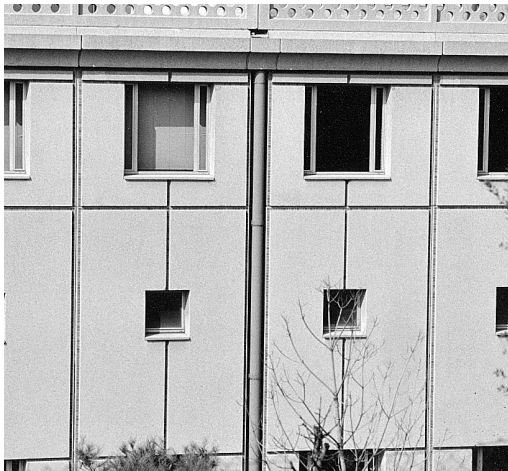
Diversos tipos de juntas entre paneles prefabricados y con las carpinterías de las ventanas.
