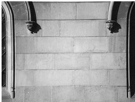
Fábrica decimonónica de sillares de piedra arenisca que permite con facilidad la realización de molduras.
