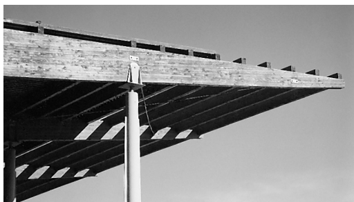
Apoyo y extremo en voladizo de la viga anterior.
