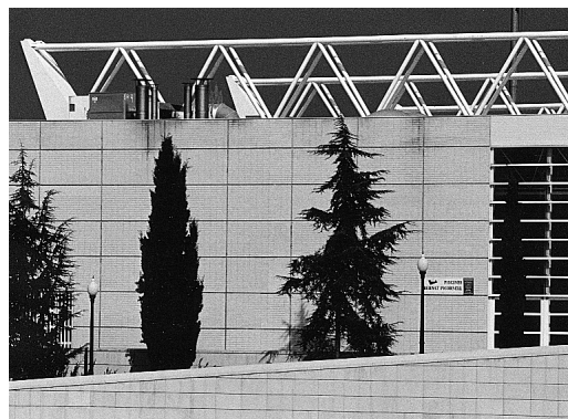
La estructura de soporte de la cubierta configura el perfil del edificio y queda en unas buenas condiciones de accesibilidad.
