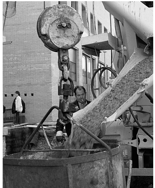
Paso del hormigón de la hormigonera al cubilote.
