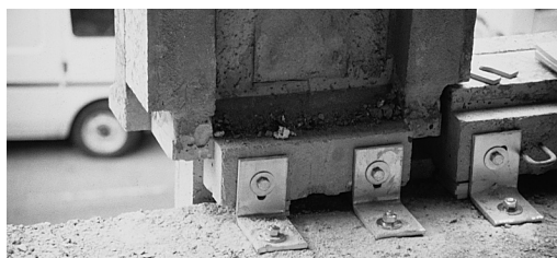
Unión de un panel prefabricado al forjado por medio de angulares de acero con dos fijaciones cada uno.
