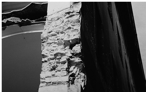
Sección del muro exterior del edificio del siglo XIX visto en I-1.
