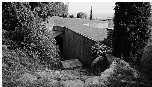
Acceso a una vivienda semienterrada por tres razones: adaptación al terreno, protección del ruido de una carretera próxima y ahorro energético tanto en verano como en invierno.
