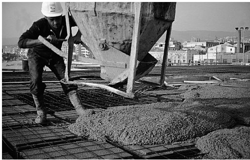
Momento en el que la masa amorfa del hormigón se vierte desde el cubilote sobre el elemento con sus armaduras.
