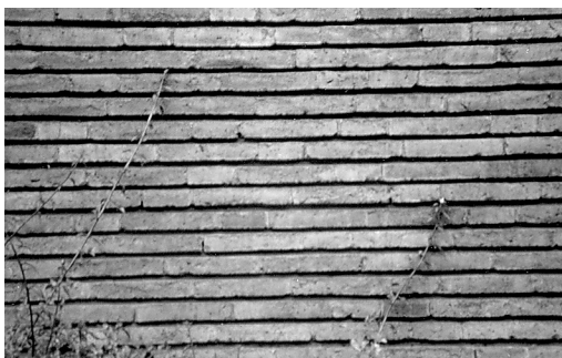
Aparejo de sogas en el que se ha enrasado la llaga y rehundido el tendel con el fin de obtener un efecto plástico de dominio de la horizontalidad de las hiladas.
