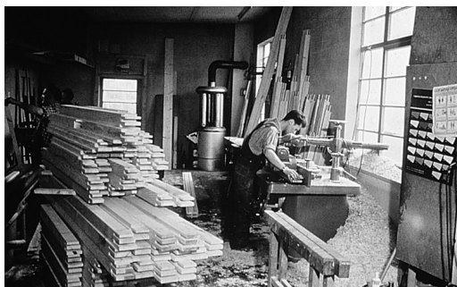
Taller de carpintería con un acopio de madera aserrada.
