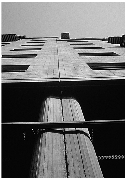
Junta de dilatación que divide el edificio, estructura y envoltente, en dos partes totalmente independientes entre sí a efectos térmicos.
