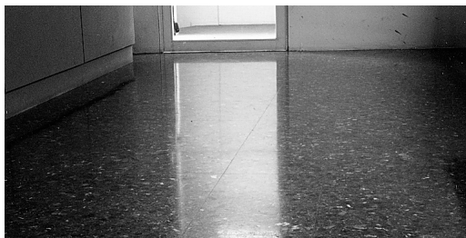
Pavimento de baldosas de terrazo pulido in situ.
