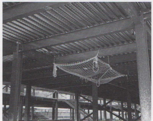
Vista inferior de un forjado de chapa plegada sobre vigas de acero.
