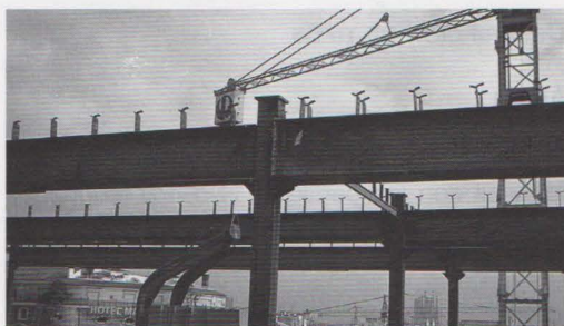
Vigas mixtas a la espera de realizar la cabeza de hormigón.
