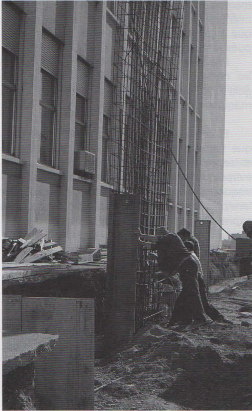
Momento en el que los operarios introducen la armadura del tramo en ejecución del muro pantalla.
