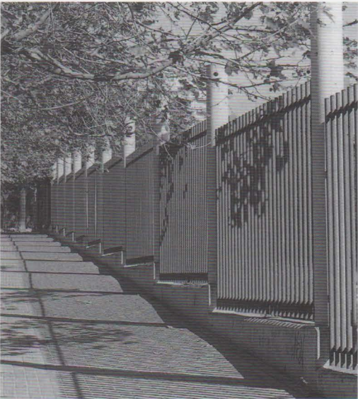
Cerca compuesta de estructura de hormigón armado empotrada en el terreno, con plementería de redondos de acero, diseñada para adaptarse con facilidad al desnivel.
