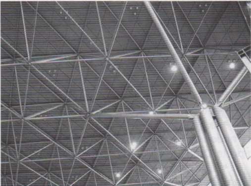
Malla espacial de tubos de acero.
