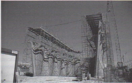
Proceso de construcción de unos muros alabeados de generatriz recta y directrices sinusoidales desfasadas en planta. La cubierta del edificio, con una forma similar realizada posteriormente, también es de fábrica armada.
