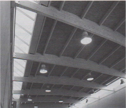
Jácenos de madera laminada.
