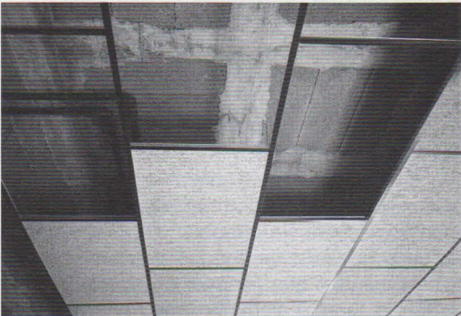
Techo colgado de un forjado reticular en fase de montaje.
