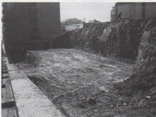
En este caso se ha procedido a dos desmontes escalonados ya que la rasante del terreno natural estaba más alta que la de la calle.
