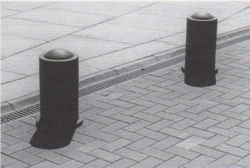
Detalle de los dos pavimentos de la foto II-p. 25. En primer término, adoquines de hormigón; en segundo, las losas de granito sobrealzadas (ver detalle en III-p. 202). La separación entre los dos tipos se destaca por el canal de recogida de aguas; los mojones impiden el posible tránsito pesado que no podrían resistir las losas.
