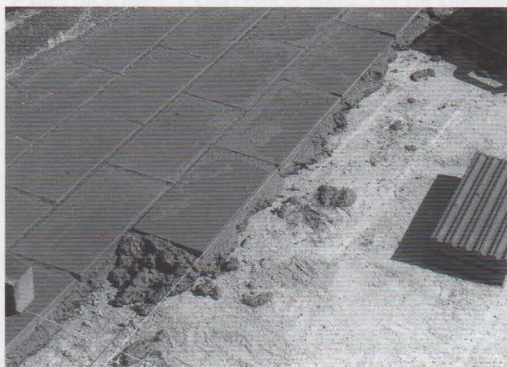
Colocación de baldosas cerámicas delgadas, denominadas rasillas, para un pavimento de azotea.
