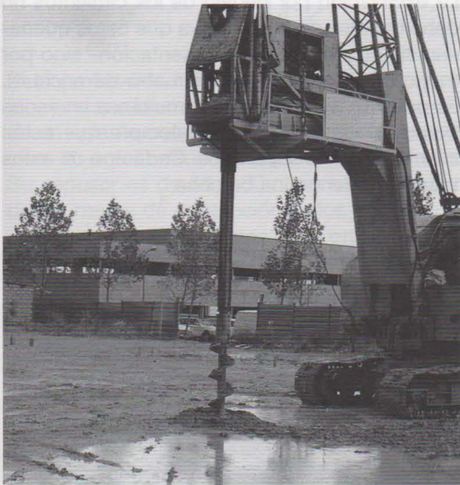
Perforación de un pilote.
