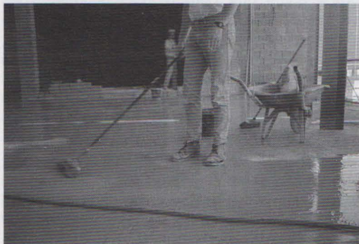
Tendido de la lechada de cemento sobre el embaldosado de terrazo.
