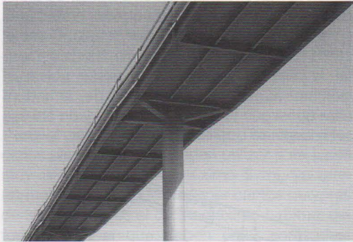
Vigas de acero de una pasarela.
