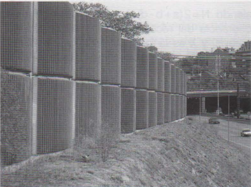
Barrera no absorbente formada por paneles prefabricados de hormigón, arriostrados por perfiles de acero ocultos detrás.
