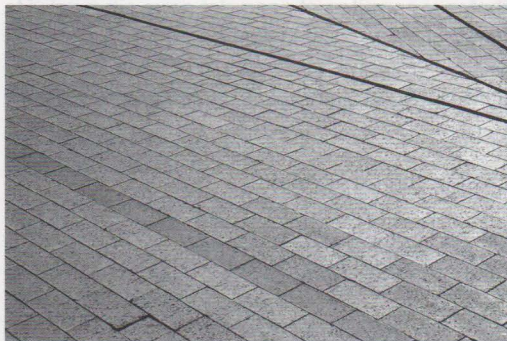
Las juntas y el color estructuran este pavimento de adoquines de cerámica.
