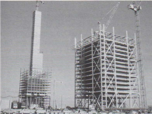
Dos rascacielos de construcción simultánea presentan las dos modalidades básicas de estabilidad horizontal.
