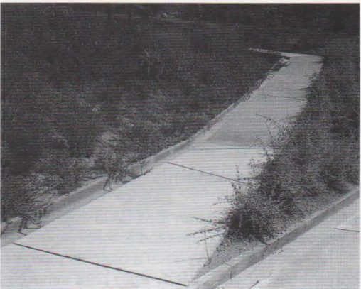
Camino pavimentado con hormigón de textura lisa en la zona a nivel y rugosa en la pendiente.
