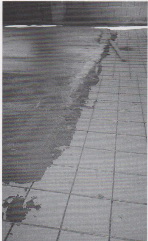
Losa flotante de hormigón sobre aislante de poliestireno expandido elasticado en proceso de realización.
