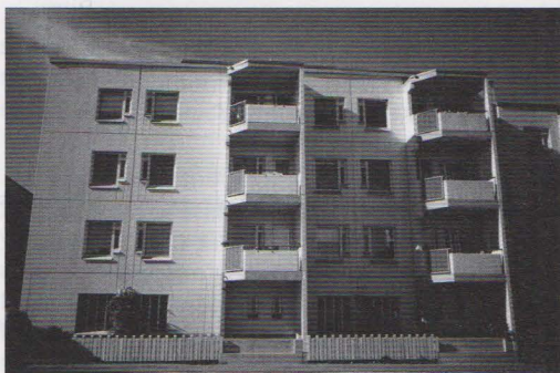
Edificio de viviendas resuelto con paneles y losas prefabricadas de hormigón blanco con un sencillo pero depurado diseño. Mediante unas sencillas incisiones en las proximidades de las juntas entre paneles se reduce el efecto visual negativo de éstas.
