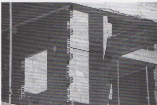
Tabique de ladrillo doble hueco.
