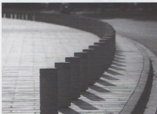
Piezas prefabricadas de hormigón, empotradas en la base en el terreno, sobre acera de losas de piedra. A la derecha, bordillo, rigola y pavimento bituminoso.
