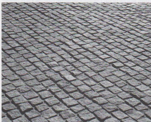
Adoquines de granito fijados con mortero.
