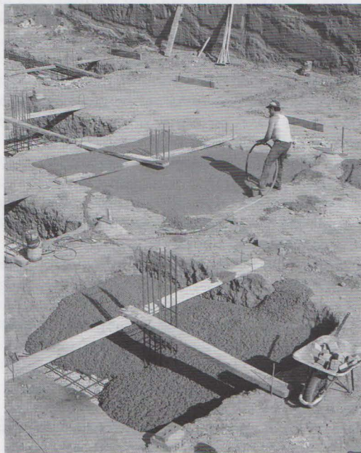
Hormigón recién vertido en un zapata superficial.
