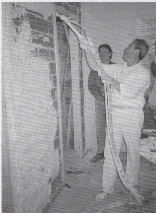
Revestimiento de yeso en proceso de ejecución mediante la técnica de proyectado.
