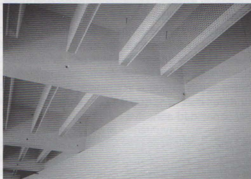
Los paneles colgados del techo (un sándwich de yeso laminado perforado y absorbente) se han añadido para compensar la intensa reverberación producida por las superficies pintadas de ladrillo en paredes y hormigón en techos.
