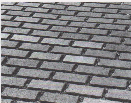
Adoquines de hormigón que incorporan separadores para dejar la junta abierta que permite la presencia vegetal.
