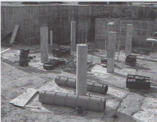
Pilares de hormigón armado de diferentes secciones.
