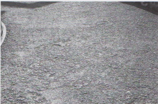
El aglomerado asfáltico es la solución habitual para el tráfico rodado, aunque también puede serlo para el peatonal.
