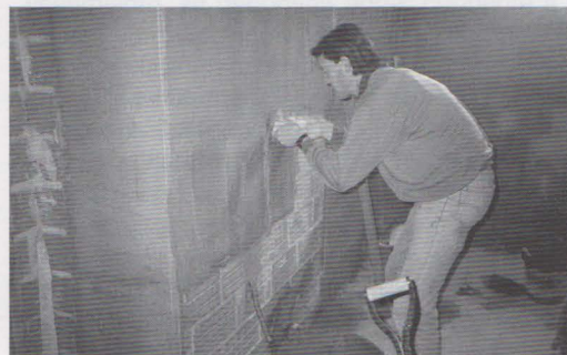
Enfoscado en proceso de ejecución mediante la técnica del tendido.
