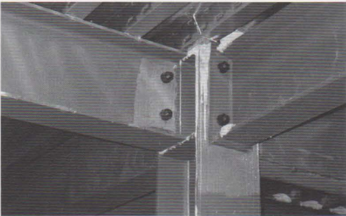
Unión de vigas y jácenas resueltas por atornillado.
