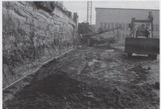
Una vez acabado el muro y realizado un primer rebaje de tierras, la perforadora está preparando el anclaje del muro al terreno.
