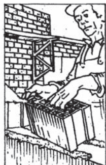
. colocación en el muro
