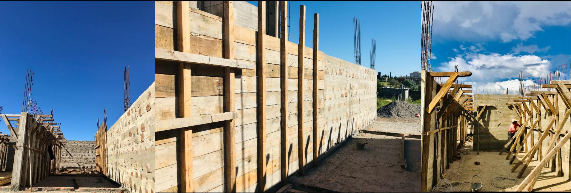
obra en La Cascada-Cordoba
