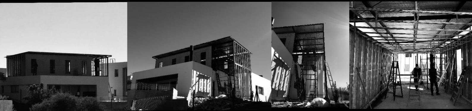
obra vía seca- ampliación planta alta El Rodeó
