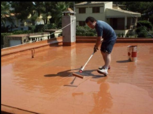
aplicación de membranas líquidas
