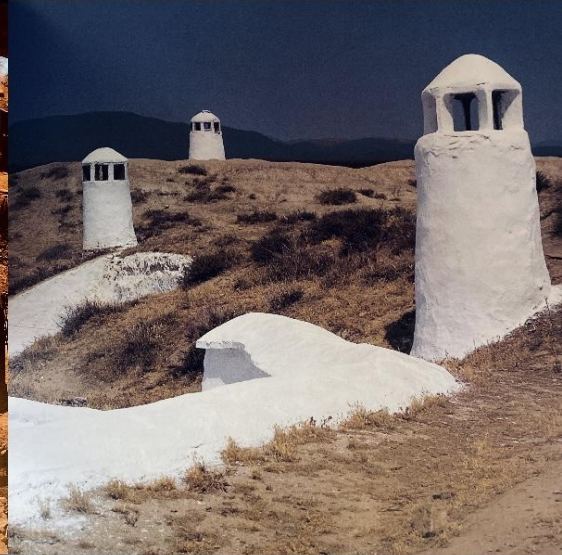
cubiertas y técnicas
