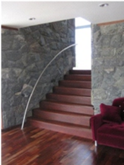
Zanca rampante de escalera de H^\circ A^\circ evitando el salto del pasamanos en el giro. La estructura es una losa inclinada (rampa)
