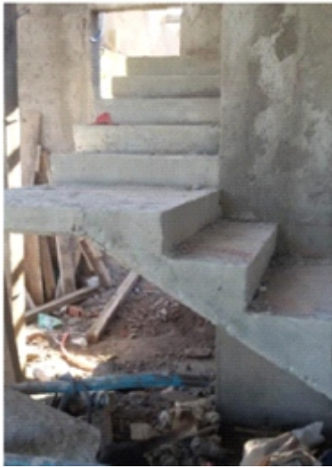
Zanca rampante de escalera de H^\circ A^\circ evitando el salto del pasamanos en el giro. La estructura es una losa inclinada (rampa)
