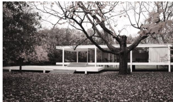
Casa Farnsworth, 1945/1951 - Mies Van Der Rohe. Plano, Illinois, USA
