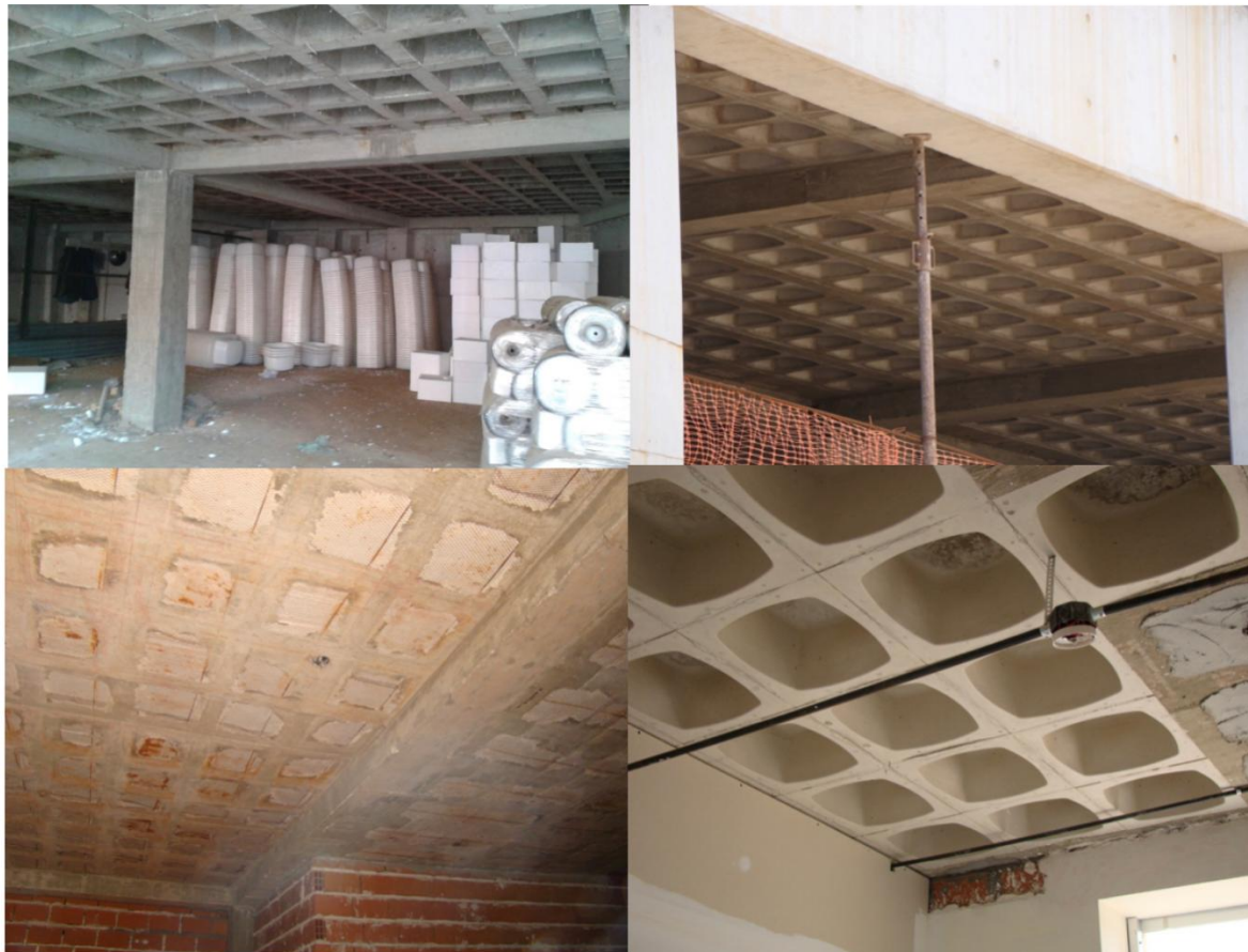
estructura de hormigón armado alivianado, losa nervurada.
