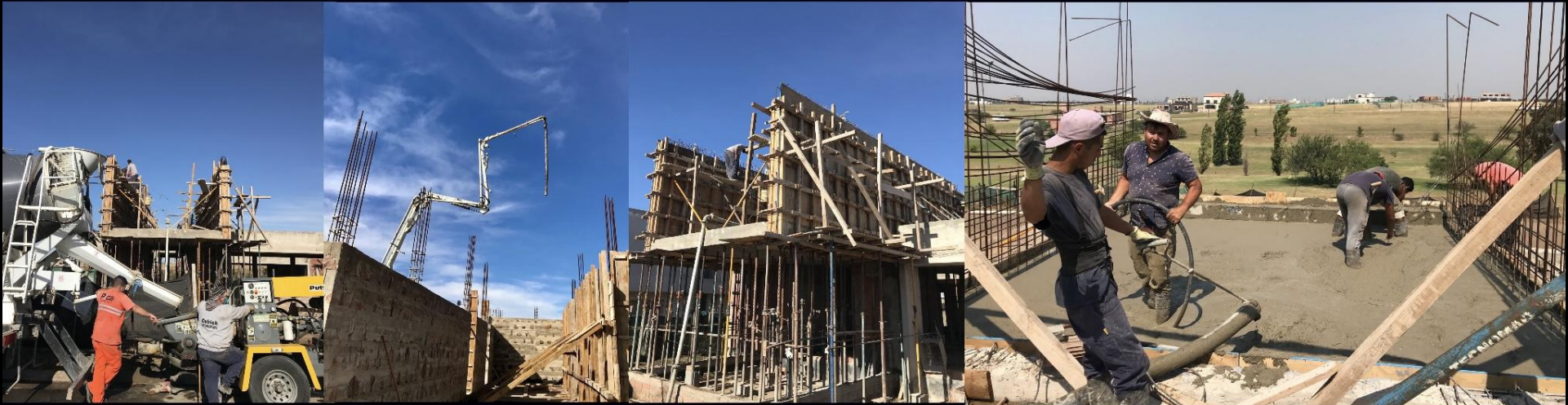
estructura de hormigón armado visto
