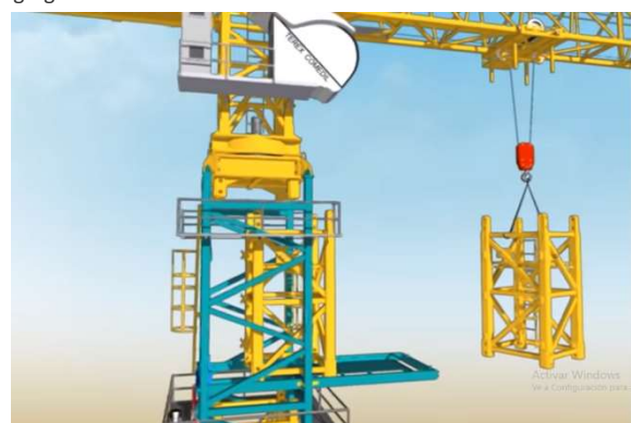
K - la altura final de la grúa dependerá de la cantidad de tramos agregados
