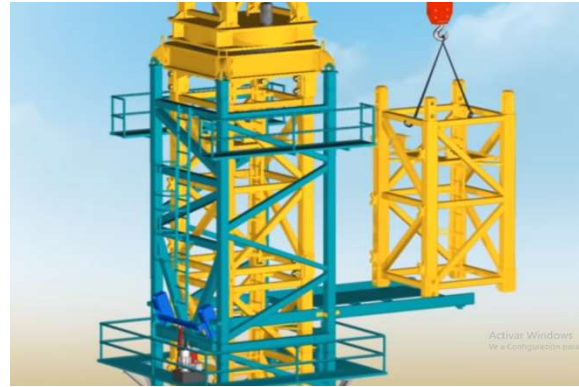
J - elevación de la grúa por medio de los elevadores hidráulicos
