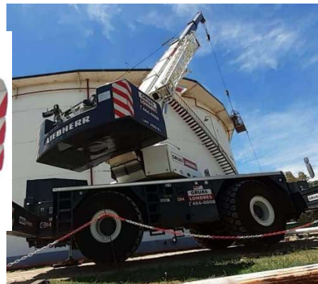
8 – Grúas terex con contrapesos en primer plano.
