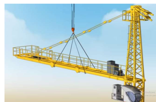
H – montaje de contra pluma
