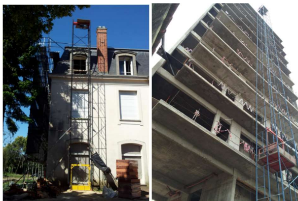
18 – torre de elevación. 500kg – 37 metros útiles
