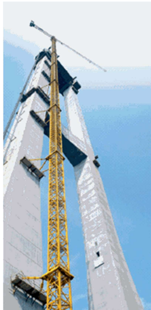
37 – grúa torre vinculada a la estructura construida
