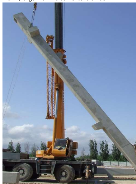
29 - Grúa Grove RT 88/S - capacidad 80t, pluma telescópica 12,6 – 41,1m, largo máximo con extensión 68m -
