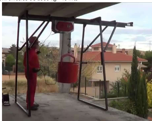
16 - Estructura para electroguinche 800/1000/1500 kg electroguinche JORI trifásico de 1000 kg - 40 mts
