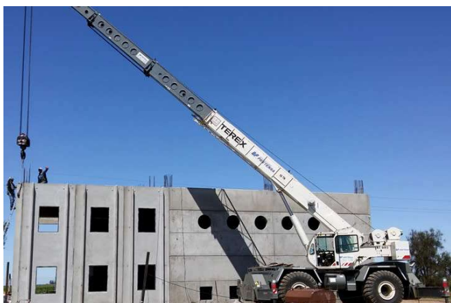
30 - Grúa Terex y Grove en proceso de izaje
