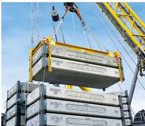
33 – montaje de placas de contrapeso de 25t
