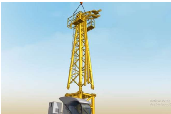
G – montaje de punta de torre
