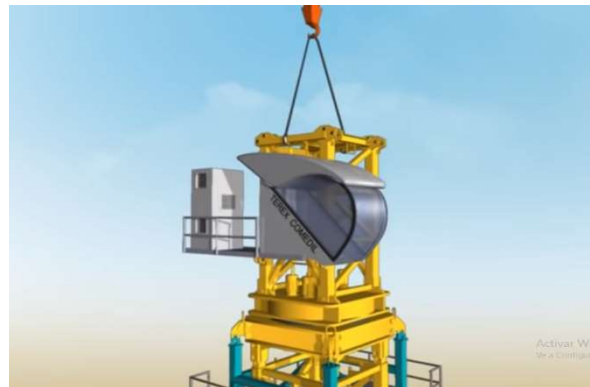
F – posicionado de cabina de mando
