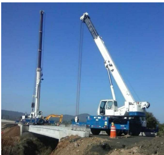
25 – Grúa AT- y TM de distinta capacidad y dimensiones de 2 – 3 -4 -6 -7 – 8 y 9 ejes.
