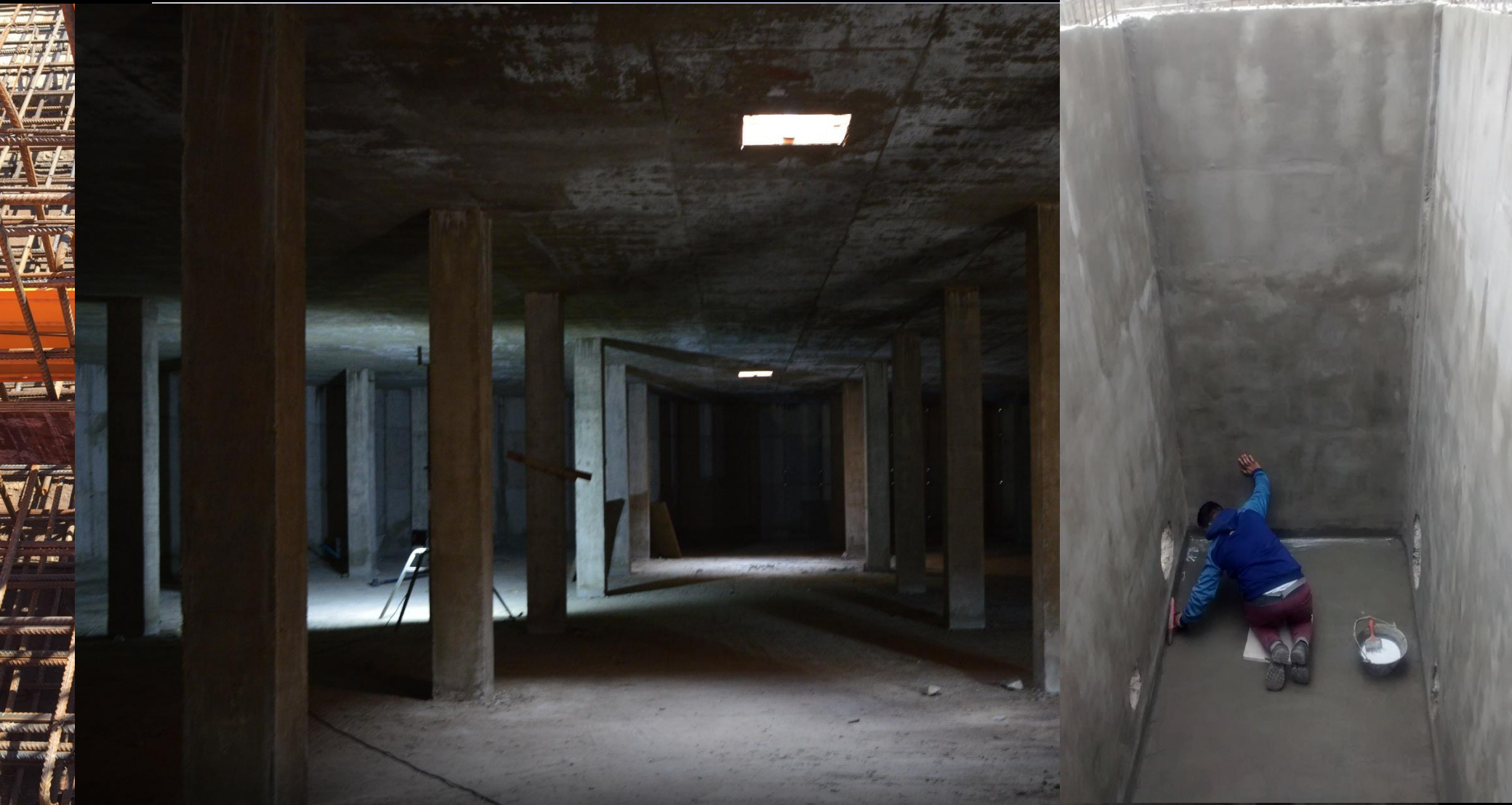
Gobierno de la Prov. De Córdoba – Planta potabilizadora Cruz del Eje
