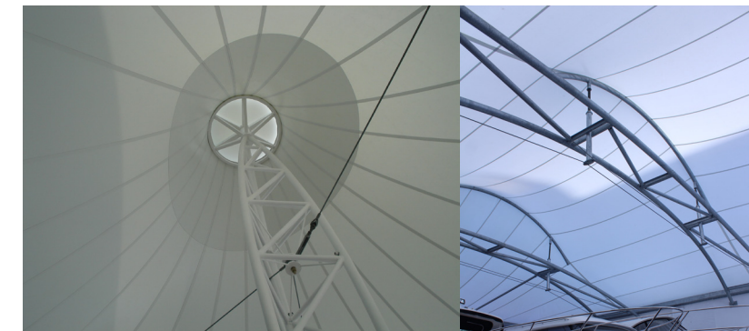
APOYOS EN PUNTOS ALTOS: MÁSTILES Y ARCOS SOLICITADOS A COMPRESIÓN
