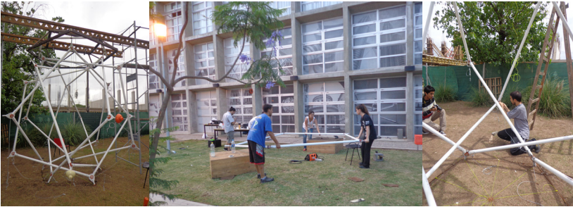
PROCESO DE MONTAJE. ESTRUCTURA AUXILIAR
