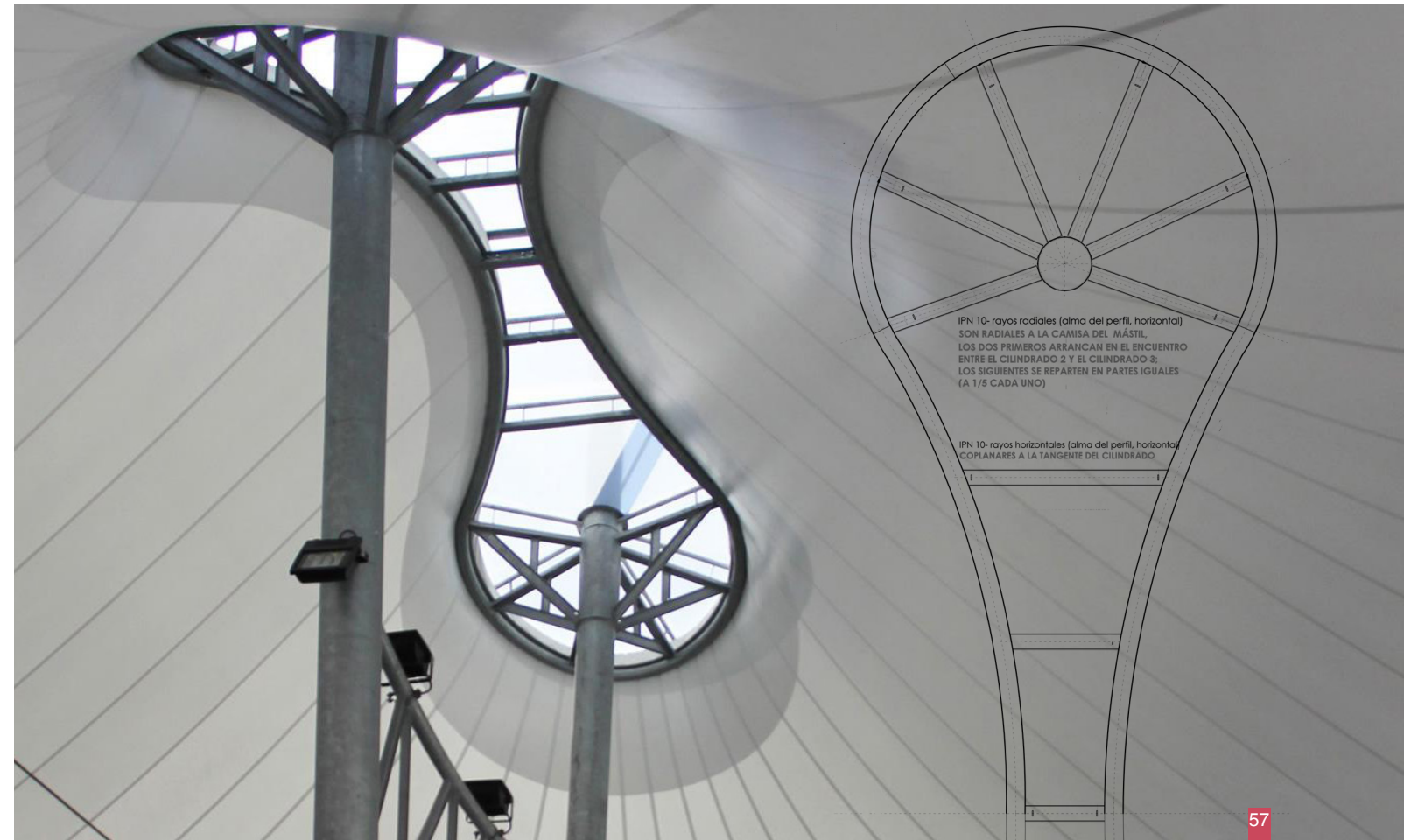
DETALLE MÁSTILES CENTRALES Y LINTERNAS
