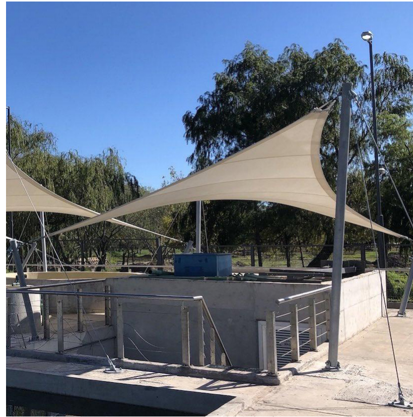
ACUARIO DEL RIO PARANÁ | DINALES SA | WAGG | ARQUITECTURA TEXTIL ANCLAJES EN PUNTOS BAJOS MEDIANTE TENSOSES SOLICITADOS A TRACCIÓN
