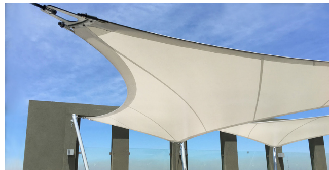
TERRAZA EDIFICIO DATASTAR I ESTUDIO ASZ ARQUITECTOS
