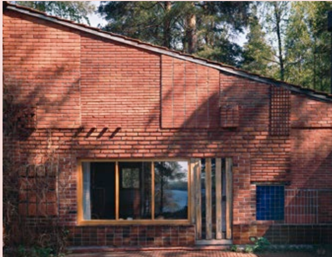
Alvar Aalto, casa experimental, Muuratsalo, Finlandia, 1952-1953. El collage de ladrillo y cerámica en el muro del patio. Los muros del patio están hechos de ladrillos desechados procedentes de la construcción del Ayuntamiento de Säynätsalo y de cerámicas especiales procedentes de otros proyectos de Aalto.
