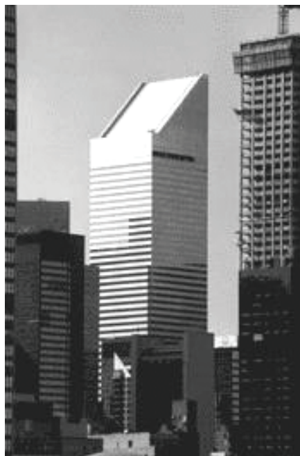
Fig. 45 b: Vista de la torre desde la ciudad
