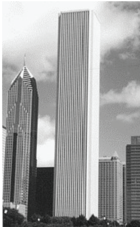
Fig. 34: Edificio Standard Oil, Chicago.
