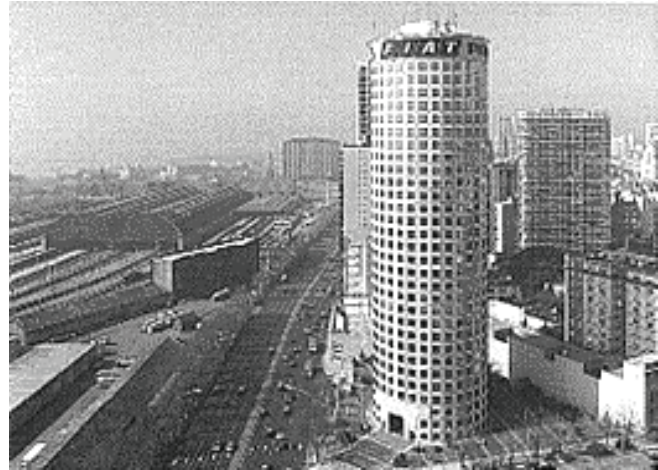
Fig. 31: Edificio Prouban, Buenos Aires.
