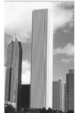
Fig 29 b: Edificio Standard Oil, Chicago.
