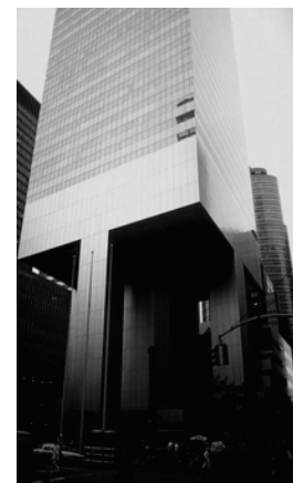
Fig. 45 c: Vista de los 4 pilares que soportan la torre.
