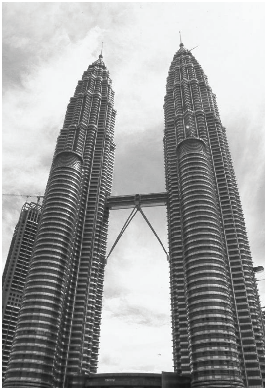
Fig. 53 b : Vista de las torres, donde puede observarse la magnitud que alcanzan ambas torres con sus 452 m. de altura, unidas por un puente conector intermedio.
