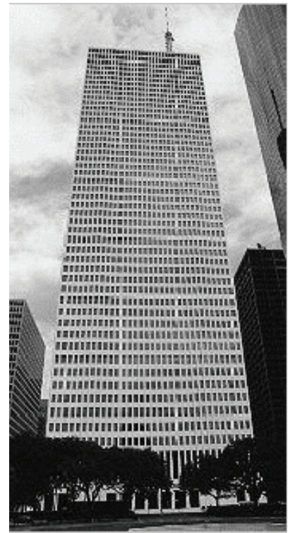
Fig. 35: Edificio One Shell Plaza.
