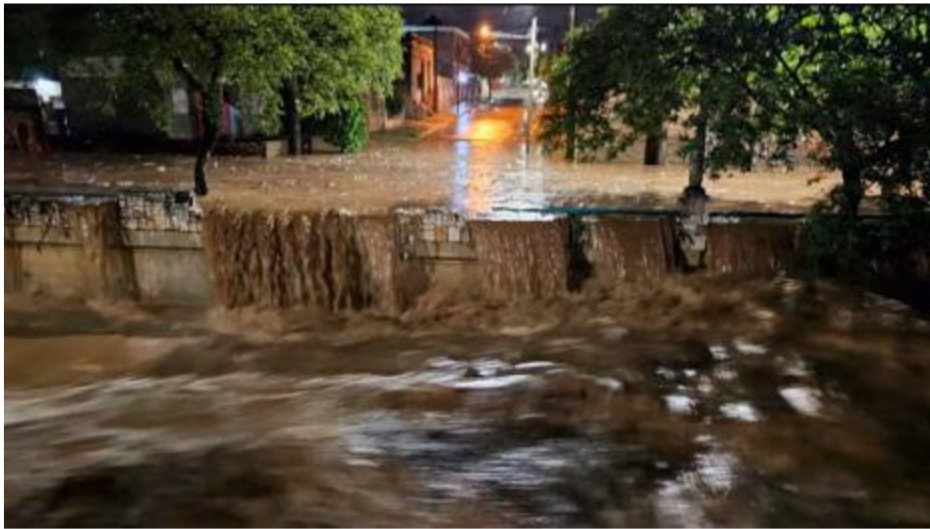
Año nuevo 2024. Desborde arroyo La cañada
