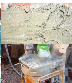
GUNITADO o PROYECTADO de mortero calcáreo
