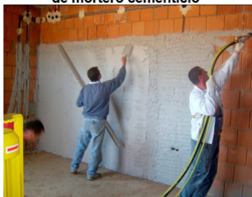
GUNITADO o PROYECTADO de mortero cementicio
