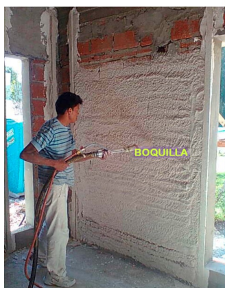
GUNITADO o PROYECTADO de mortero calcáreo
