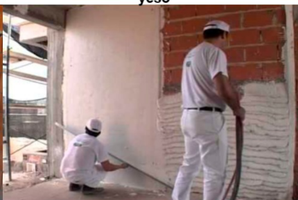
GUNITADO o PROYECTADO de mortero de yeso
