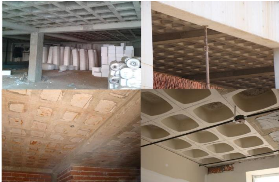
estructura de hormigón armado alivianado, losa nervurada.
