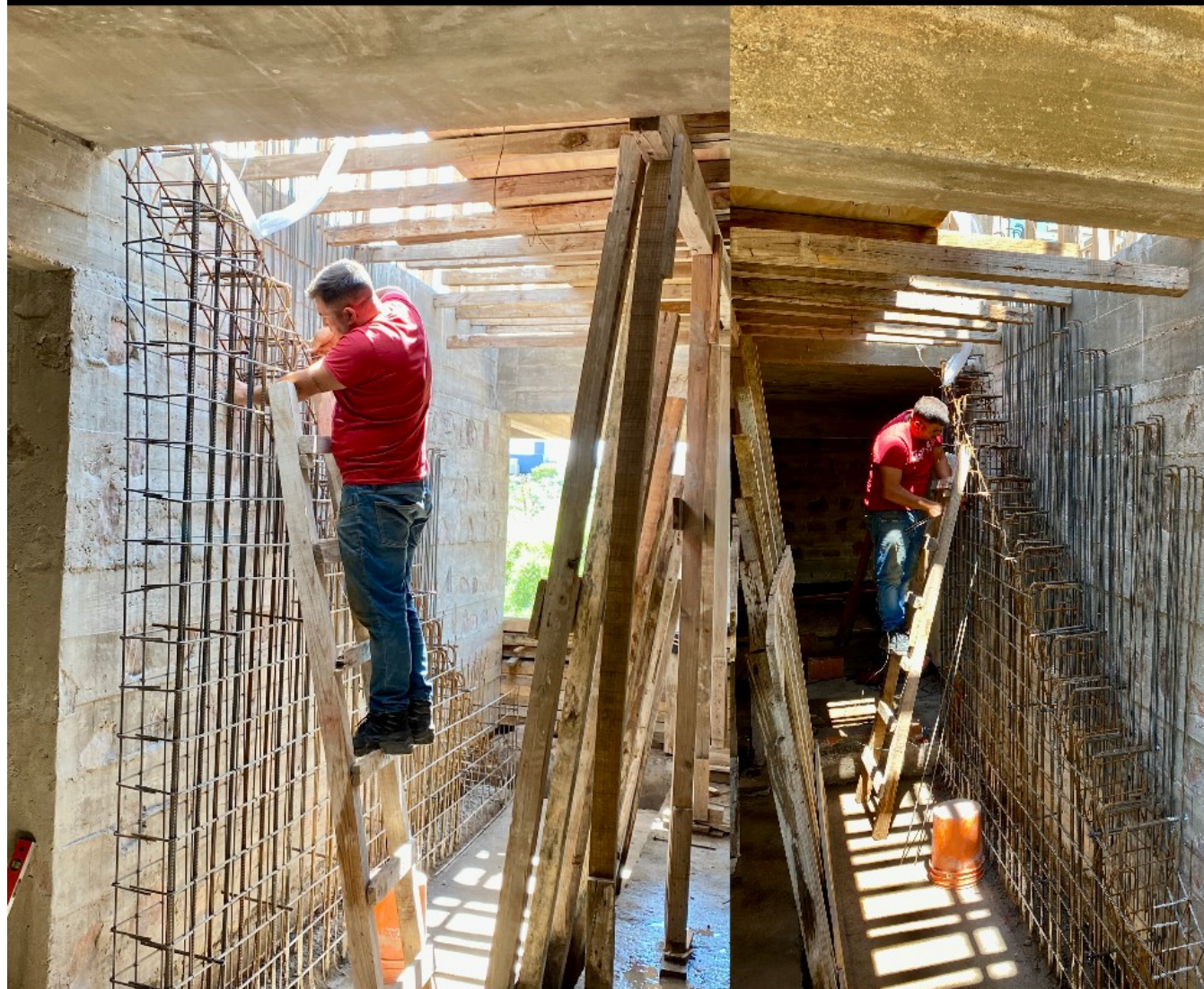
escalera empotrada- proceso de producción
