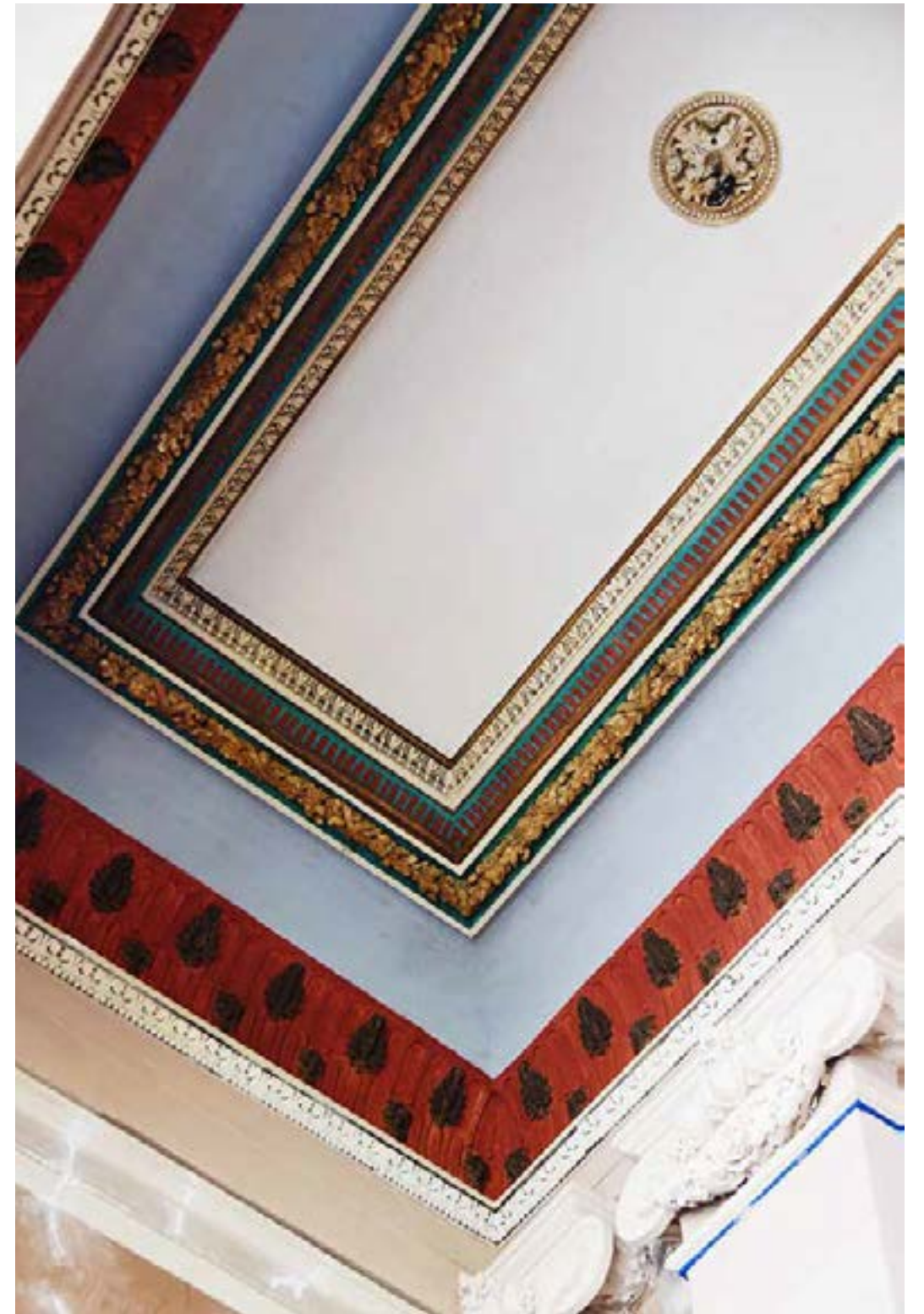
Detalle de la colorimetría recuperada en el cielorraso de la loggia superior.
