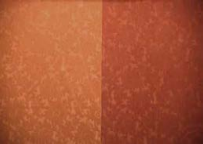
Detalles del empapelado flocado original en sus dos tonos, dispuestos de manera alternada en el perímetro de palcos y cazuelas.
