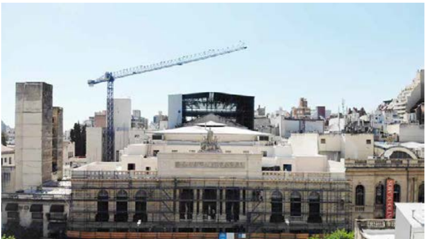
Vista frontal del teatro donde se ve en primer plano la estructura de andamios de fachada y al fondo la grúa que se montó para el armado de la estructura.
