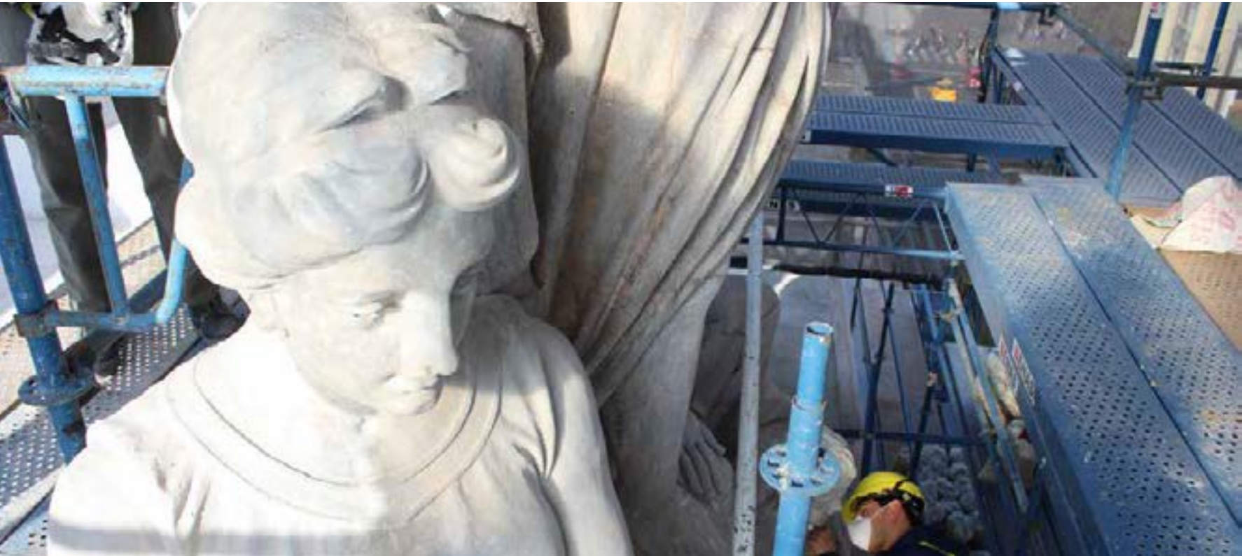
Andamios durante los trabajos de restauración en el grupo escultórico que corona la fachada.
