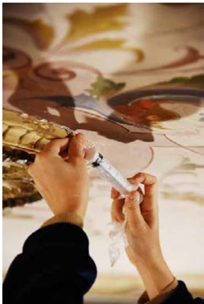
Imágenes del momento de consolidación de la capa pictórica del cielorraso del Salón de Tertulia.
