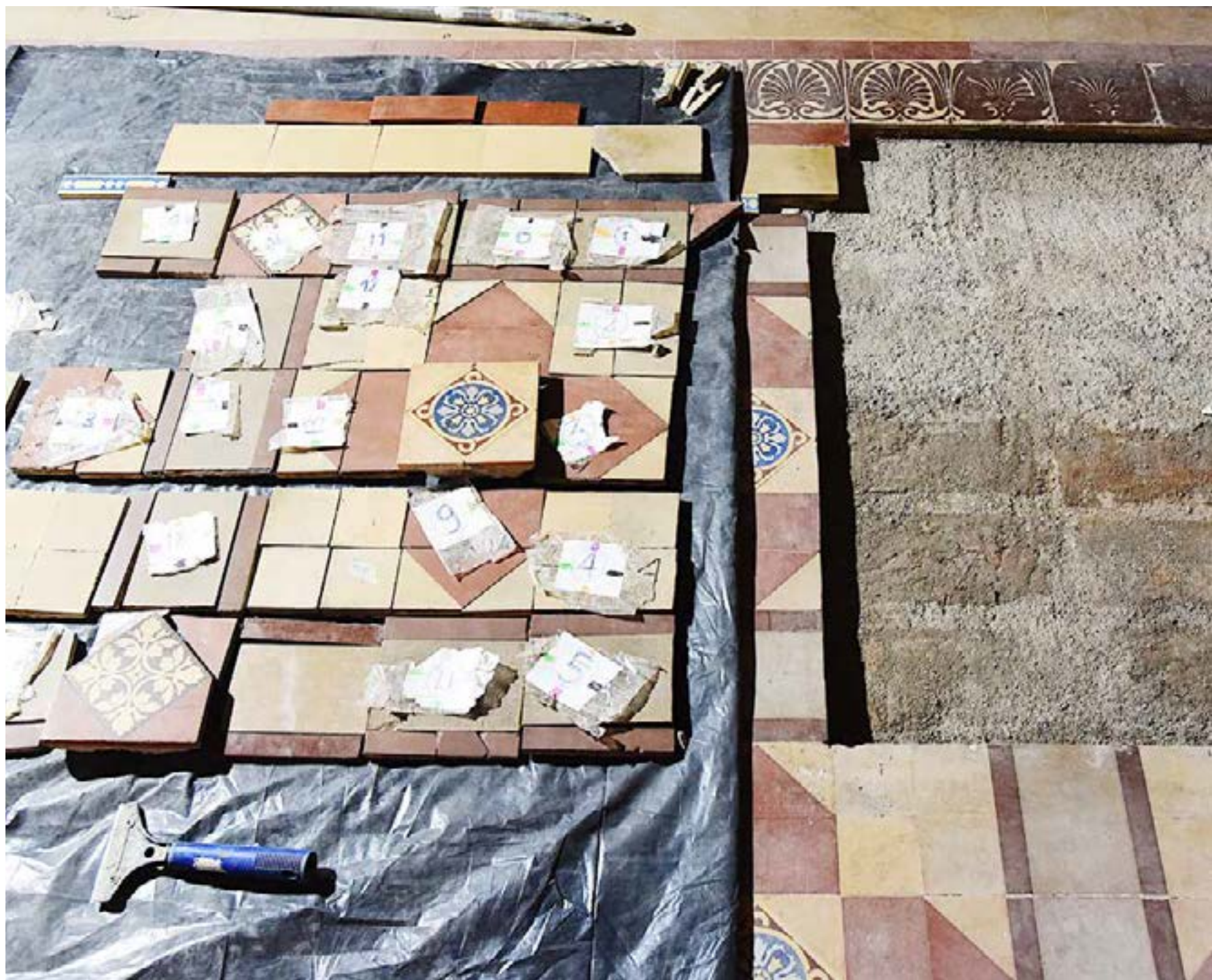
Reposición y reemplazo de cuatrocientas veintinueve piezas cerámicas en el piso del vestíbulo. Las piezas son del tipo gres1 o pasta coloreada sin esmalte.
