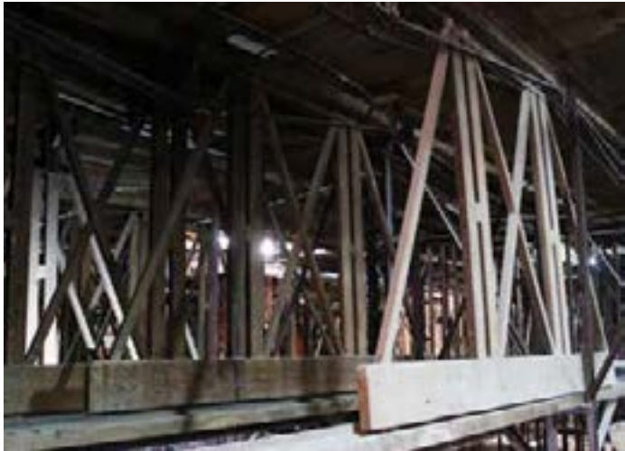
Vista de la estructara de bajo escenario. En primer plano se ven las carrozas sobre guías.
