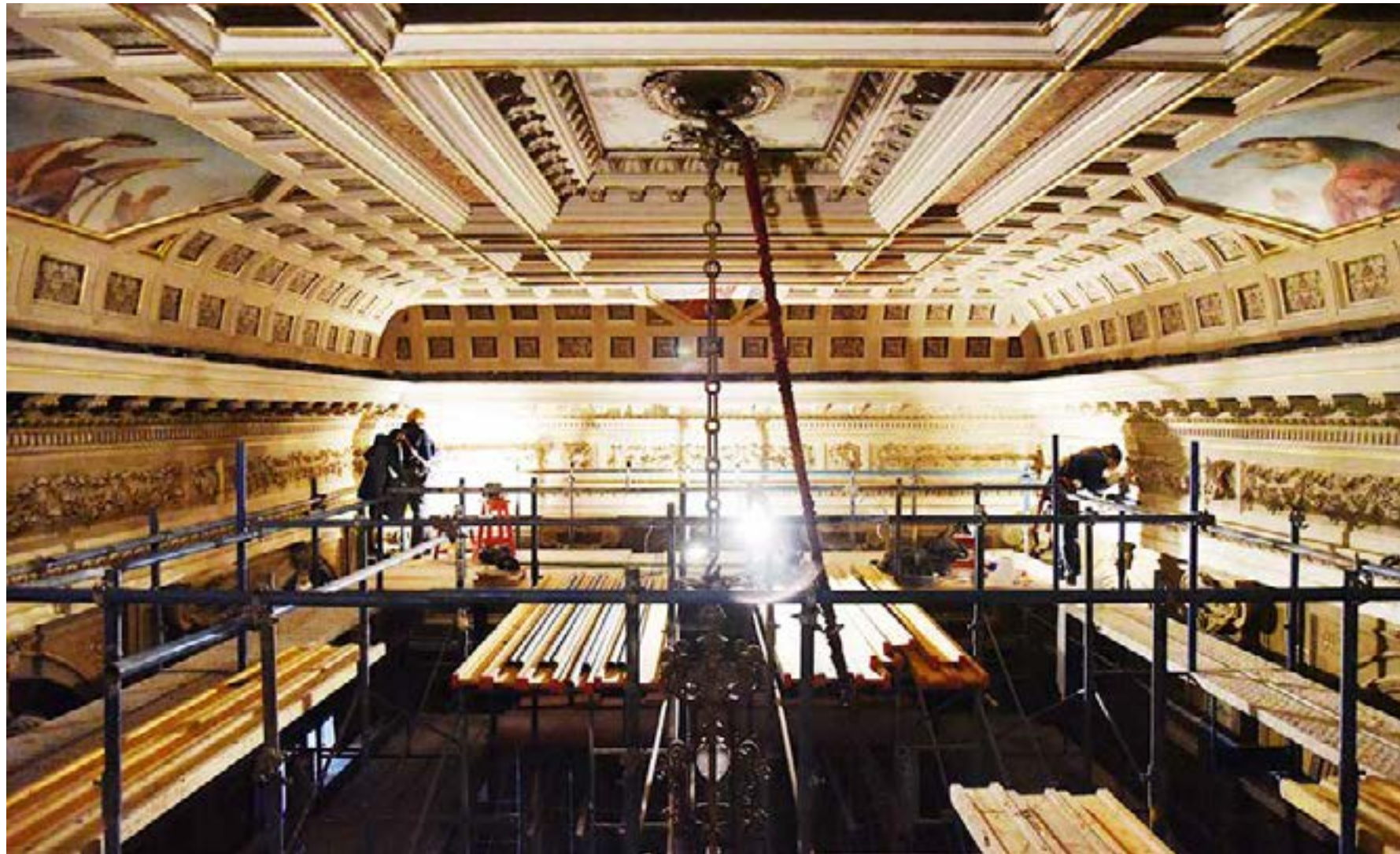
Vista del Foyer Alto durante la restauración.
