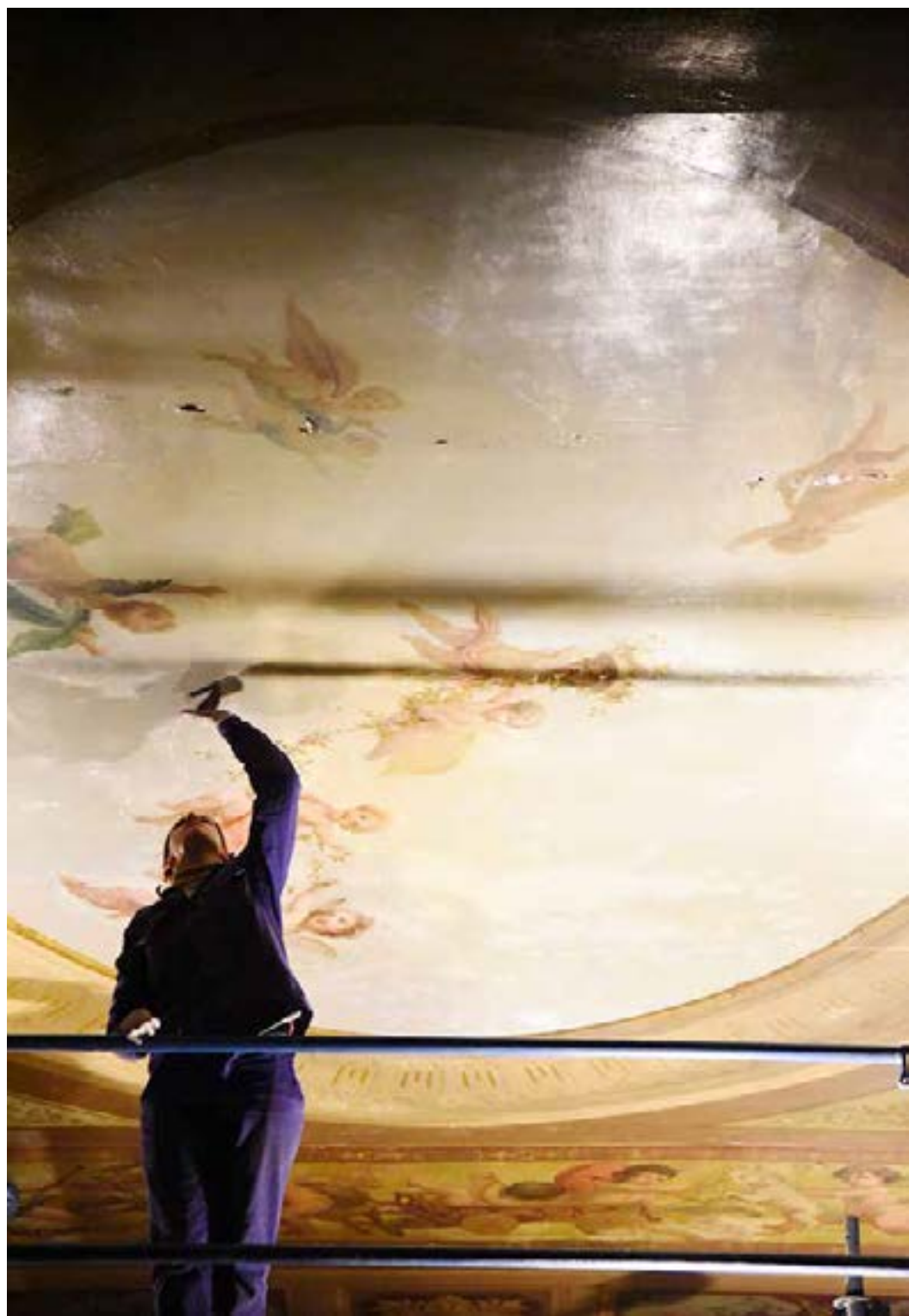
Imágenes que muestran el proceso de restauración de las pinturas del ovalo central del Vestíbulo en el cual se retiró completamente la capa de barniz envejecida.
