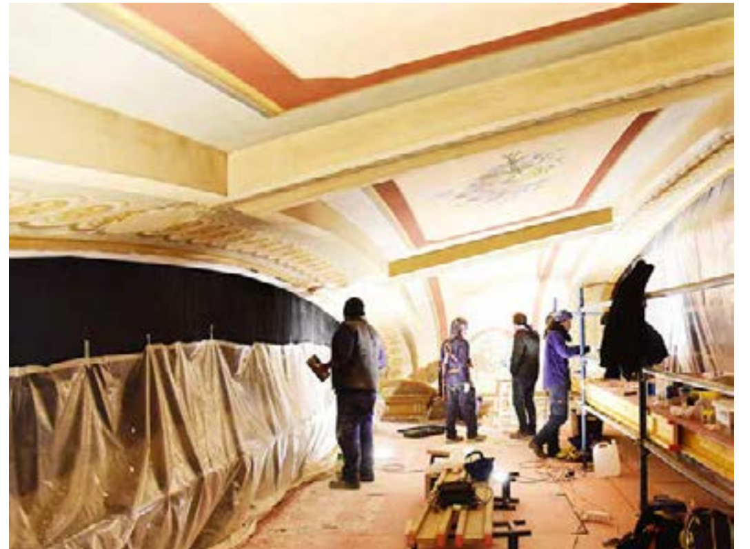
Trabajos de restauración en el arco del proscenio. Arriba: Vista general del espacio de trabajo antes que se descubrieran las pinturas originales. Izquierda: Motivo central antes de la restauración con cateos que descubren los motivos originales. Abajo: Motivo recuperado que revela instrumentos musicales, partituras y una cinta con la bandera argentina. Se descubrió una policromía distinta, el trabajo fue realizado a mano, con bisturíes como única herramienta.
