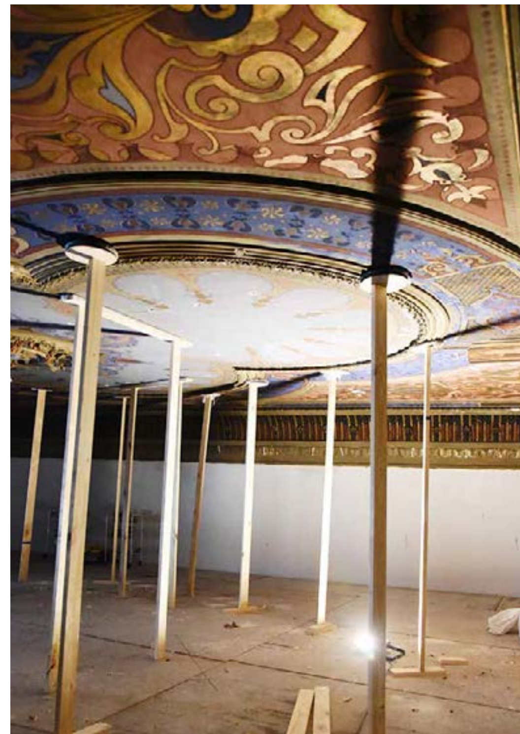
Izquierda: Apuntalamiento del cielorraso del Salón Turco para su consolidación, se pueden ver los entablillados de soporte del yeso. Derecha: Trabajos en el Salón Japonés. Arriba se puede ver el momento en que se repara el yeso y abajo una vista general del espacio de trabajo.
