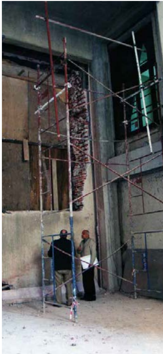
Imagen de la obra, apertura del muro original para la conexión del edificio Guastavino con el puente de maniobra.
