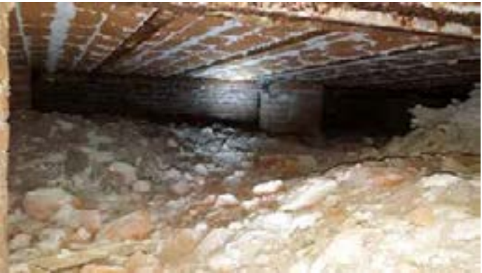
Arriba izquierda: Toma de mediciones y estudio de suelo en el Vestíbulo. Derecha: Vista de la estructura de sostén del piso del Vestíbulo, con perfiles Normales y bovedillas.
