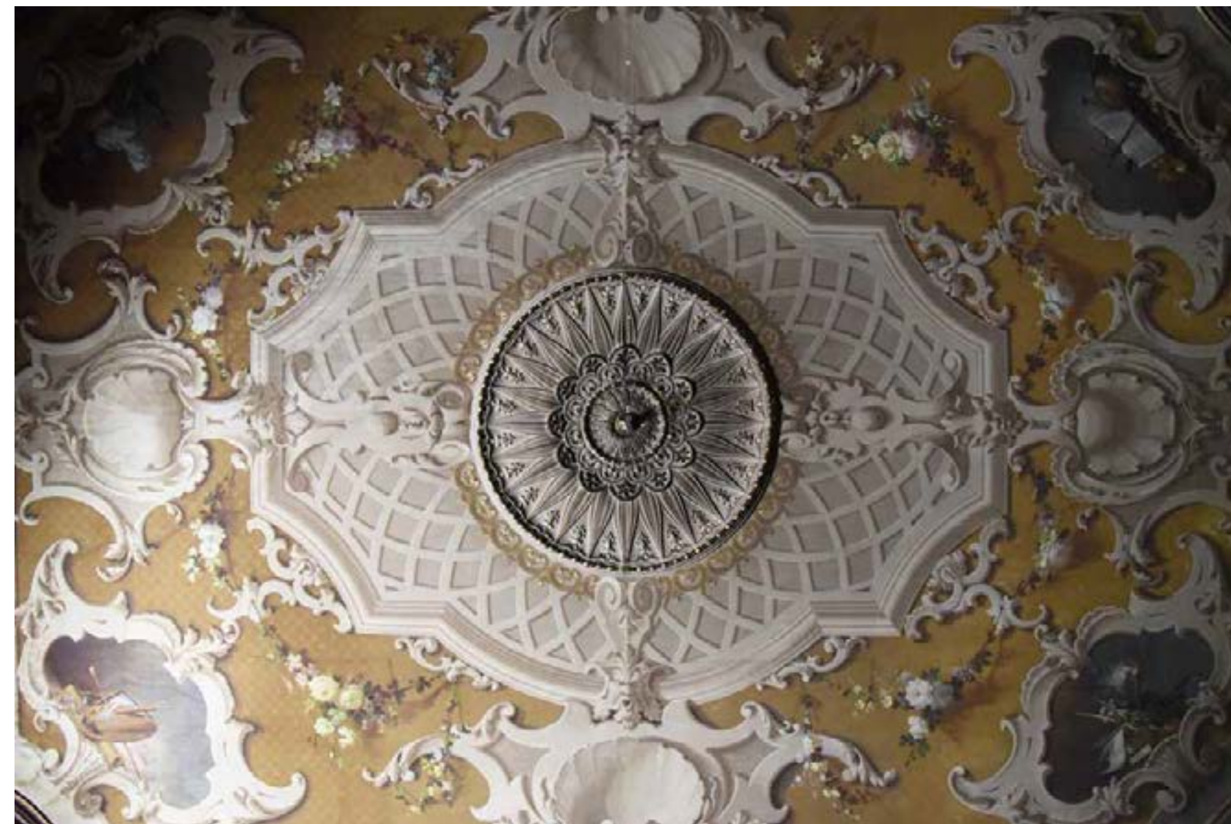
Cielorraso de la Sala Barroca en planta baja, esta sala es parte del Museo de la Música "Cristóbal Aguilar" (n.º local 0-12).
