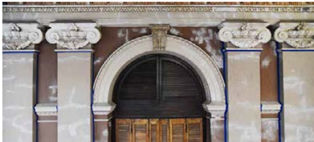
Arriba: Restauración de la loggia superior. Abajo: Vista frontal de un sector del muro de la loggia superior durante las tareas de sellado de grietas y consolidación.
