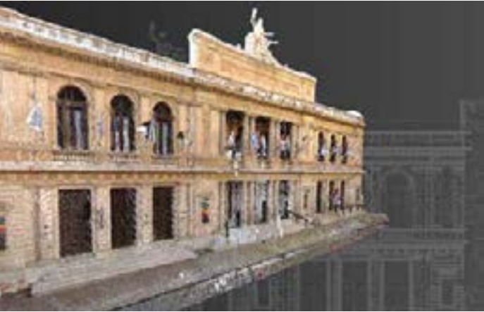
Arriba: Imagen del relevamiento con escáner laser de la Sala, a partir del escaneo se realizaron otras piezas gráficas. Abajo: Escaneo de la fachada.
