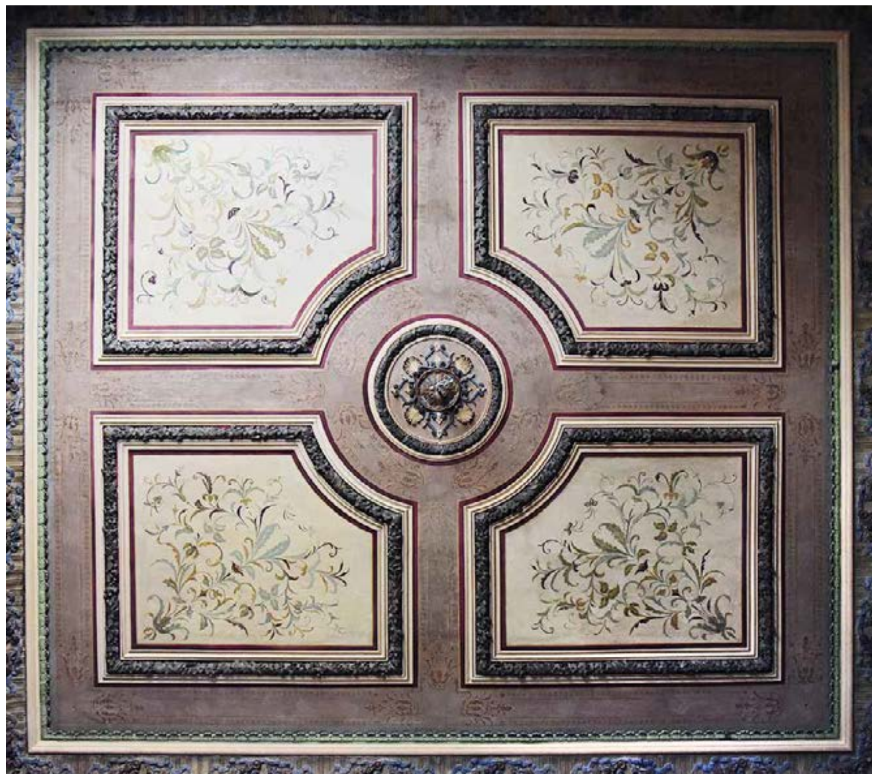
Cielorraso de la Boletería Norte en planta baja (n.º local 0-03).
