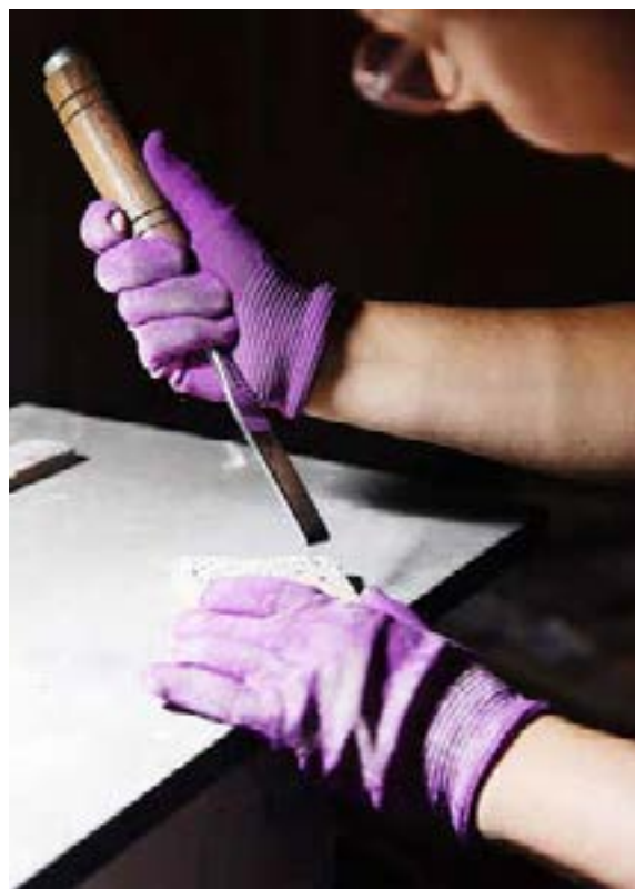
Las piezas de reposición fueron colocadas de forma manual. En primera instancia se debió remover el paño original para colocar las piezas nuevas dentro del diseño del módulo. Al final se colocaron de a una las piezas rearmando el paño.
