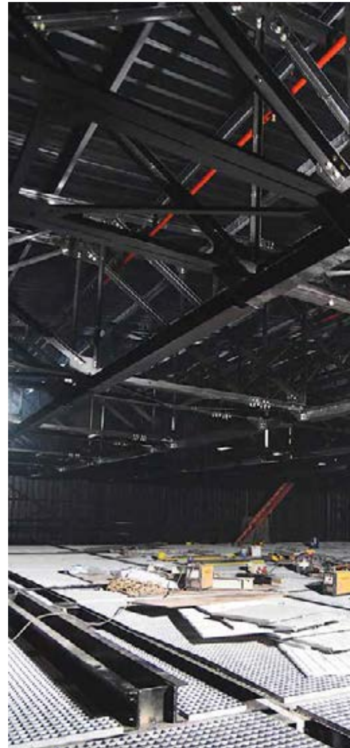
Izquierda: La nueva parrilla y cubierta metálica abulonada en el momento de su armado.
