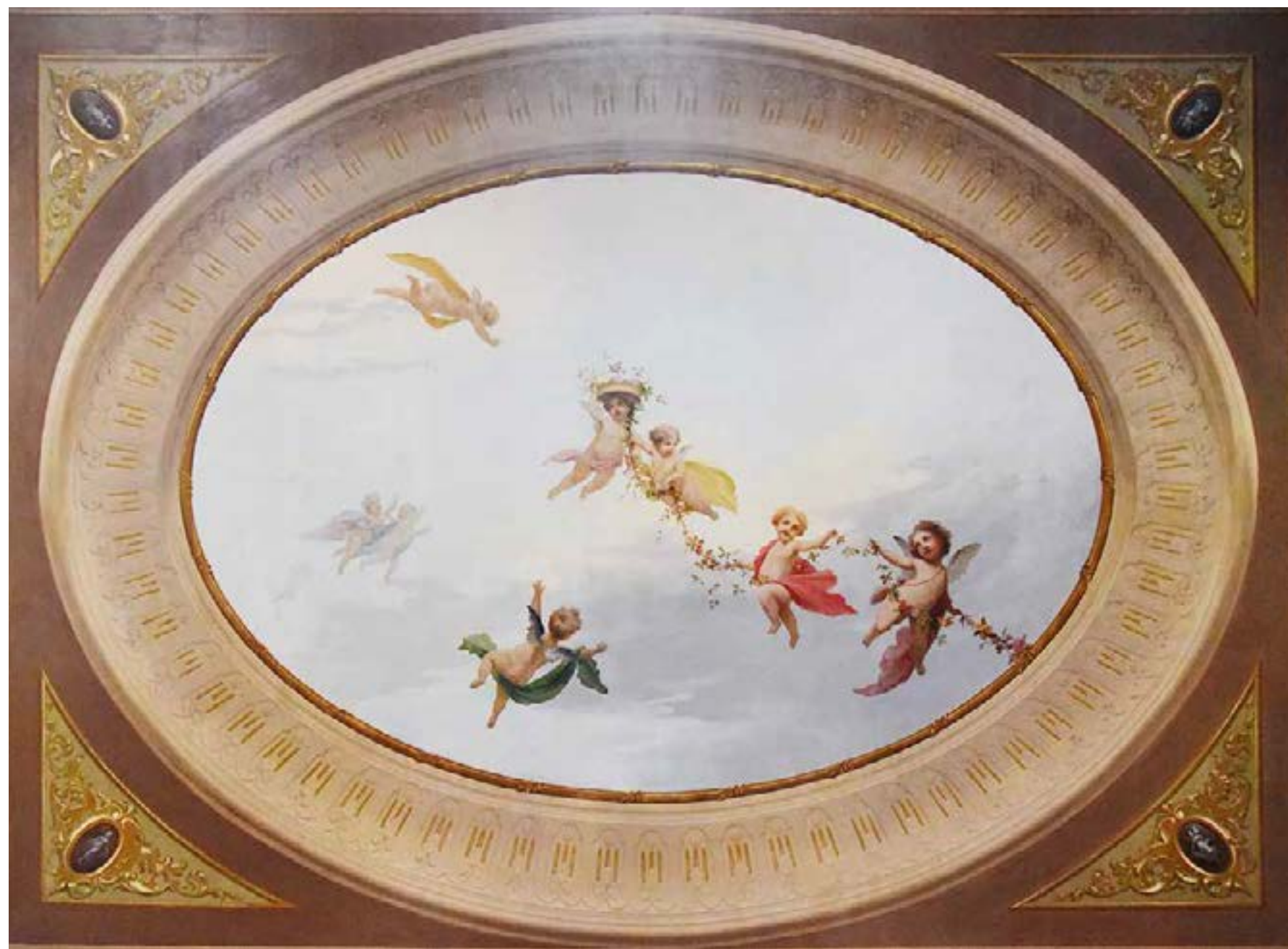
Gran óculo central del cielorraso del Vestíbulo (n.º local 0-07).
