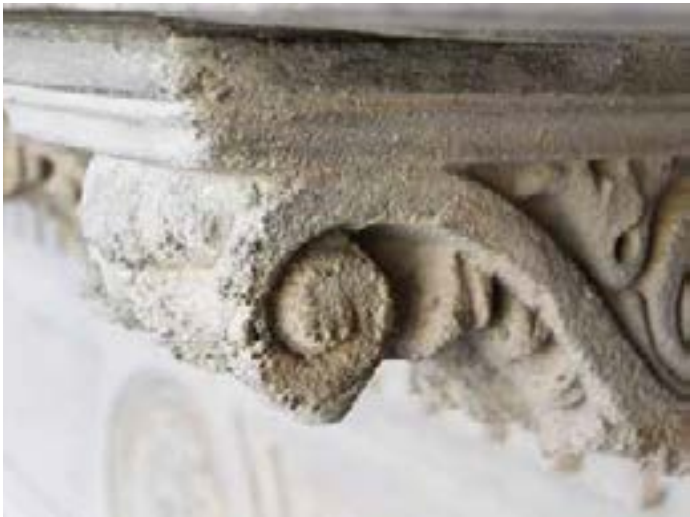
Escorzo de la fachada y los andamios vista desde la altura de los capiteles. Derecha arriba y al centro: Detalle de los capiteles realizados en cocciopesto en el estado que se encontraban al inicio de la obra. Abajo: Detalle del estado de las ménsulas ubicadas bajo la cornisa superior al inicio de la obra. Nótese el estado de degradación propio de limpiezas invasivas.
