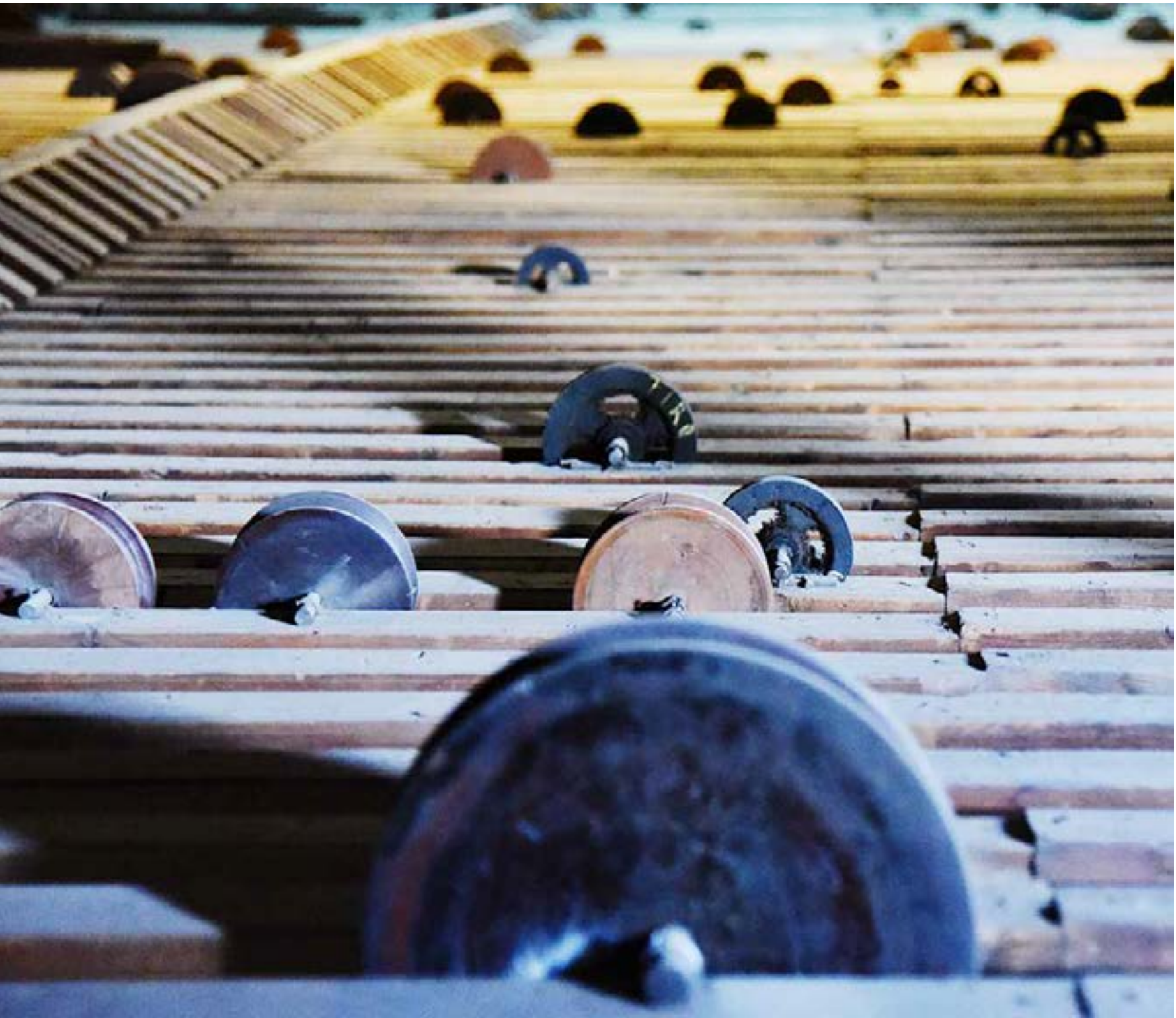
Vista en detalle de las poleas originales colocadas en parrilla.
