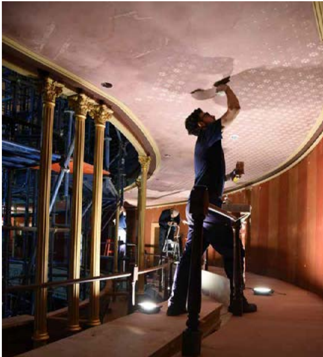
Restauración de estarcido en el cielorraso de Cazuela. En esta foto se puede apreciar el empapelado flocado original en el muro, luego protegido por terciopelo.
