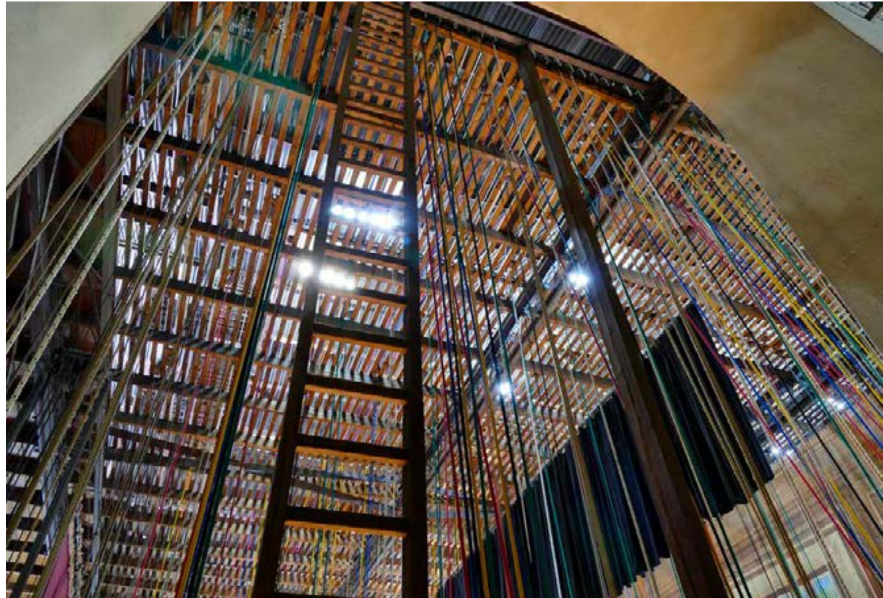
Vista de la parrilla, escalera marinera y bambalina desde el segundo puente de maniobra.
