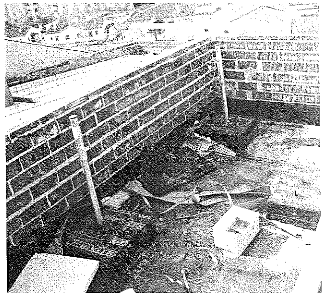
Figura 7.34. Colocación de bases de anclaje para antenas antes de la impermeabilización
