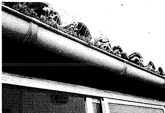
Figura 6.14. Actividades de mantenimiento. Limpieza de cubierta y canalones
