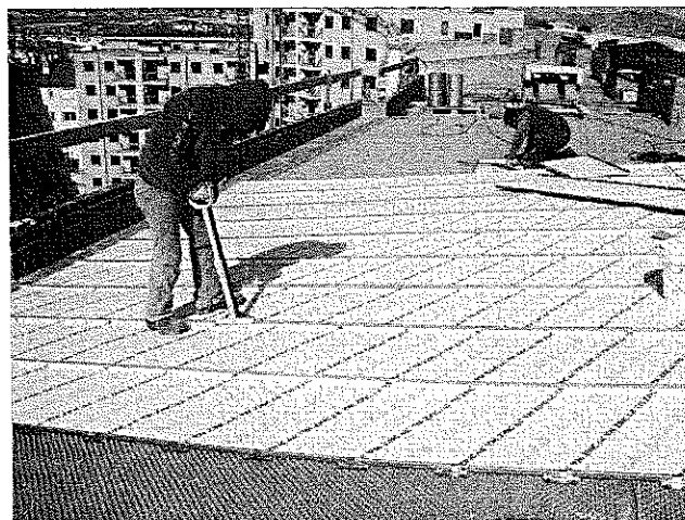
Figura 6.25. Mantener la cubierta limpia durante la ejecución de los trabajos
