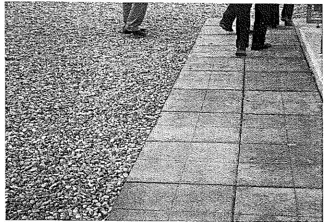
Figura 3.24. Cubierta de grava con pasillos para mantenimiento
