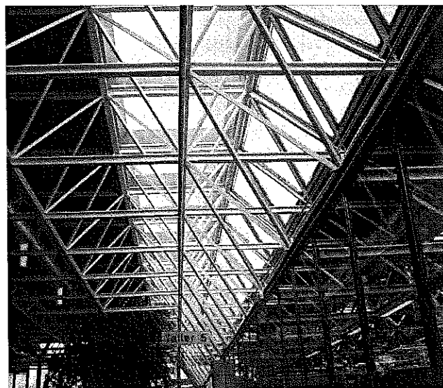
Figura 5.1. Elementos de iluminación cenital
