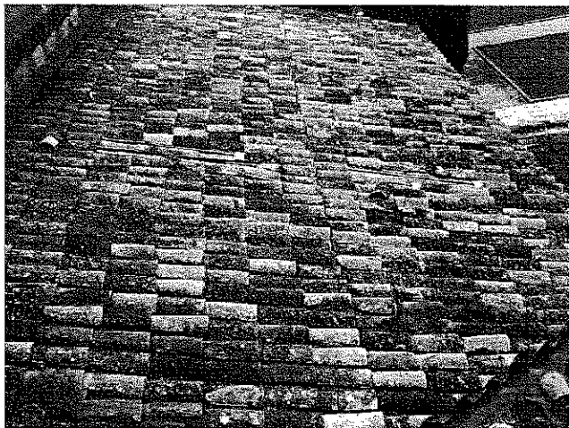
Figura 6.15. Actividades de mantenimiento. Restitución de la cubierta
