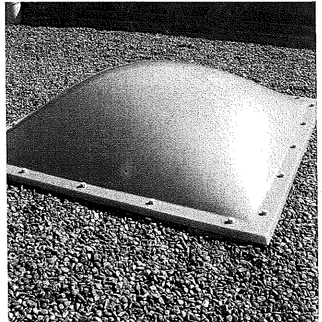
Figura 5.4. Claraboya de polimetacrilato de bajo factor solar
