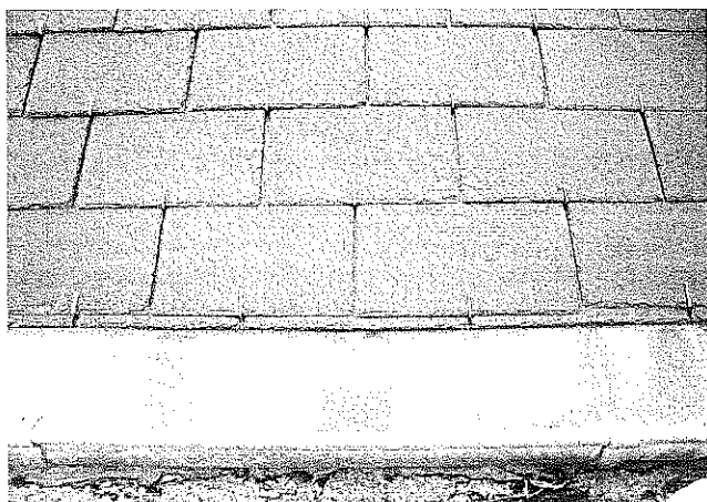
Figura 4.21. Fijación de pizarras mediante ganchos
