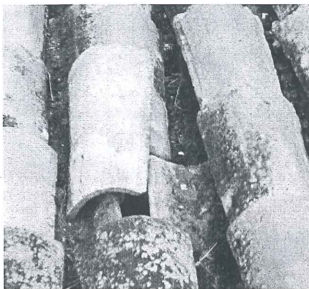
Figura 7.47. Lesiones de la cobertura. Desplazamientos
