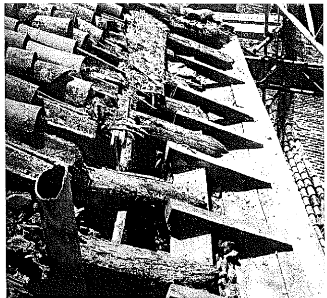
Figura 1.11. Pudrición de vigas de madera
