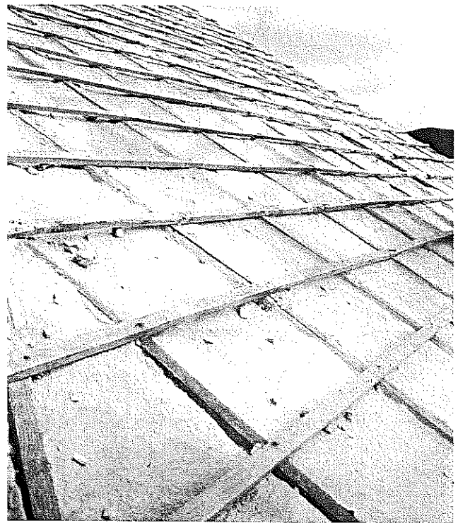
Figura 4.65. Doble capa de rastreles de madera
