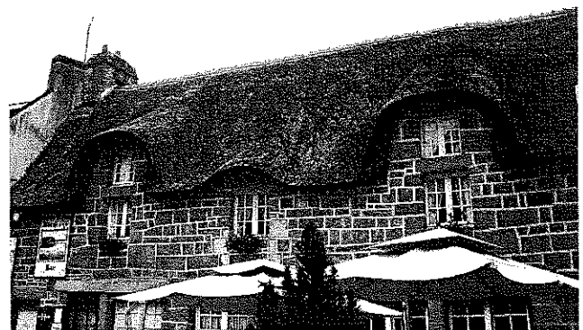
Figura 2.1. Cubierta de paja
