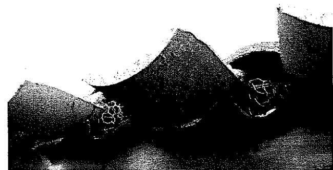
Figura 7.84. Proceso de sustitución total de cubierta. Colocación de la cobertura y ventilación alero
