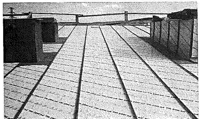
Figura 4.34. Junta alzada
