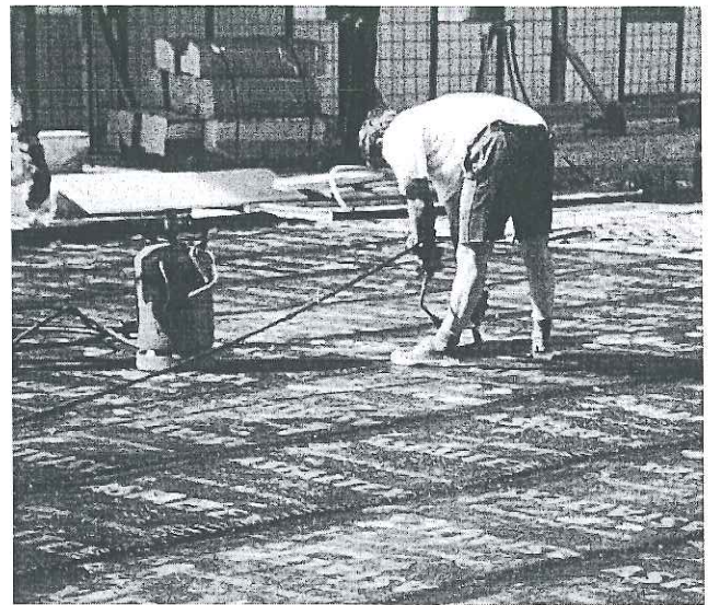
Figura 2.7. Impermeabilización de cubiertas horizontales
