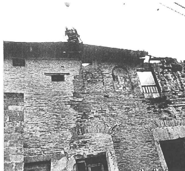
Figura 7.80. Proceso de sustitución total de cubierta. Desmontaje de alero
