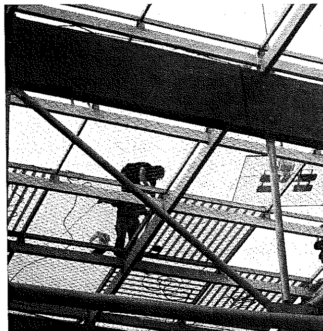
Figura 5.27. Colocación de vidrios de seguridad en lucernarios
