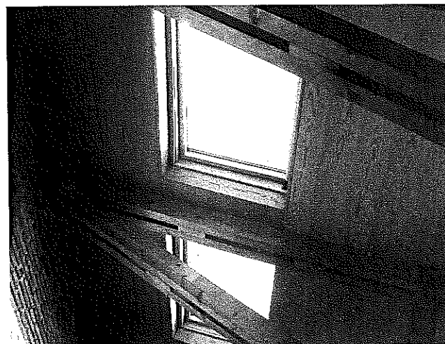
Figura 5.8. Junta entre lucernario y parte opaca de la cubierta
