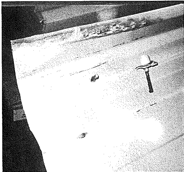
Figura 1.10. Corrosión electroquímica de una placa de aluminio en cubierta
