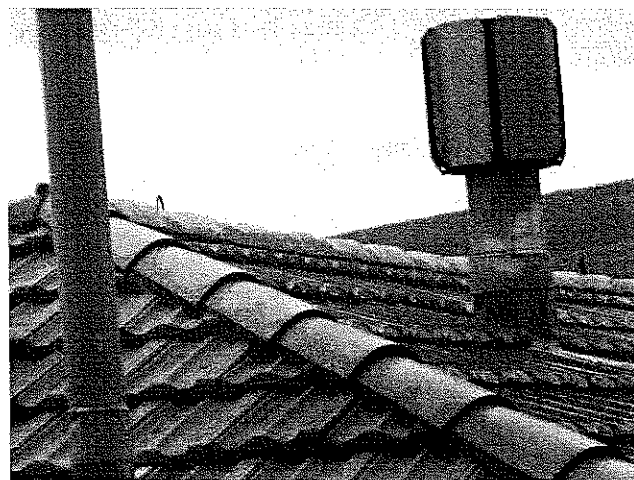
Figura 6.17. Ganchos de seguridad en cubiertas inclinadas
