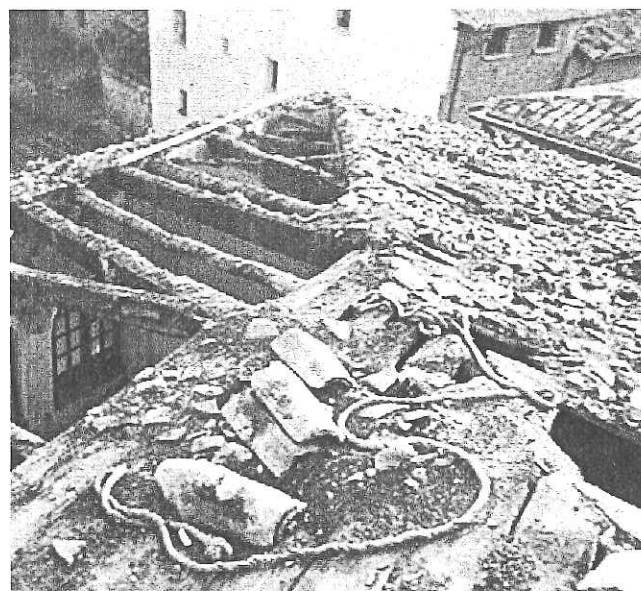
Figura 7.79. Proceso de sustitución total de cubierta. Desmontaje de cubierta
