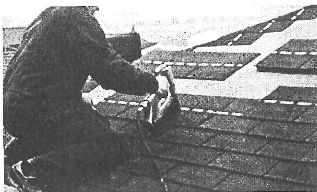
Figura 4.26. Colocación de placas asfálticas
