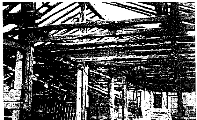
Figura 7.41. Acción del fuego en una estructura de madera. Comprobación de sección afectada
