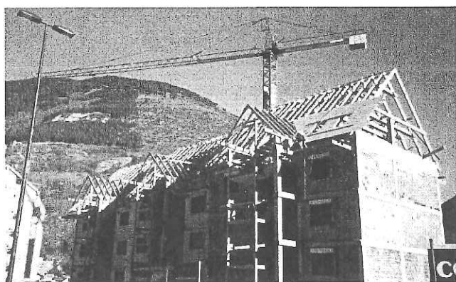
Figura 4.85. Estructura discontinua de madera aserrada
